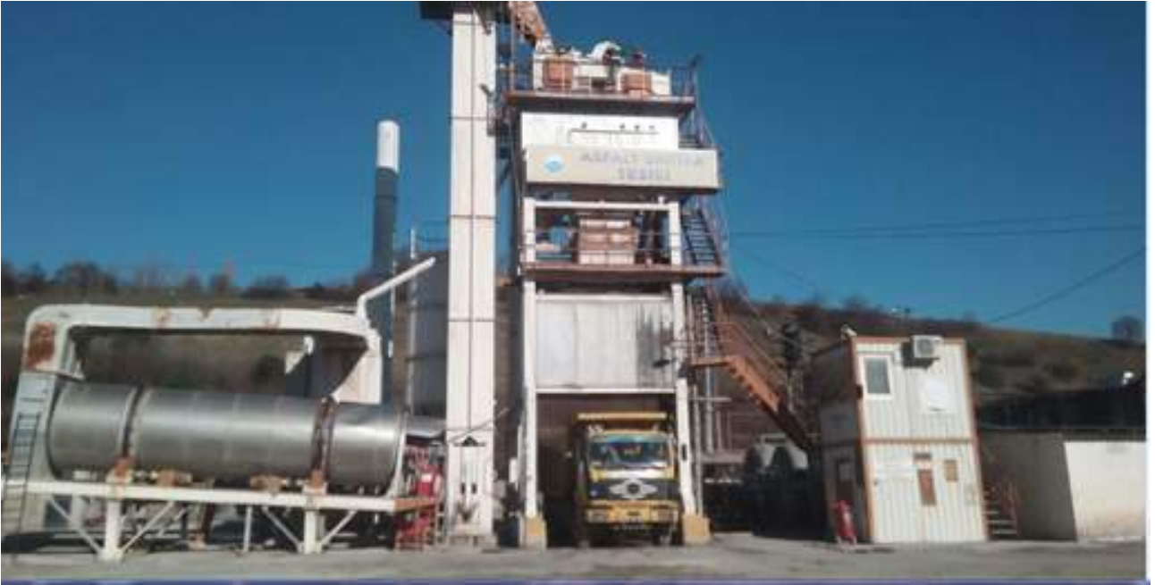
Derebahçe Asfalt Plenti Ve Stok Sahası
