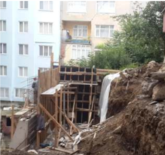
Liman Mah.Şair Nedim Sok.Betonarme Perde Duvar Yapım İşimiz
