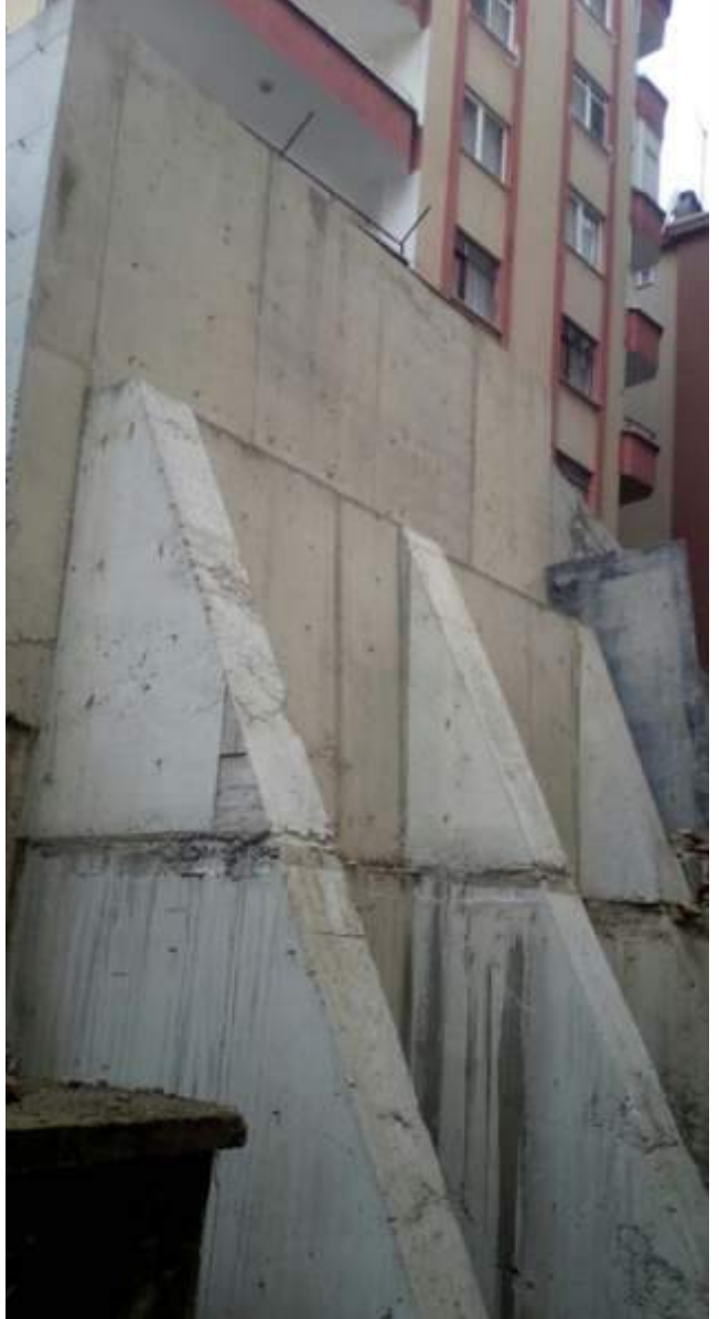
Liman Mah.Şair Nedim Sok.Betonarme Perde Duvar Yapım İşimiz
