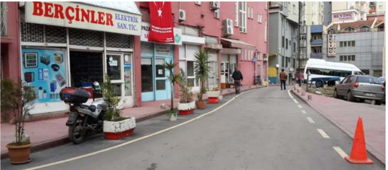
Pazar Mah.Medrese Sok. Renkli Kaldırım Beton ve Asfalt Kaplama
