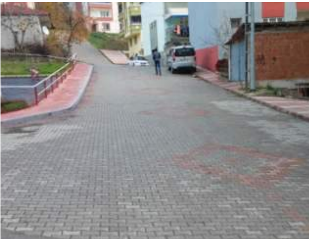
Kışla Mah. Yeşilyazı Sokak. Renkli Kaldırım Betonlama
