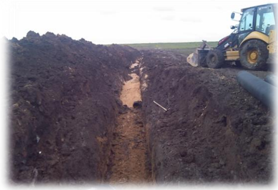
ANAFARTALAR SOKAK YAĞMURSUYU HATTI DÖŞEME ÇALIŞMASI
