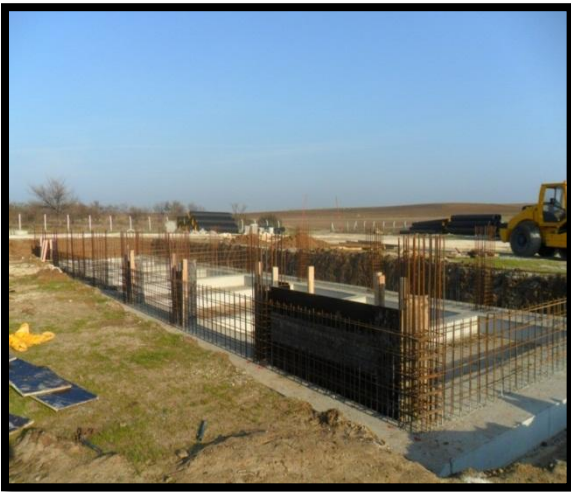
Blower ve Trafo Binası Temeli
