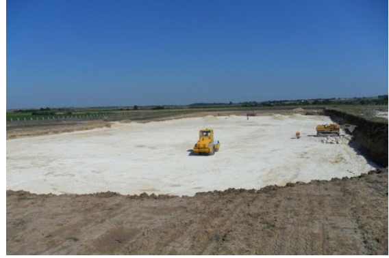
Havalandırma Tankları Temel Altı Dolgusu
