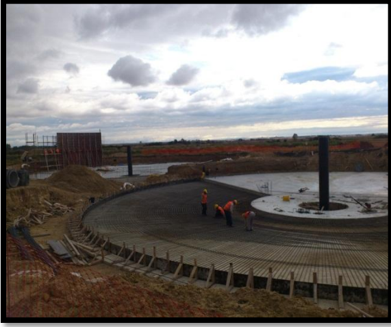
Son Çökeltme Tankları Demir ve Kalıp Çalışması
