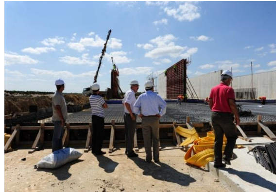
Havalandırma Tankları Beton Dökümü
