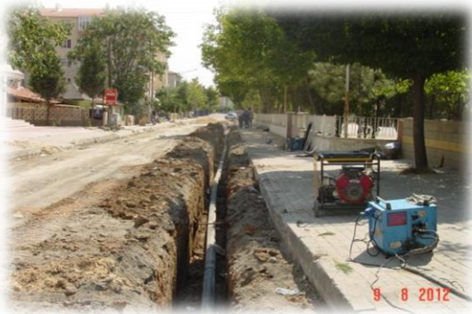
ALAN SOKAK İÇMESUYU ANA HATTI
