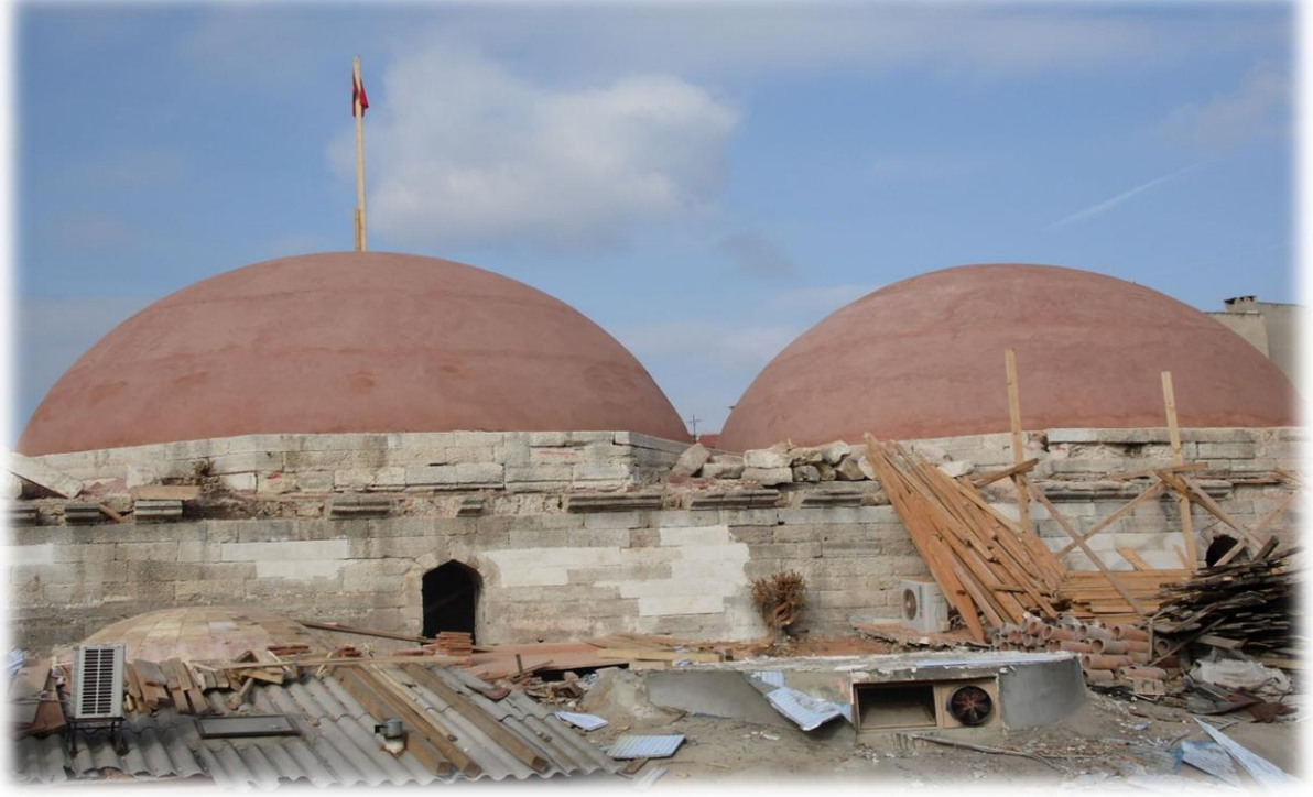
SOKULLU HAMAMI RESTARASYONU
