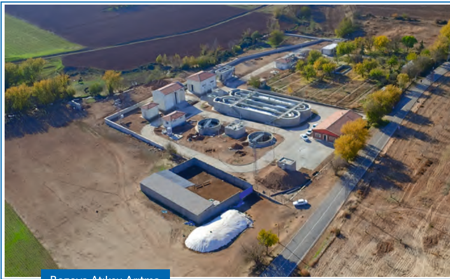
Bozova Atıksu Arıtma
