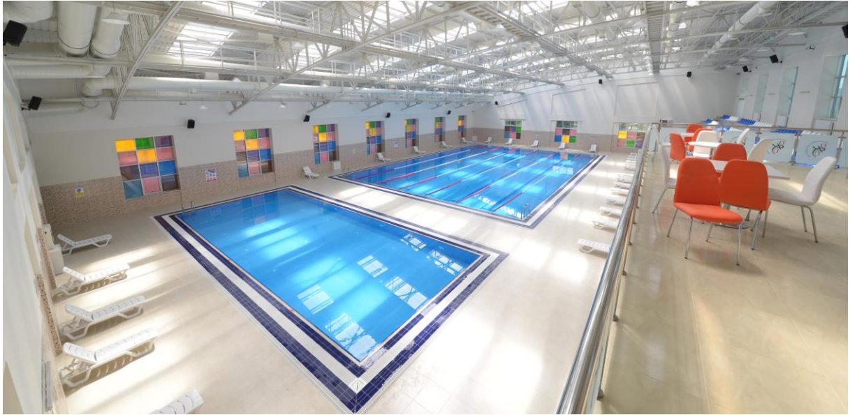
Resim 4: OKÜ Kapalı Yüzme Havuzu İç Görünümü
