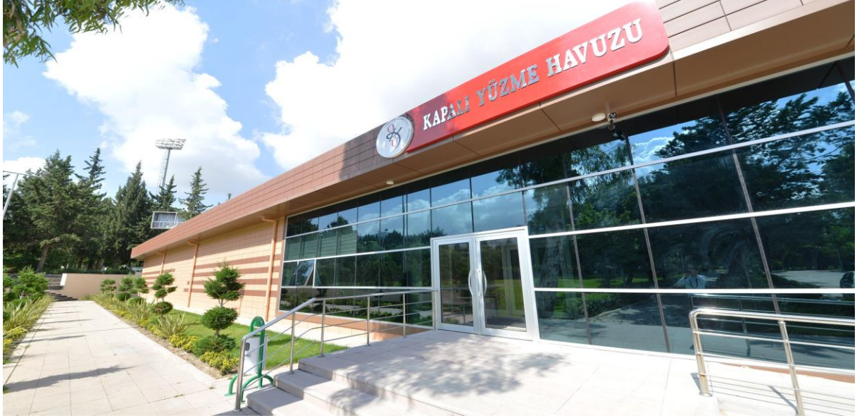
Resim 3: OKÜ Kapalı Yüzme Havuzu Dış Görünümü
