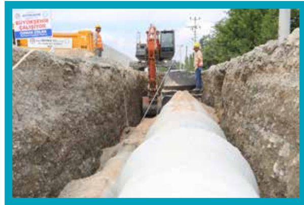
Honaz İlçesi Haydar ve Yenimahalleleri Yağmursuyu ve Kanalizasyon Hatları Yapımı
