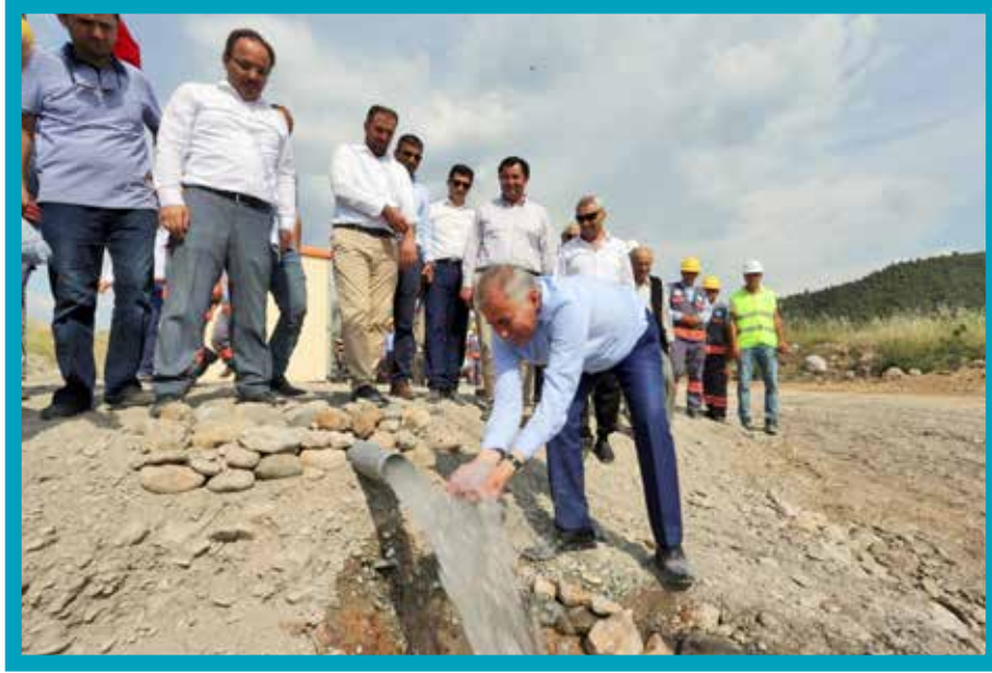
Honaz İlçesi Kocabaş Mahallesi
