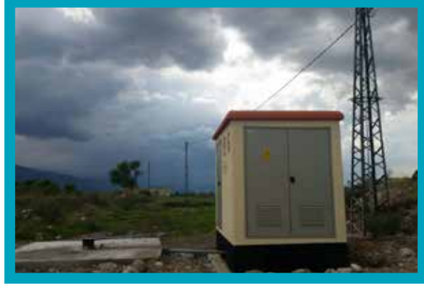
Yeni Açılan Sondaj Kuyusu için Enerji Hattı Çekilmesi ve Yeni Kabin Montajı
