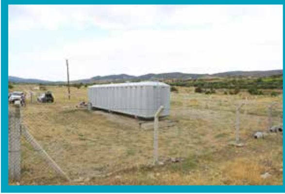
Oğuz Paket Atıksu Arıtma Tesisi
