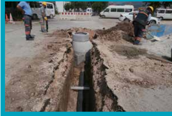
Kayıhan Mahallesi Kanalizasyon Hattı İmalatı
