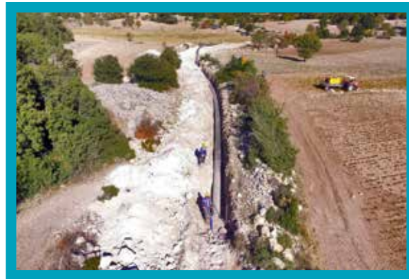
Güney İlçesi Haylamaz Mahallesi İçmesuyu Hattı İmalatı
