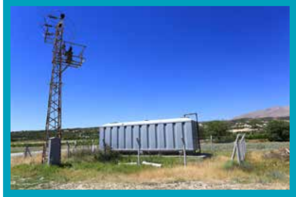
Mahmutgazi Paket Atıksu Arıtma Tesisi
