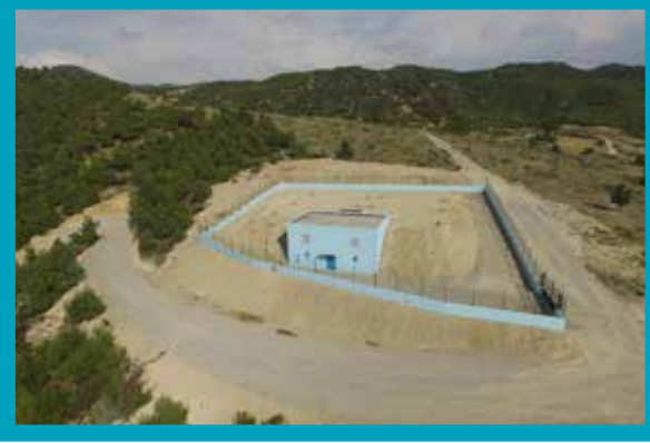
Honaz İlçesi Kocabaş Mahallesi 2.000 m 3 İçmesuyu Deposu
