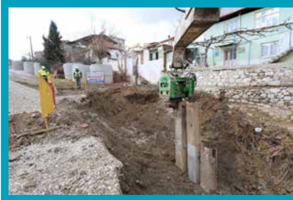
İlbade Mahallesi Yağmursuyu Şebekesi İmalatı
