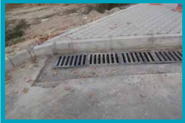
Korucuk Mahallesi Izgara Hattı Yapımı
