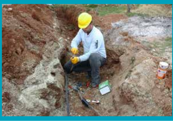
Kazı Esnasında Kopan Kablo Tamiri
