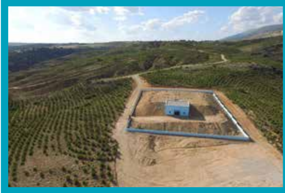
Çivril İlçesi İğdir Mahallesi 5.000 m 3 İçmesuyu Deposu
