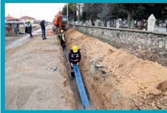
Çivril İlçesi Karalar Mahallesi 120 m Ana Şebeke İçmesuyu Hattı Yapımı
