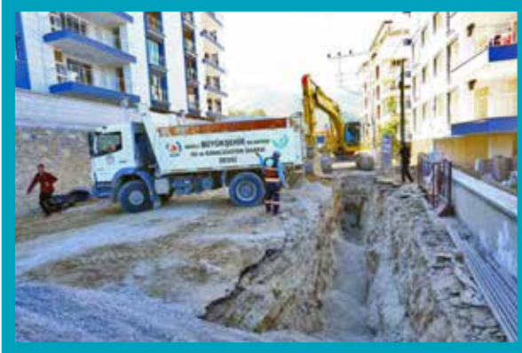
Babadağ İlçesi Merkez 800 m Kanalizasyon Hattı Yapılması
