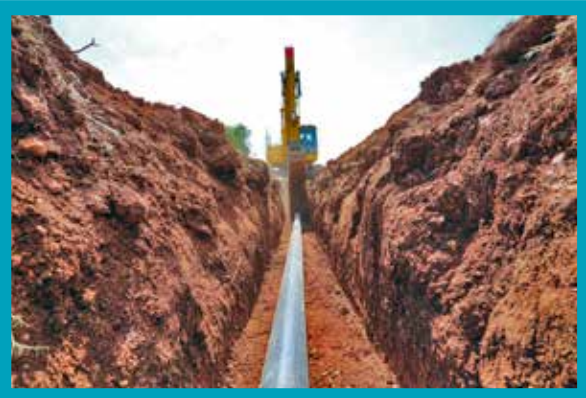
Tavas Sariabat Mahallesi 5.600 m İçmesuyu İsale Hattı Yapımı
