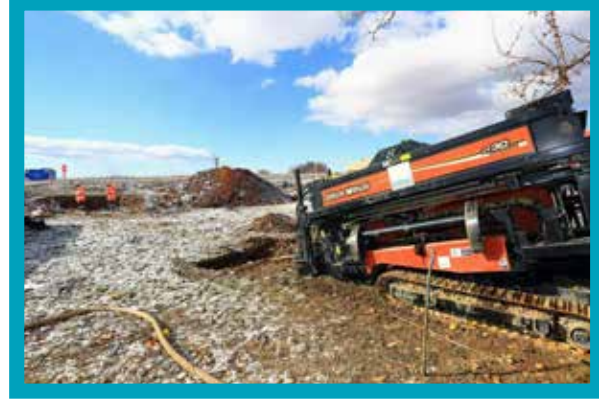
Acıpayam İlçesi Yatay Sondaj
