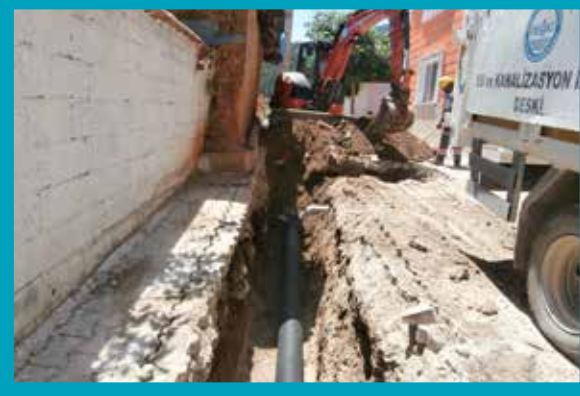
Başkarcı Mahallesi Kanalizasyon Hattı İmalatı
