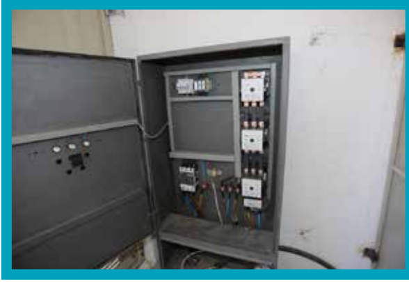
Elektrik Pano Yenileme İşlemi
