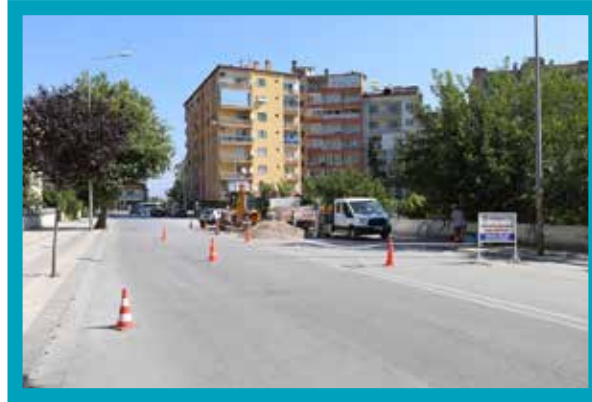
İncilipınar Mahallesi Abone Şube Yolu Hattı Değişimi
