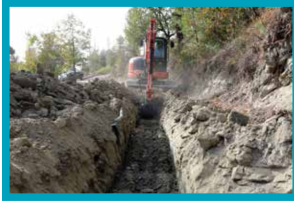
Enerji Nakil Hattı Yapımı İşi
