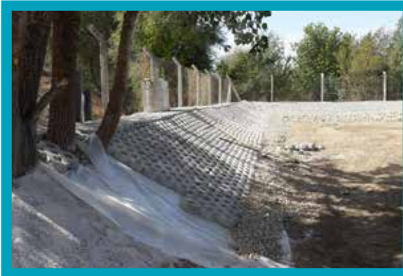
Alikurt Doğal Atıksu Arıtma Tesisi Şevlere Çim Taşı Döşenmesi
