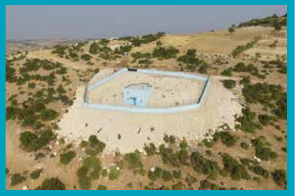
Pamukkale İlçesi Güzelpınar Mahallesi 1.000 m 3 İçmesuyu Deposu
