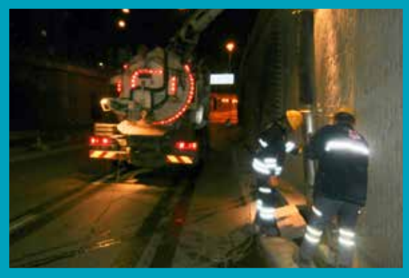
Fatih Mahallesi Köprülü Kavşağı Altı Geçitlerde Yağmursuyu Izgaralarının Temizlenmesi
