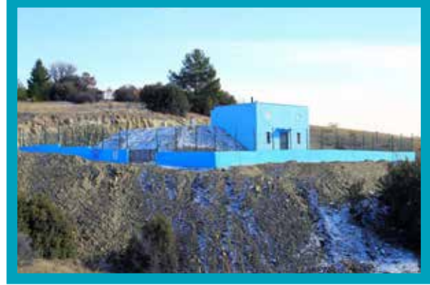
Bekilli İlçesi Merkez Mahallesi İçmesuyu Deposu
