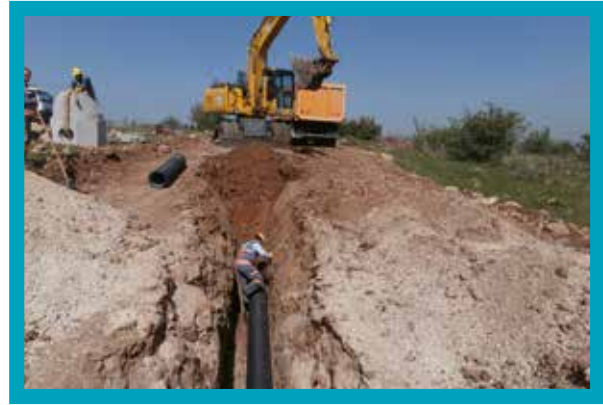
Karahasanlı Mahallesi Kanalizasyon Hattı İmalatı
