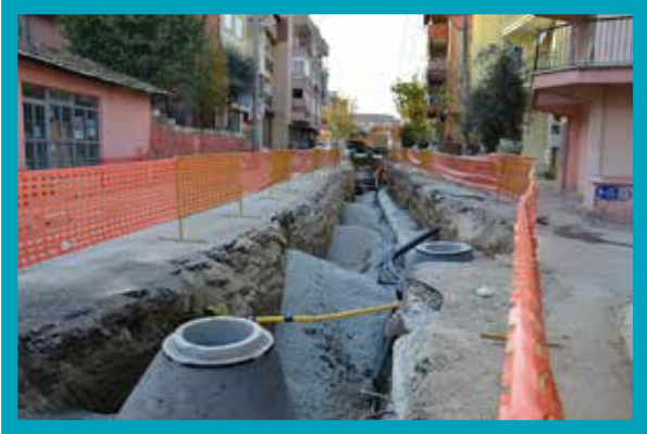
Eski Karcı Yolu Atıksu ve Yağmursuyu Şebekesi İnşaatı
