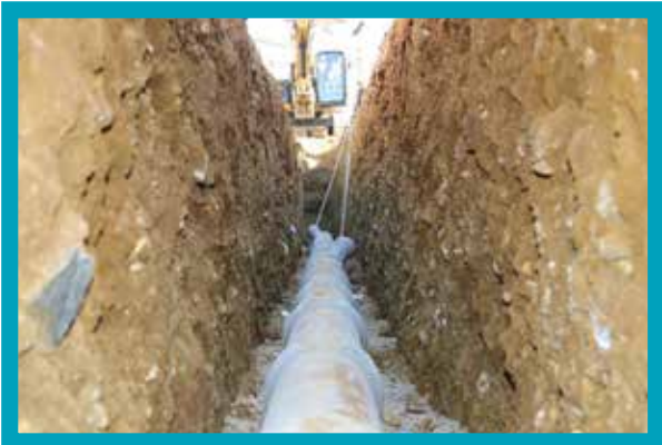
Karaman Mahallesi Atıksu Şebekesi İmalatı
