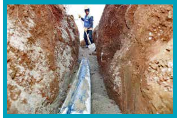
Tavas İlçesi Kızılca İçmesuyu Hattı Yapım İşİ
