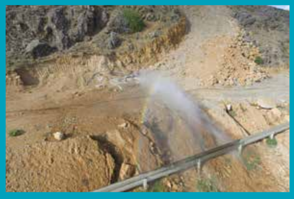
Çivril İlçesi Koçak Mahallesi Sondaj Kuyusu Pompa Tecrübesi
