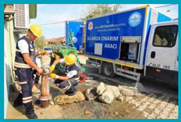
Çardak İlçesi Beylerli Mahallesi Hidrant Tamirâtı
