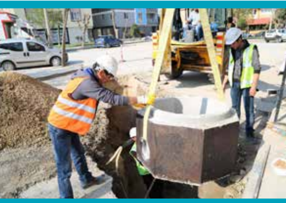
Deliktaş Mahallesi Atıksu Parsel Bacası İmalatı
