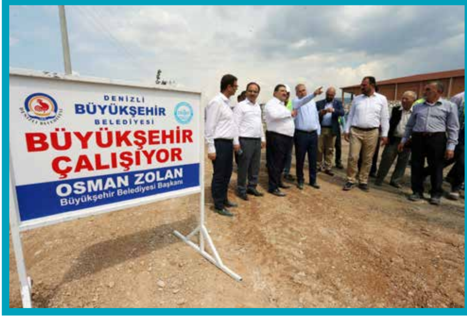
Honaz İlçesi Altyapı Çalışmaları İncelemesi
