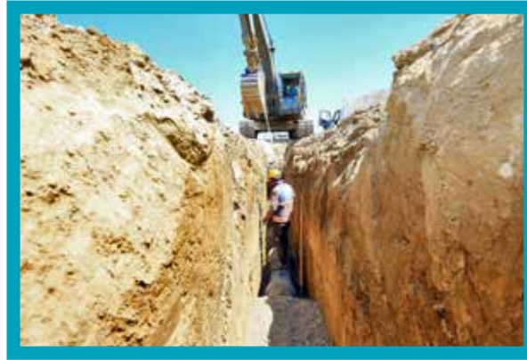
Çivril İlçesi Kızılcasöğüt Mahallesi Kanalizasyon Hattı
