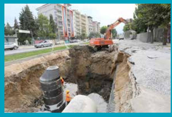
Özay Gönül Meydanı Atıksu ve Yağmursuyu Şebekesi İmalatı
