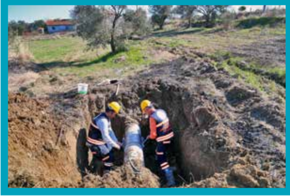
Sarayköy İlçesi İçmesuyu Ana Hattı Kaçak Tespiti ve Arızaların Giderilmesi
