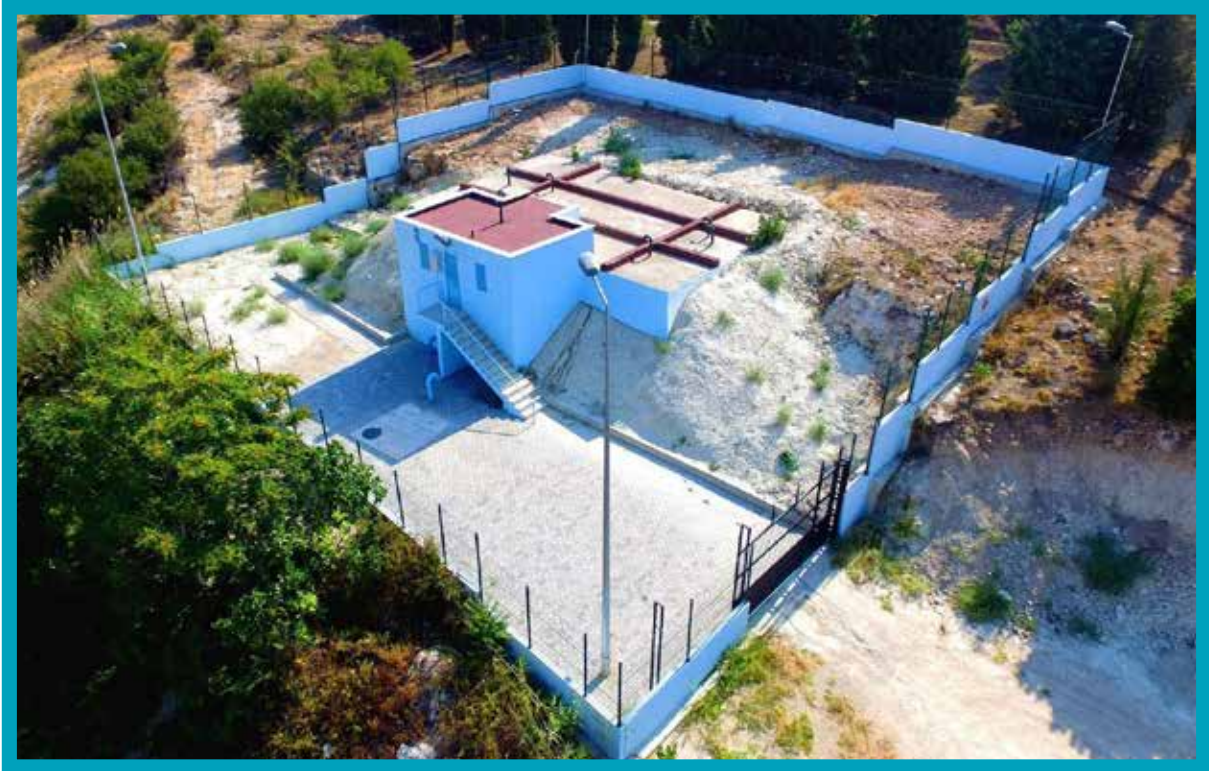
Hacıyüplü Mahallesi SCADA Kontrollü Su Deposu
