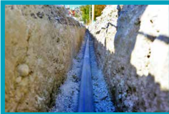
Çardak İlçesi Merkez 1.650 m. İçmesuyu Hattı Yapımı
