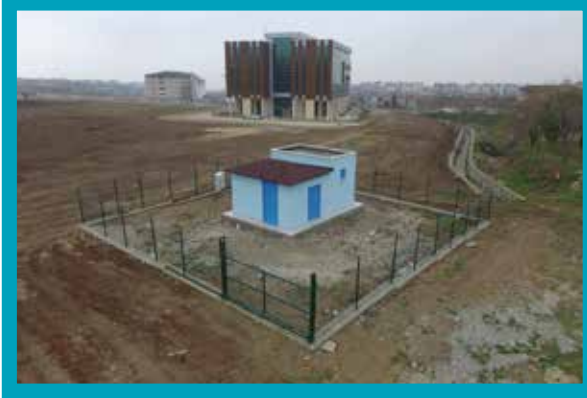
Mehmet Akif Ersoy Mahallesi Derin Kuyu Binası
