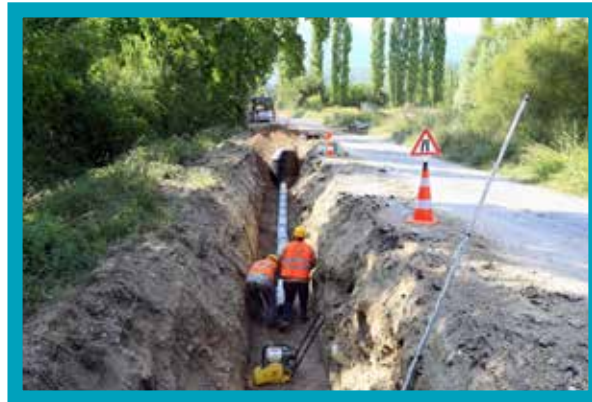
Acıpayam İlçesi Kelekçi Mahallesi Kanalizasyon Hattı
