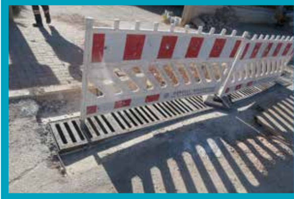
Karahasanlı Mahallesi Izgara Hattı Yapımı
