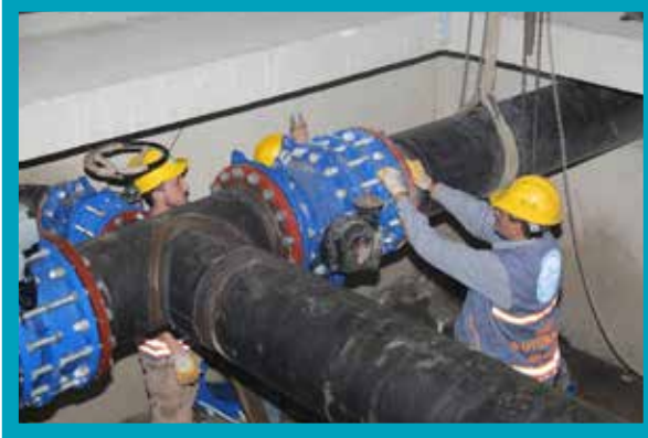
Depolarda Mekanik Rehabilitasyon İşlerinin Yapılması
