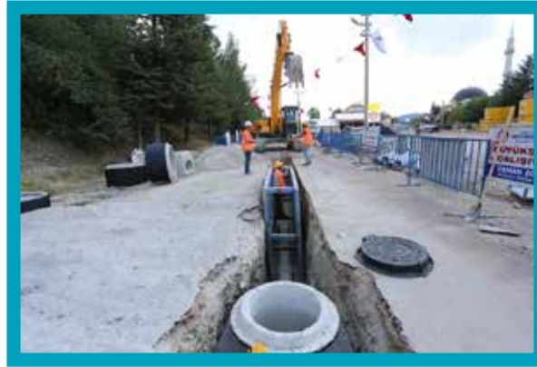
Çameli İlçesi Merkez Mahallesi Kanalizasyon Hattı
