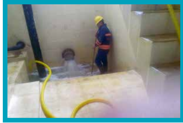
Çakmak Deposu İçmesuyu Deposu Temizlik ve Dezenfeksiyon İşlemleri
