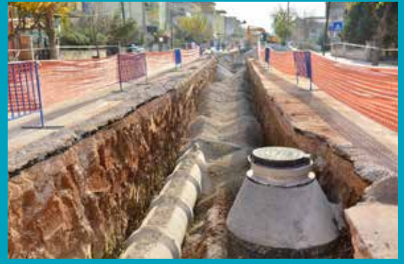
Cumhuriyet Mahallesi Atıksu ve Yağmursuyu Şebekesi İmalatı
