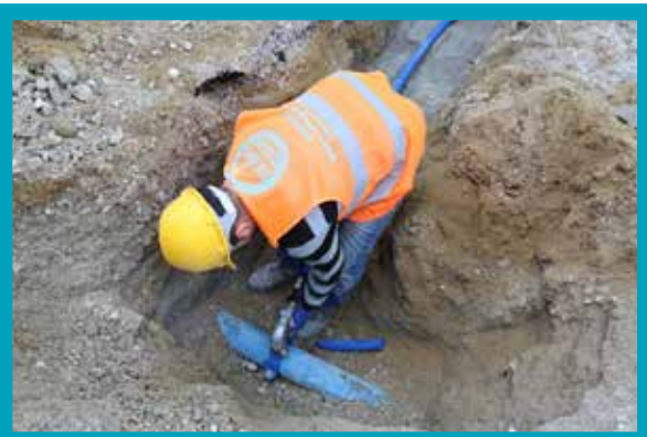
Fatih Mahallesi İçmesuyu Abone Bağlantısı İmalatı (Şebekeye Bağlantısı Yapılması)
