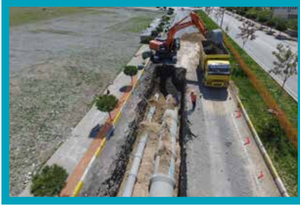
Honaz İlçesi Haydar ve Yenimahalleleri Yağmursuyu ve Kanalizasyon Hatları Yapımı
