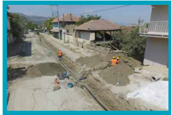
Çardak-Beylerli İçmesuyu İnşaatı Yapımı
