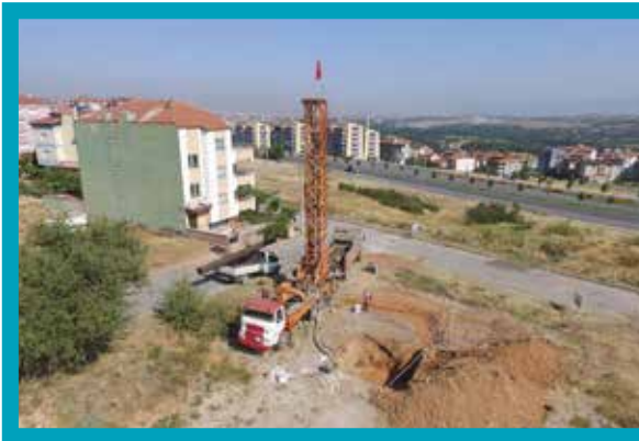
Pamukkale İlçesi Kervansaray Mahallesi Sondaj Kuyusu Çalışması
