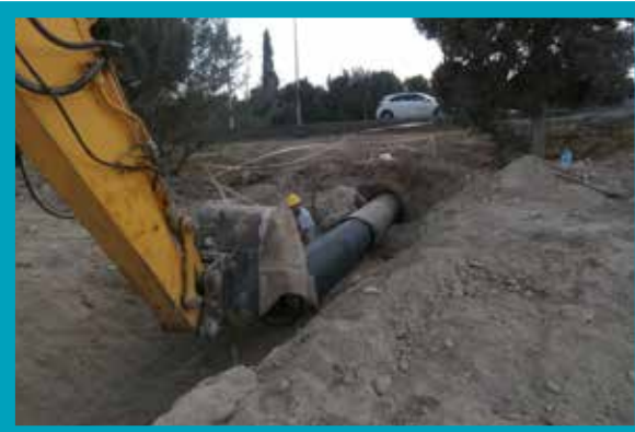
Hacıyüplü Mahallesi Akça Caddesi Yatay Sondaj Geçişi ve Kanalizasyon Hattı İmalatı
