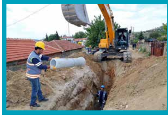
5. Bölge Buldan Doğanköy Kanalizasyon Hattı Yapılması
