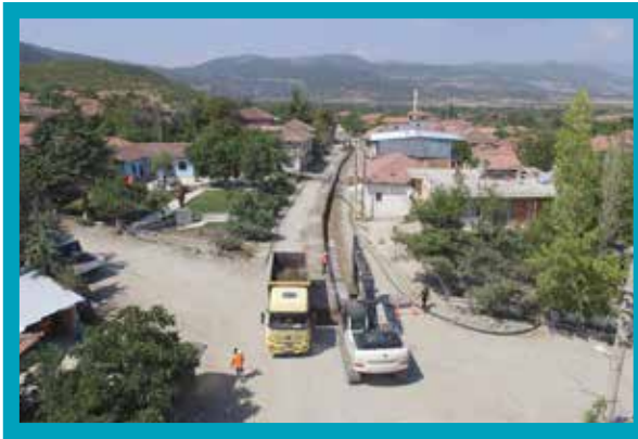
Çardak-Beylerli Kanalizasyon İnşaatı Yapımı
