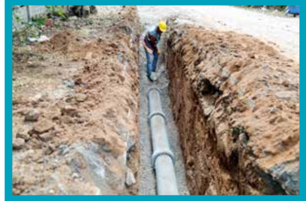
Honaz İlçesi Kızılyer Mahallesi Kanalizasyon Hattı
