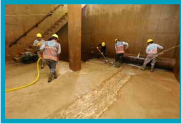
Kuruçay Deposu İçmesuyu Deposu Temizlik ve Dezenfeksiyon İşlemleri
