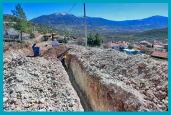
Acıpayam İlçesi Dodurgalar Mahallesi 2.020 m Beton Boru Kanalizasyon Hattı Yapımı
