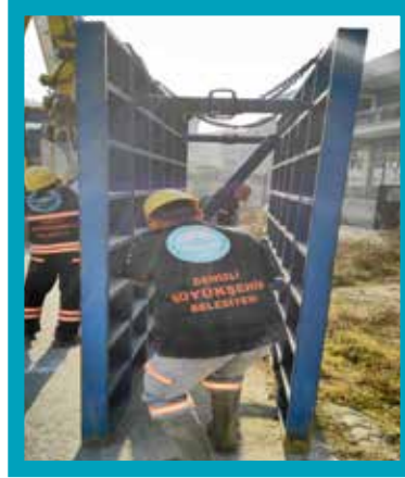
Toprak Kayması İhtimali Olan Kanalizasyon Çalışmalarında Kullanılan İksa Ekipmanı
