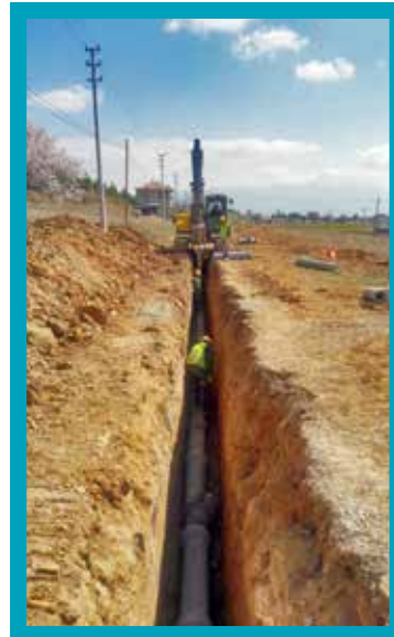
1. Bölge Çivril Arpınar Mahallesi Kanalizasyon Hattı Yapılması
