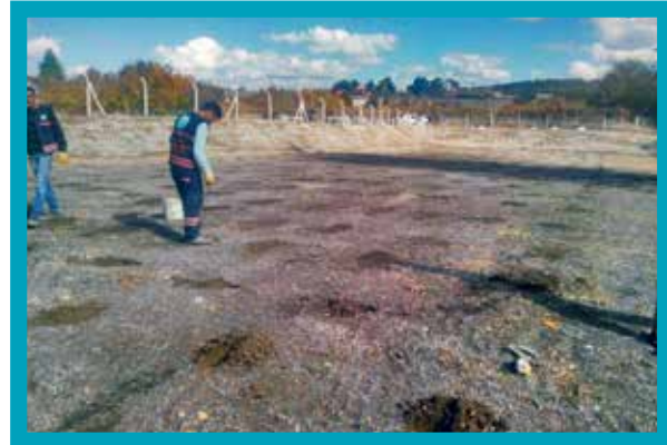
Alikurt Doğal Atıksu Arıtma Tesisi Bitki Kökleri Dikimi
