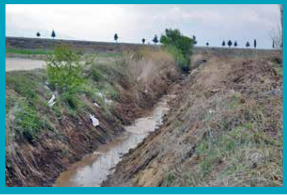
Acıpayam İlçesi Kumafşarı Mahallesi Kanal Temizliği ile 680 m Kanalizasyon Yapımı
