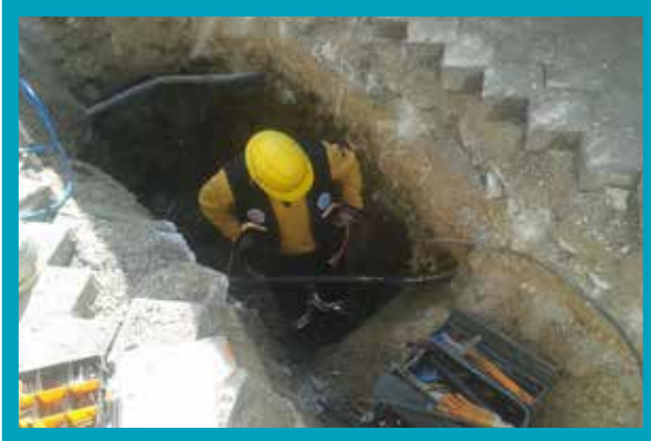
Kazı Esnasında Kopan Kablo Tamiri
