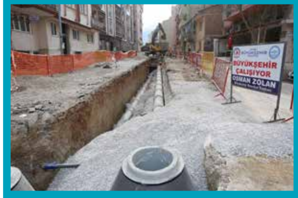
İlbade Mahallesi Yağmursuyu ve Kanalizasyon Şebekesi İmalatı
