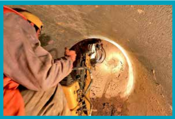
İzmir Bulvarı Yatay Delgi ile Geçiş
