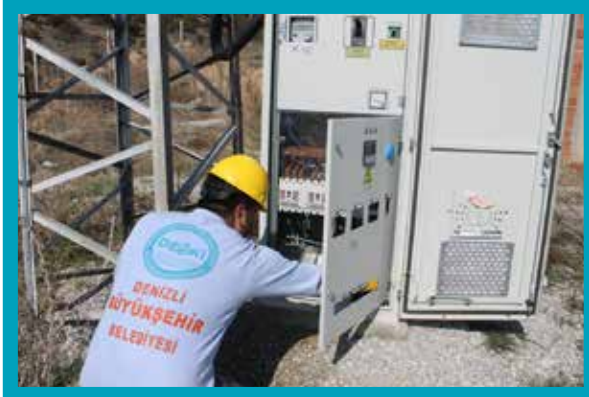
Yeni İçmesuyu Pompasının Elektrik Bağlantısı İşi
