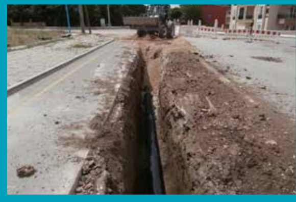
Bağbaşı Mahallesi Kanalizasyon Hattı İmalatı
