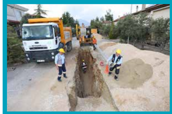
Servergazi Mahallesi Esnaf Sitesi Ana Şebeke İmalatı
