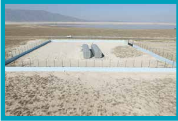
Çardak Gemiş Paket Atıksu Arıtma Tesisi
