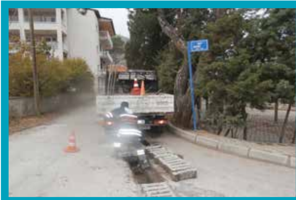
Gerzele Mahallesi Izgara Hattı Temizliği
