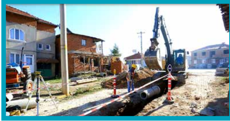
1. Bölge Çivril Akpınar Mahallesi Kanalizasyon Hattı Yapılması
