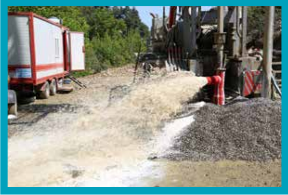
Merkezefendi İlçesi Yeşilyayla Mahallesi Sondaj Kuyusu İnkişafı
