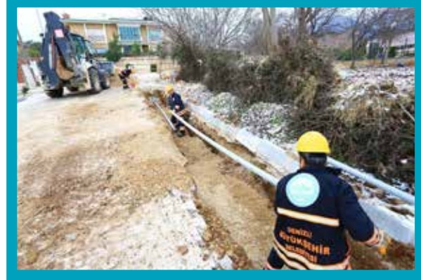
Çakmak Mahallesi Ana Şebeke İmalatı
