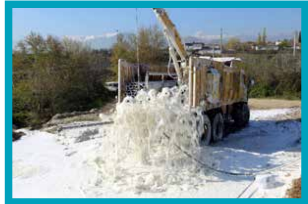
Kuyu Temizleme İşlemi
