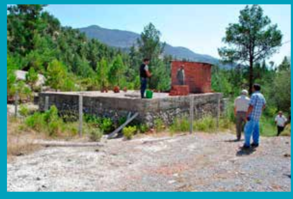
Acipayam Gölcük Eski İçmesuyu Deposu
