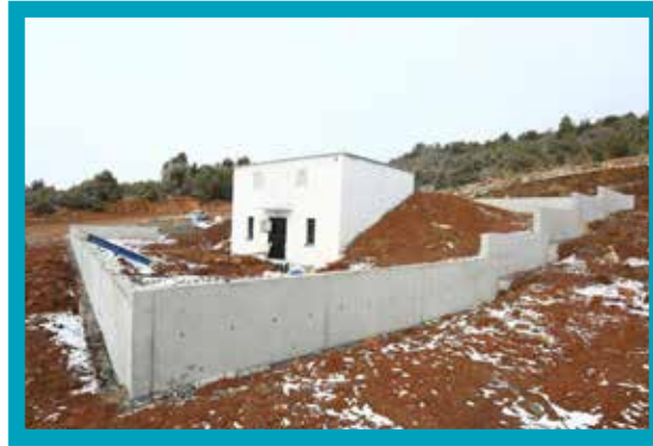
Acıpayam Alcı İçmesuyu Deposu
