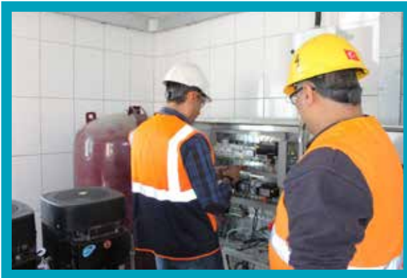
Elektrik Arıza Ekibi Çalışması
