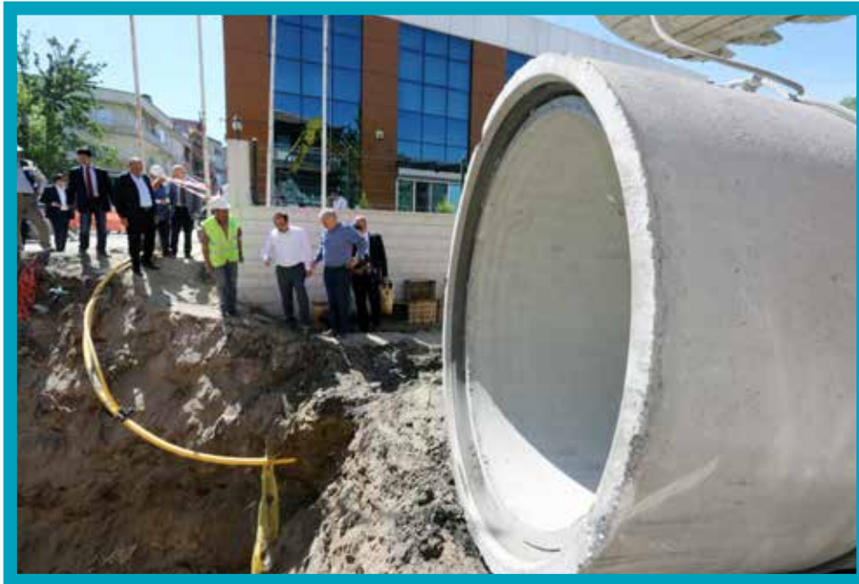
İlbade Mahallesi Mehmet Gazi Caddesi Altyapı ve Su Deposu İncelemesi
