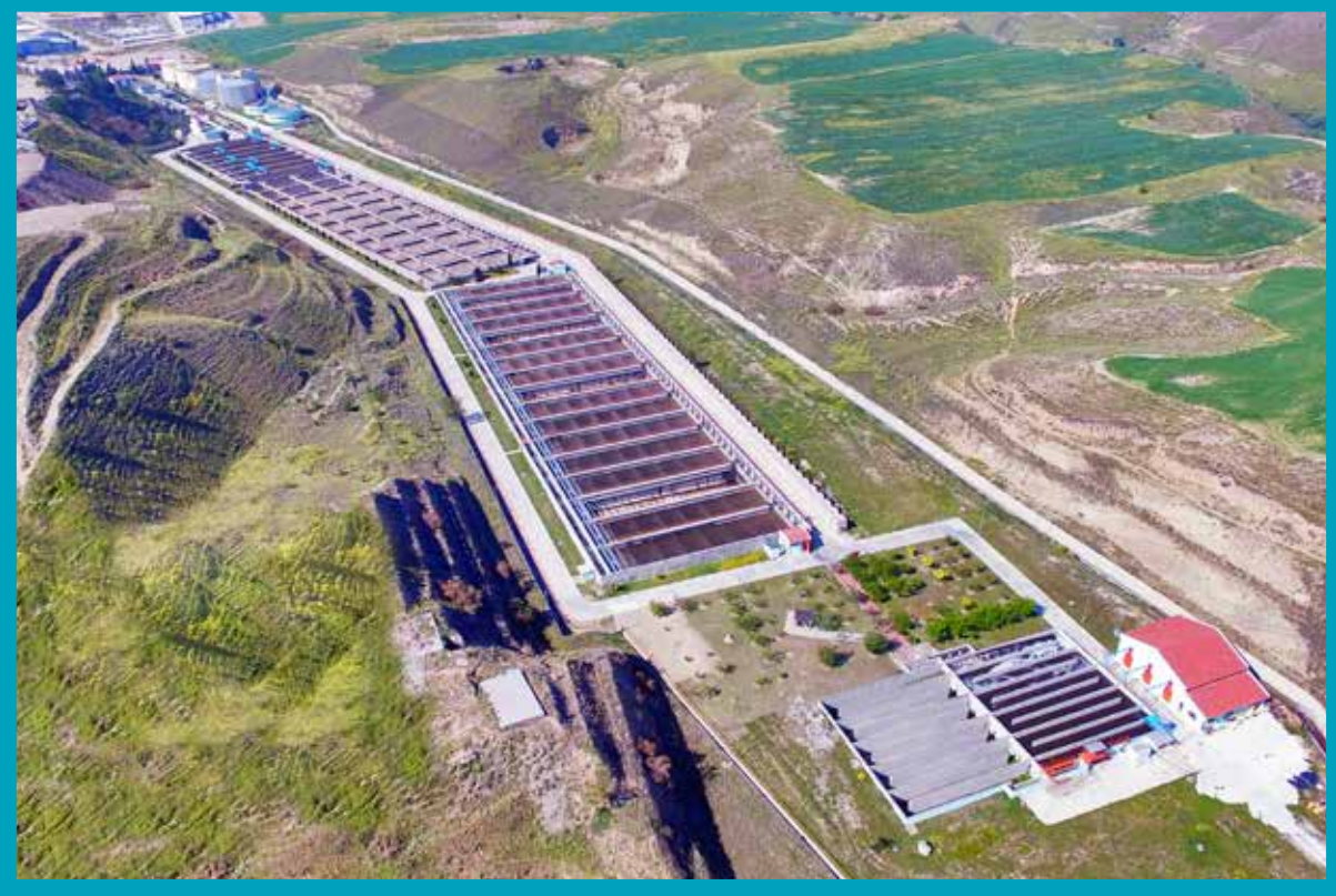
Merkez Atıksu Arıtma Tesisi
