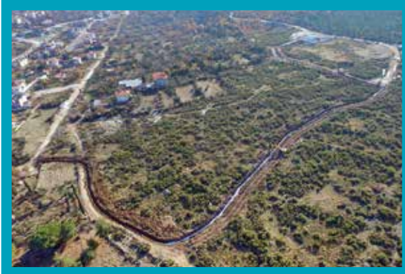
Servergazi Türbe Deposu İsale Hattı İmalatı
