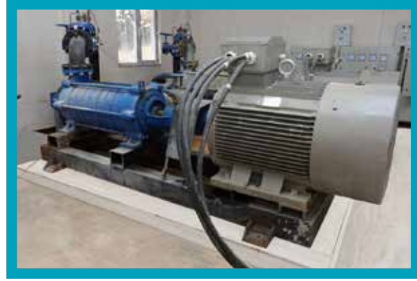
Pompa Bakım Onarım İşlemi
