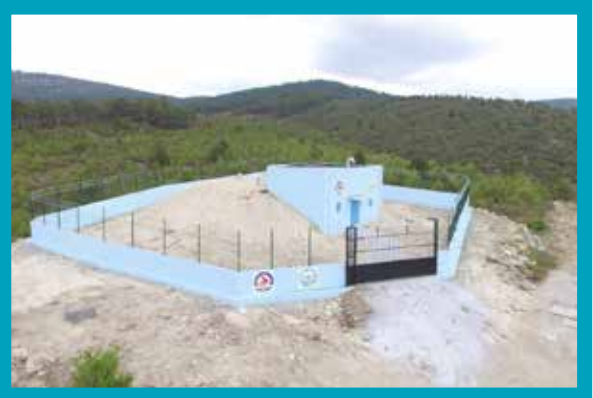
Bozkurt İlçesi Mecidiye Mahallesi 300 m 3 İçmesuyu Deposu
