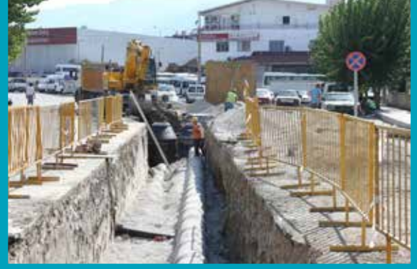
Deliktaş Mahallesi Atıksu ve Yağmursuyu Şebekesi İmalatı
