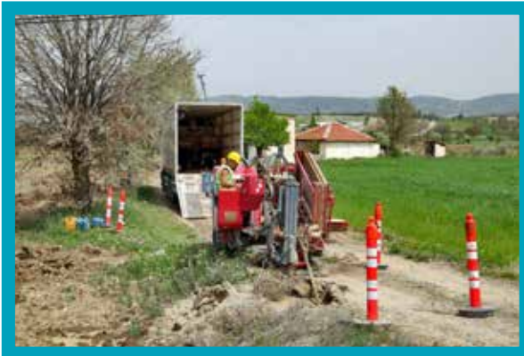
Buldan İlçesi Yatay Sondaj Çalışması
