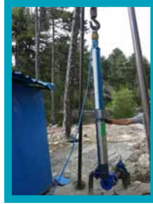
İçmesuyu Pompası Değişim İşi
