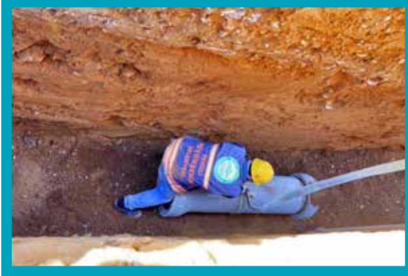
Çivril İlçesi Haydan Mahallesi Kanalizasyon Hattı
