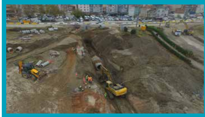
Üçgen Kavşağı Yağmursuyu ve Kanalizasyon Hattı
