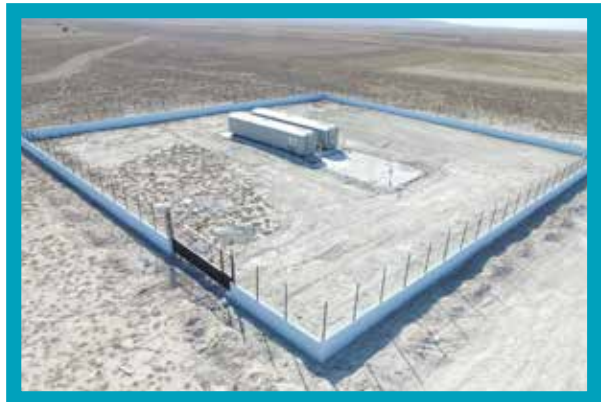
Çardak Gemiş Paket Atıksu Arıtma Tesisi
