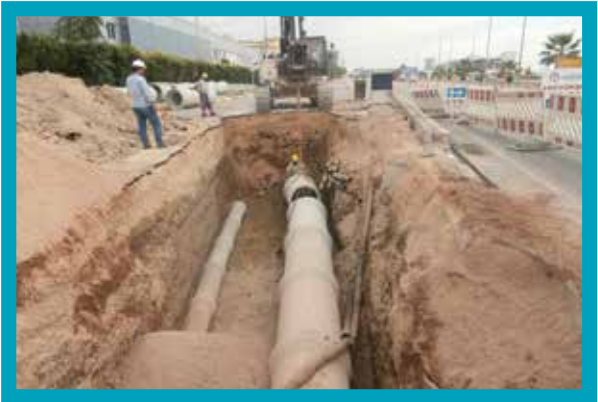
Akhan Mahallesi Ankara Bulvarı Üzeri Yağmursuyu İmalatı
