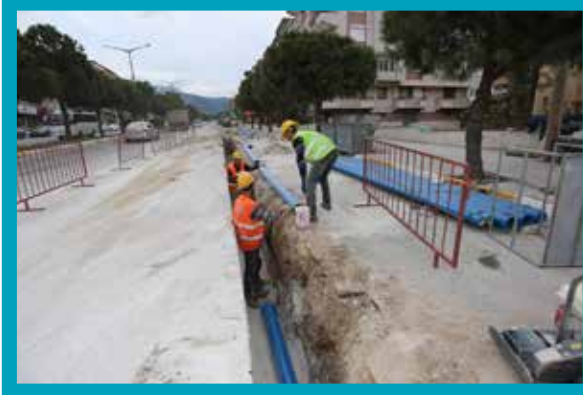
Mehmetçik Mahallesi İçmesuyu Şebekesi İmalatı
