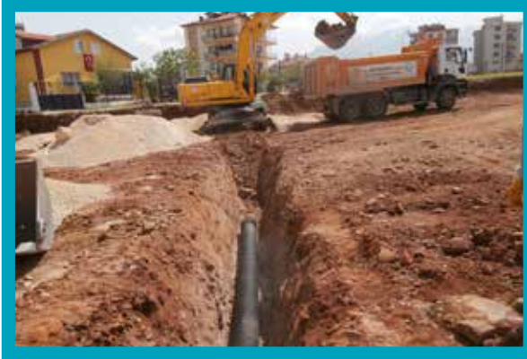
Yenişafak Mahallesi Kanalizasyon Hattı İmalatı
