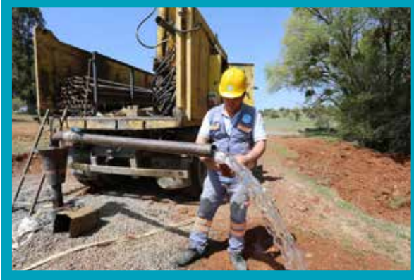
Tavas İlçesi Sarıabat Mahallesi Sondaj Kuyusu Tecrübesi
