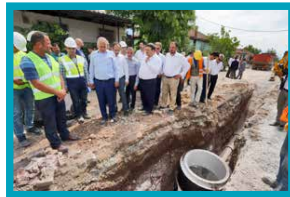
Honaz İlçesi Kızılyer Mahallesi Kanalizasyon Hattı
