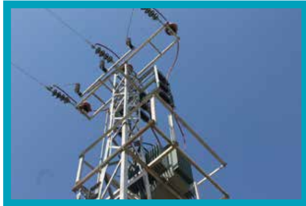
Trafo Yenileme İşi
