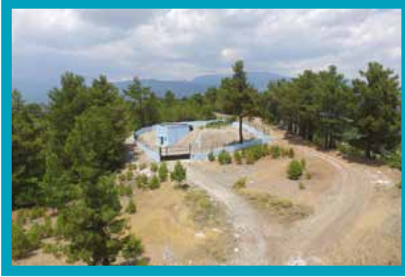
Acıpayam İlçesi Kelekçi Mahallesi 500 m 3 İçmesuyu Deposu
