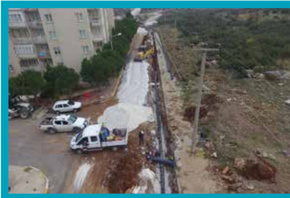
Yenişehir Mahallesi İsale Hattı İmalatı
