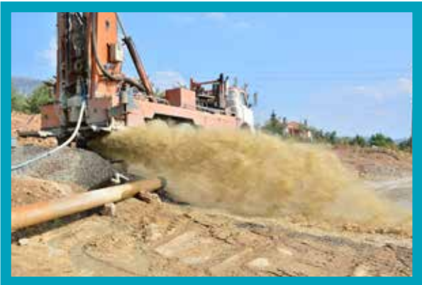
Pamukkale İlçesi Cankurtaran Mahallesi Sondaj Kuyusu İnkişafı
