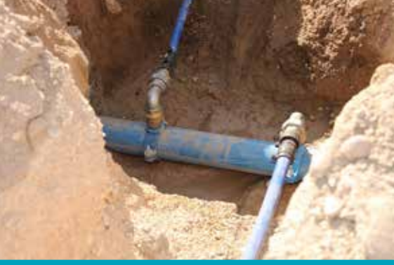
Cumhuriyet Mahallesi İçmesuyu Abone Bağlantısı İmalatı (Şebekeye Bağlantı Yapılması)
