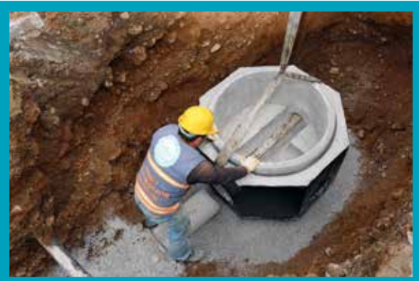
Acıpayam İlçesi Merkez 10.505 m Kanalizasyon Hattı Yapımı
