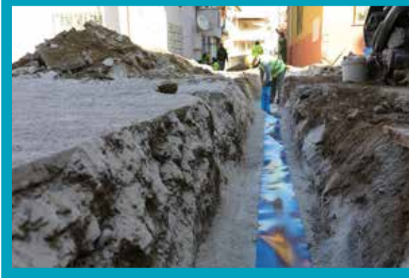
İlbade Mahallesi İçmesuyu Şebekesi İmalatı
