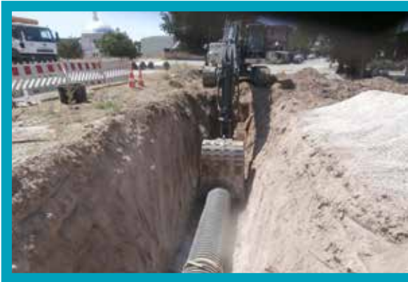
Zafer Mahallesi Kanalizasyon Hattı İmalatı
