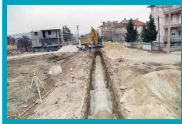
Çivril İlçesi Merkez Mahallesinde Yağmursuyu Hattı
