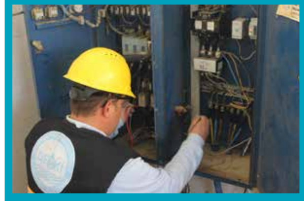
Elektrik Arızasının Giderilmesi
