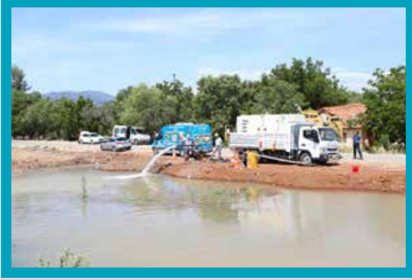
Tavas İlçesi Kızılcabölük Mahallesi Sondaj Kuyusu Tecrübesi
