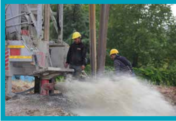
Merkezefendi İlçesi Adalet Mahallesi Sondaj Kuyusu İnkişafı
