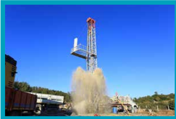
Güney İlçe Merkezi Sondaj Kuyusu İnkişafı
