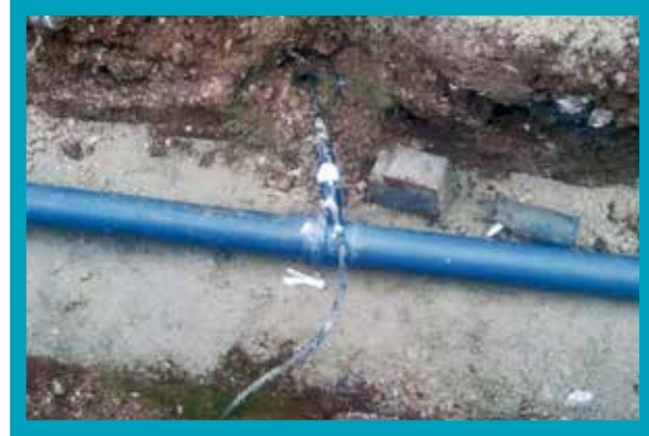
Kazı Esnasında Kopan Kablo Tamiri
