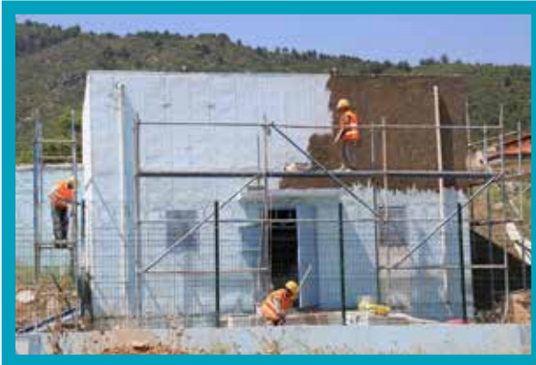
Depolarda İnşaat İşleri
