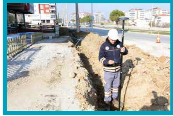
Karahasanlı Mahallesi Ana Şebeke İmalatı Sayısal Verilerin İşlenmesi
