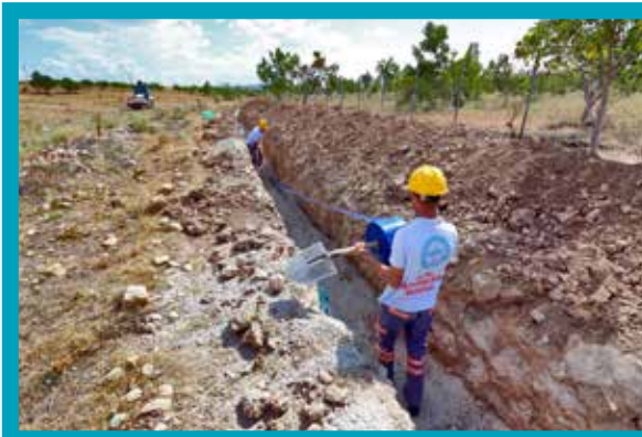
Baklan İlçesi Boğaziçi Mahallesi 6.550 m Ana Şebeke İçmesuyu Hattı Yapımı
