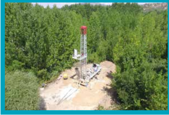
Çal İlçe Merkezi Sondaj Kuyusu Çalışması
