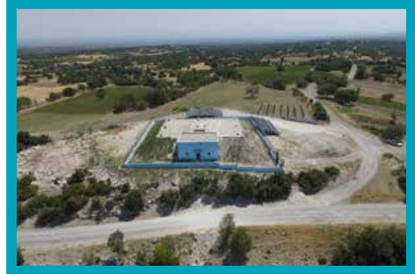
Güney İlçesi Haylamaz Mahallesi 2.000 m 3 İçmesuyu Deposu
