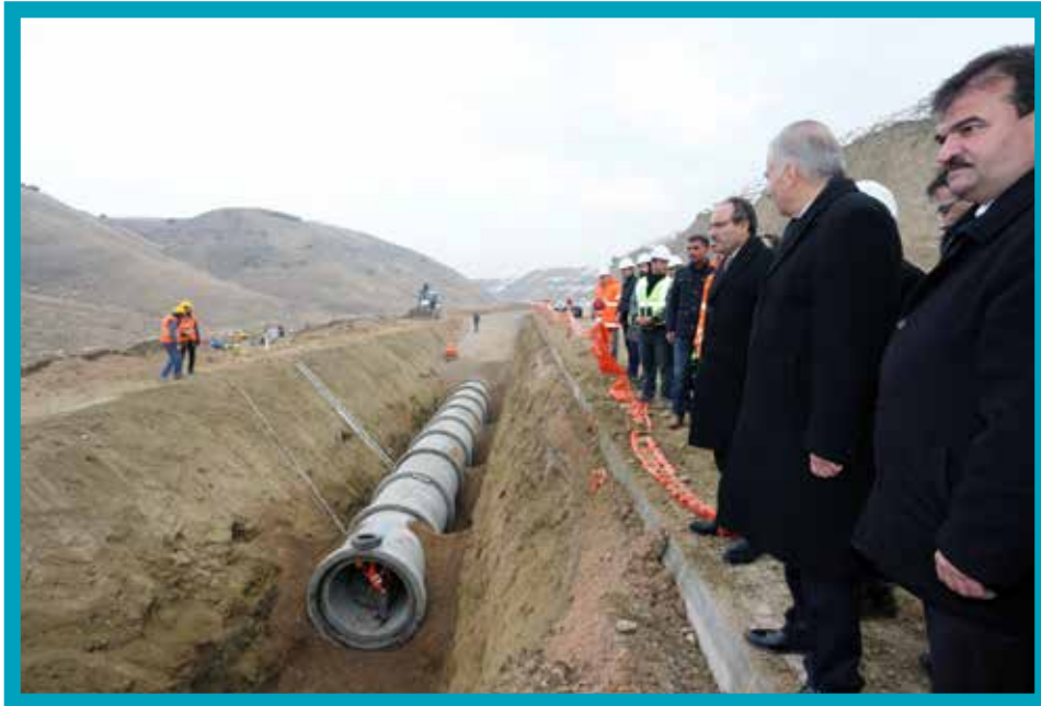
Bozburun Mahallesi Altyapı Çalışmaları Saha İncelemesi
