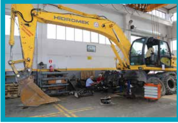
Ekskavatör Bakım ve Onarımı
