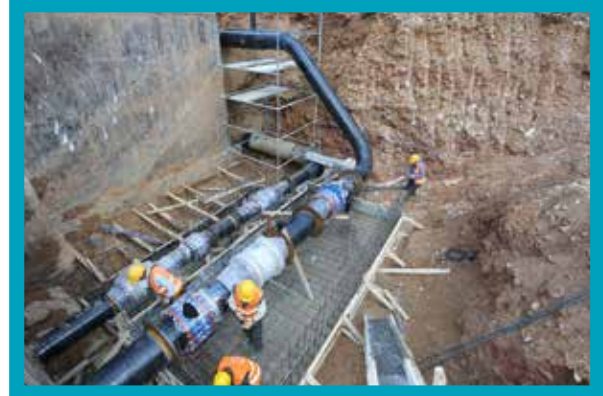
Taşocağı Deposu Vana Odası Yapımı
