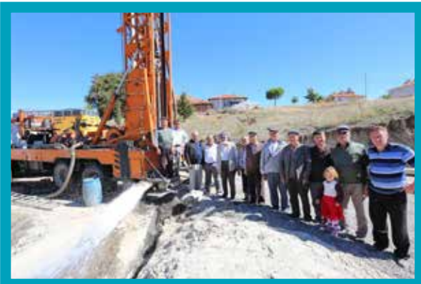
Acıpayam İlçesi Dedebağ Mahallesi Sondaj Kuyusu İnkişafı
