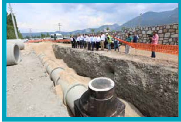
Honaz İlçesi Haydar, Yenimahalle Mahallerinde Yağmursuyu ve Kanalizasyon Hatları Yapımı
