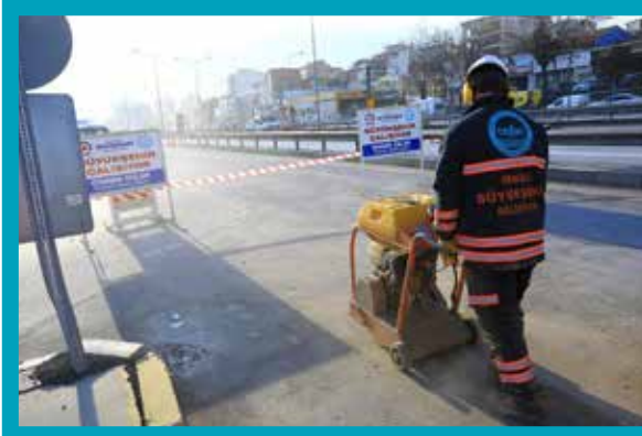
Zafer Mahallesi İzmir Bulvarı Ana Şebeke Bağlantısı
