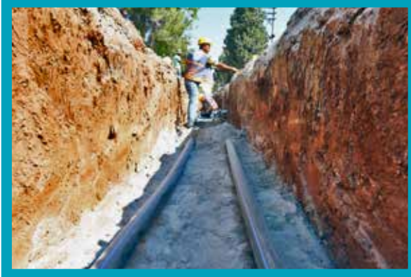
Honaz İlçesi Kızılyer Mahallesi İçmesuyu
