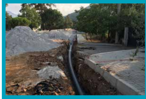
Merkezefendi İlçesi Servergazi Mahallesi İçmesuyu İnşaatı Yapım İşİ
