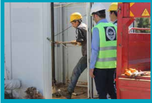
İçmesuyu Pompası Arızasının Giderilmesi
