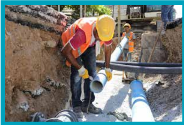
Karaman Mahallesi İçmesuyu Şebekesi İmalatı
