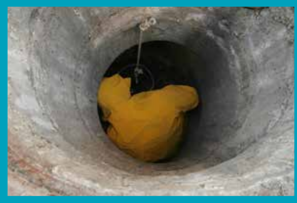
Saraylar Mahallesi Rögar İçi Temizliği
