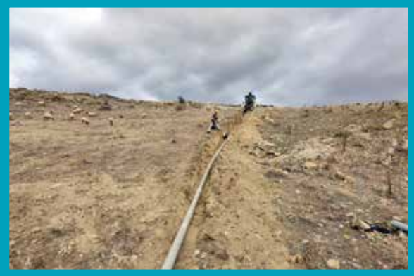
Çardak İlçesi Göz Mahallesi 415 m İçmesuyu Hattı Yapımı
