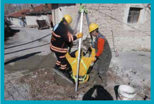
Akdere Mahallesi Rögar İçi Temizliği
