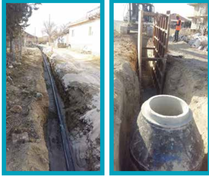
Çardak-Gemiş İçmesuyu ve Kanalizasyon Hattı Yapılması
