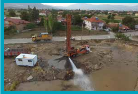
Acıpayam İlçesi Alaattin Mahallesi Sondaj Çalışması
