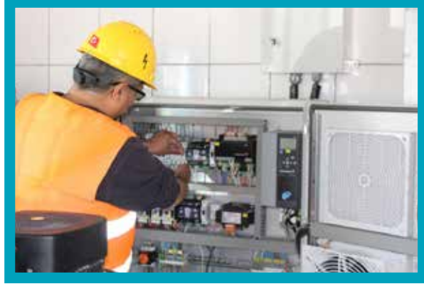
Yeni Elektrik Panosu Montajı
