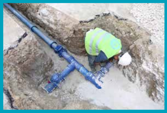
İncilipınar Mahallesi İçmesuyu Şebekesi İmalatı
