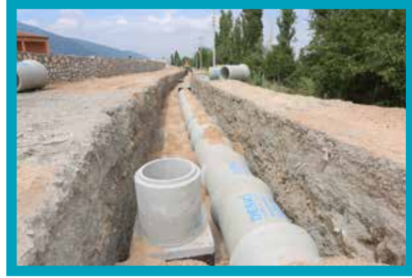
Honaz İlçesi Haydar ve Yenimahalleleri Yağmursuyu ve Kanalizasyon Hatları Yapımı
