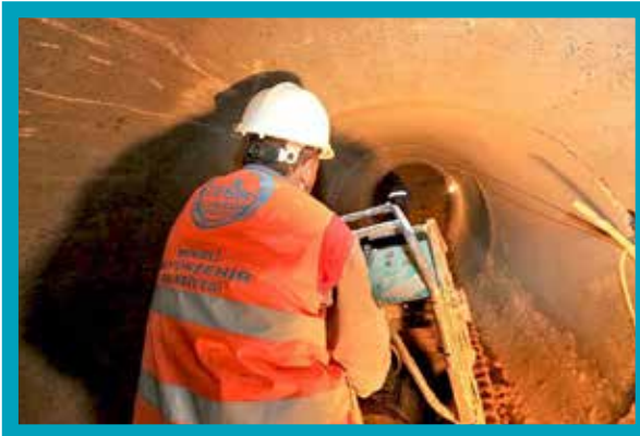
İzmir Bulvarı Yatay Delgi ile Geçiş
