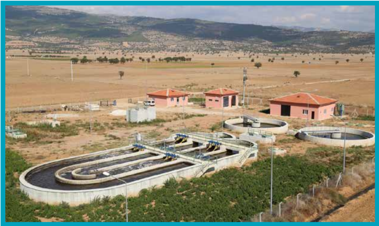
Serinhisar Atıksu Arıtma Tesisi
