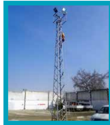
Depo Aydınlatma Direğinin Elektrik Tamiri
