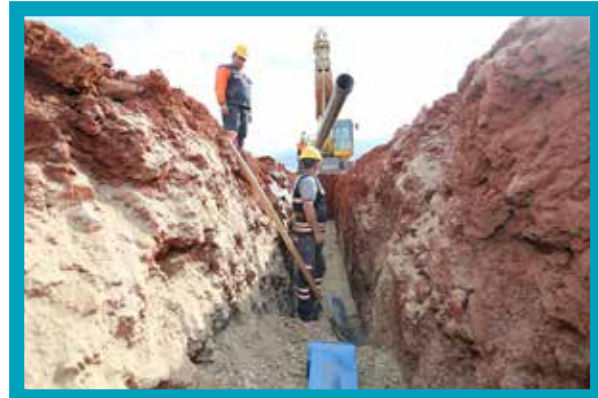
Bahçelievler Mahallesi Ana Şebeke İmalatı
