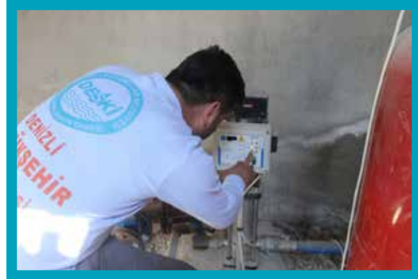
Hidrofor Elektrik Arızasının Giderilmesi
