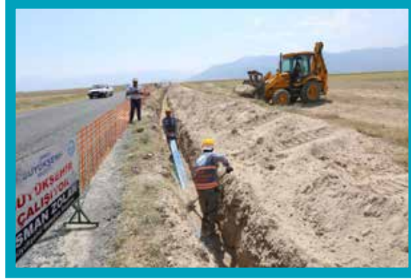
2. Bölge Bozkurt Sazköy Mahallesi İçmesuyu Hattı Yapılması
