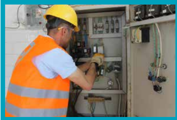
Elektrik Pano Arızası Onarım İşi
