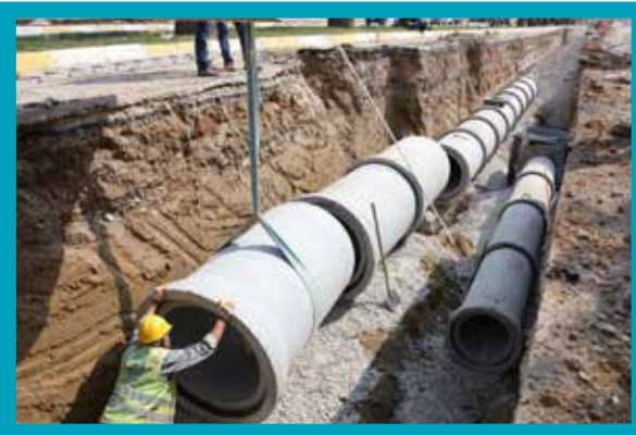
29 Ekim Bulvarı Atıksu ve Yağmursuyu Şebekesi İmalatı
