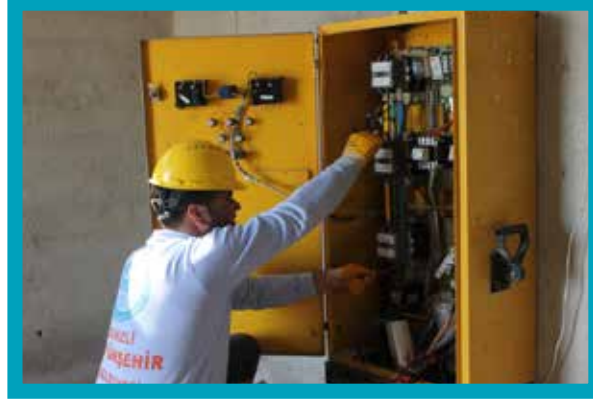
Elektrik Pano Arızası Giderilmesi
