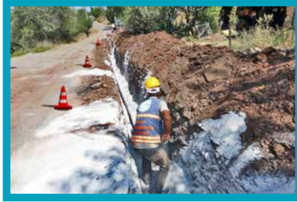
Honaz İlçesi Yukarıdağdere Mahallesi İçmesuyu Hattı
