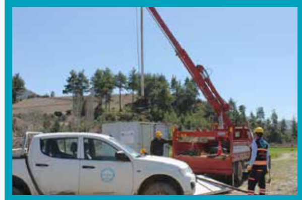
İçmesuyu Pompası Devreye Alma Çalışması
