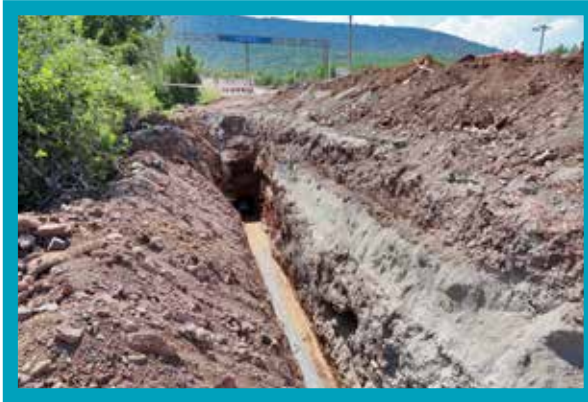
Tavas İlçesi Solmaz Altınova Karayolu Yatay Sondaj
