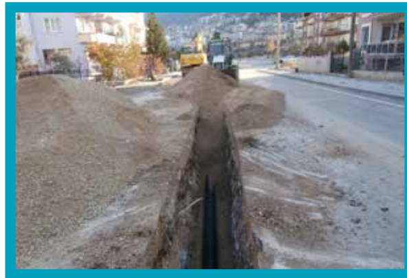
Zeytinköy Mahallesi Kanalizasyon Hattı İmalatı
