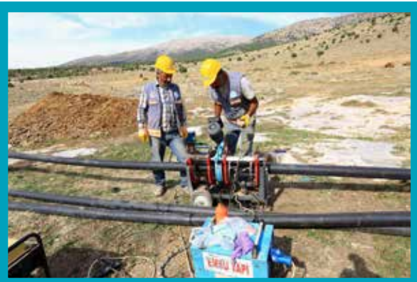
Çivril İlçesi Cabar Mahallesi 2.350 m İçmesuyu Terfi Hattı Yapımı
