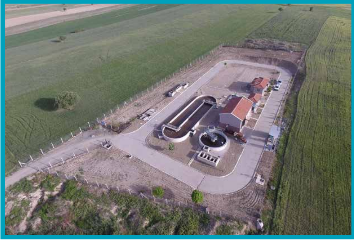
Bozkurt Atıksu Arıtma Tesisi Genel Görünüm
