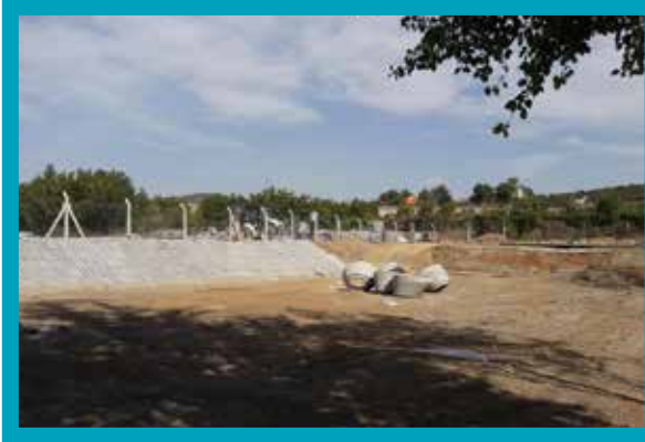
Alikurt Doğal Atıksu Arıtma Tesisi Revizyon Çalışmaları
