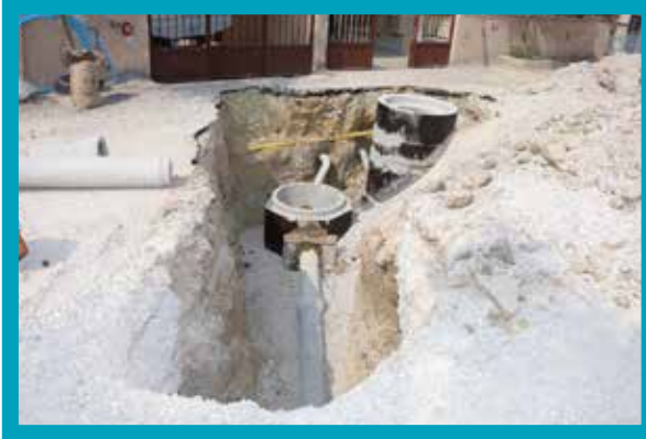
Karaman Mahallesi Atıksu Şebekesi Parsel Bacası İmalatı
