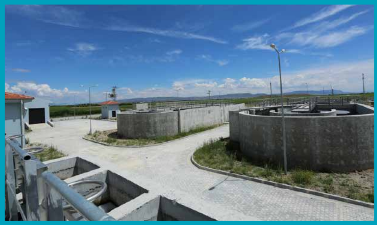
Çivril Atıksu Arıtma Tesisi
