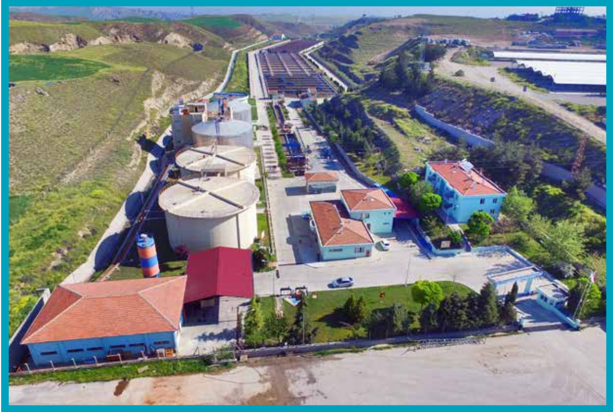
Denizli Merkez Atıksu Arıtma Tesisi Genel Görünüm
