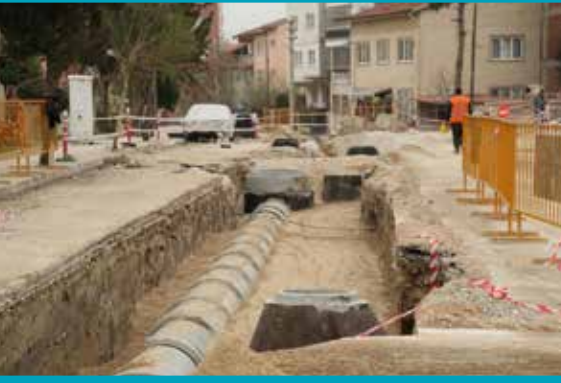
Deliktaş Mahallesi Atıksu ve Yağmursuyu Şebekesi İmalatı
