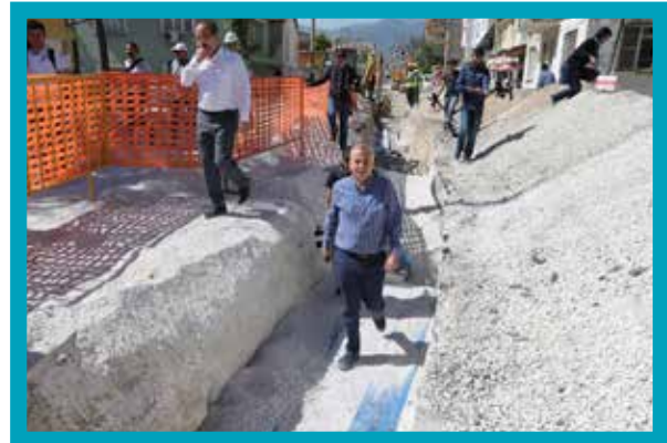
İlbede Mahallesi İçmesuyu Şebekesi İmalatı
