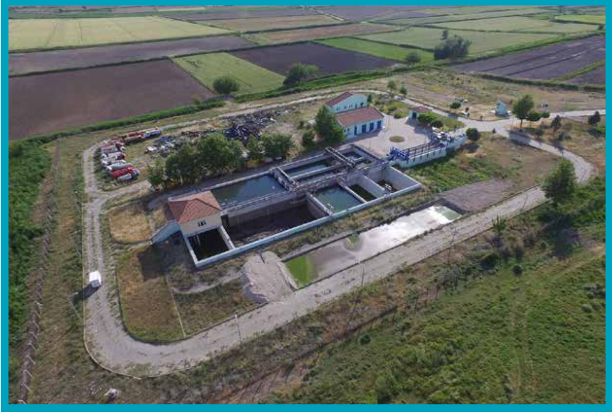
Akköy Atıksu Arıtma Tesisi Genel Görünüm
