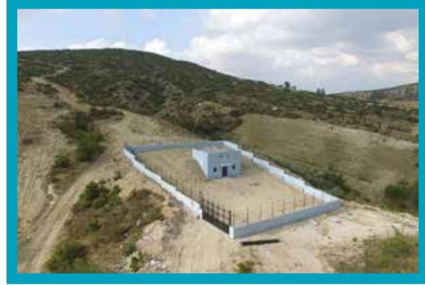
Çardak İlçesi Söğüt Mahallesi 300 m 3 İçmesuyu Deposu
