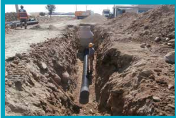
Hacıyüplü Mahallesi Kanalizasyon Hattı İmalatı
