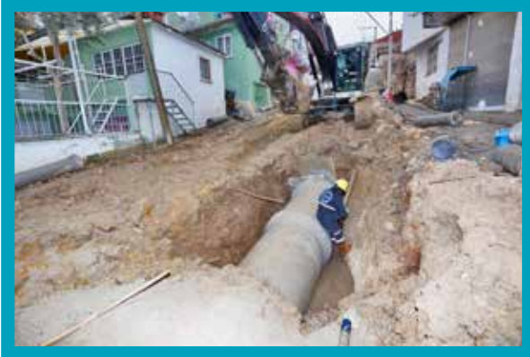
Güney İlçesi Merkez 250 m Kanalizasyon Hattı Yapılması
