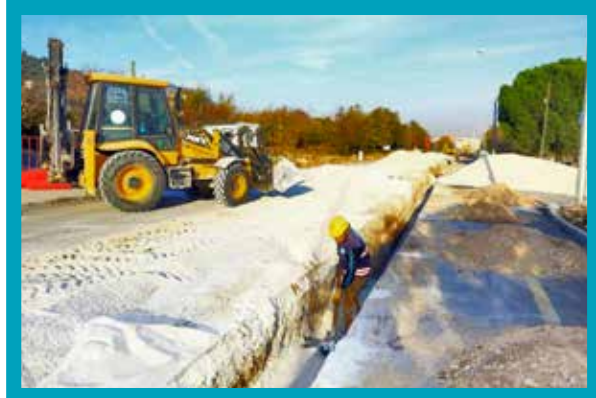
Yenişehir Deposu İsale Hattı İmalatı
