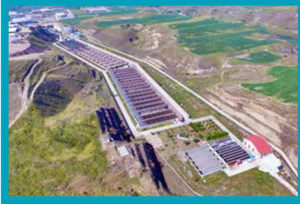
Denizli Merkez Atıksu Arıtma Tesisi Genel Görünüm
