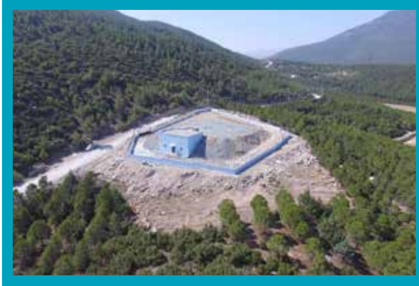
Honaz İlçesi Ovacık Mahallesi 2.000 m 3 İçmesuyu Deposu
