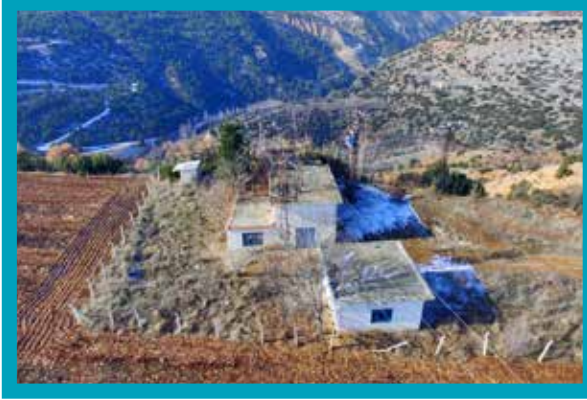
Bekilli İlçesi Merkez Mahallesi Eski İçmesuyu Deposu
