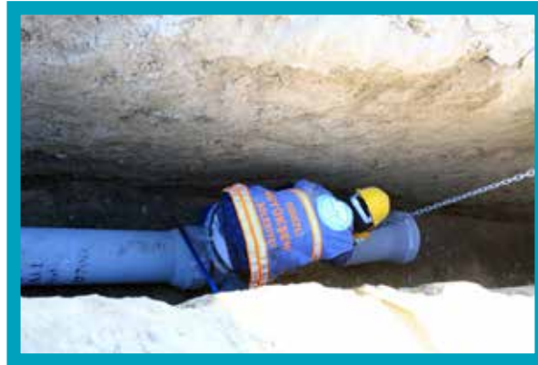
Bozkurt İlçesi Cumalı Mahallesi Kanalizasyon Hattı
