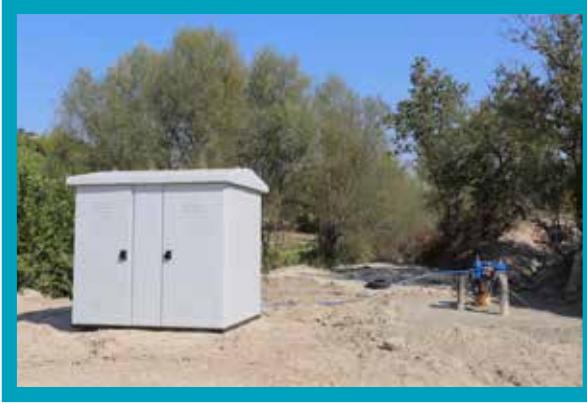
Yeni Sondaj Kuyularının ve Kabinlerinin Yenilenmesi İşlemi
