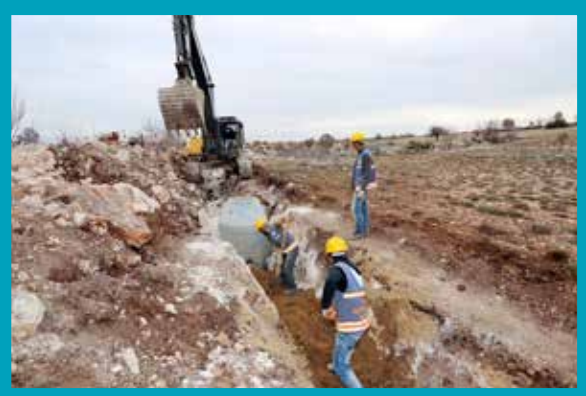
Çal İlçesi Dağmarmara Mahallesi 700 m Kanalizasyon Hattı Yapımı
