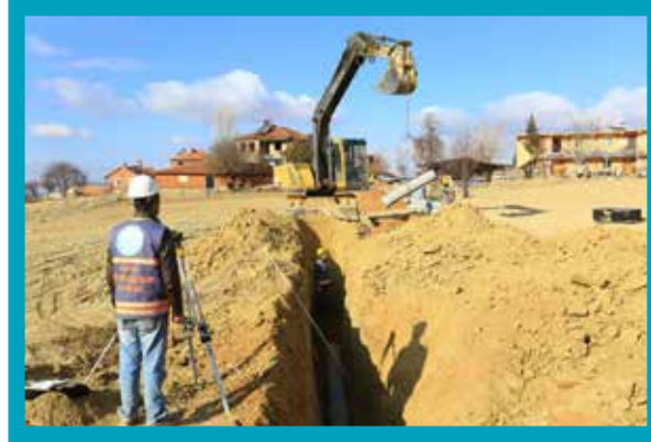
Çivril İlçesi Özdemirci Mahallesi Kanalizasyon Hattı
