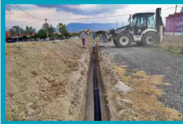
Çardak Merkez 1.214 m. Kanalizasyon Hattı Yapımı
