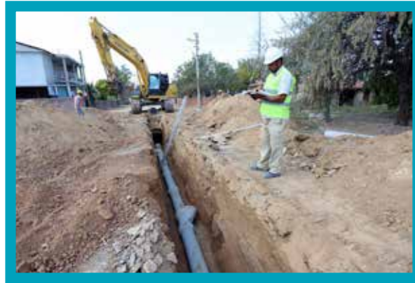
Çivril İlçesi Çıtak Mahallesi Kanalizasyon Hattı
