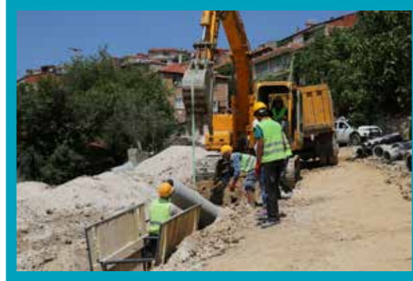
Güney Kanalizasyon Hattı İnşaatı Yapılması
