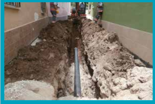
Başkarcı Mahallesi Kanalizasyon Hattı İmalatı
