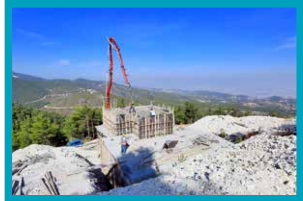
Sarayköy İlçesi Hisar Mahallesi İçmesuyu Deposu
