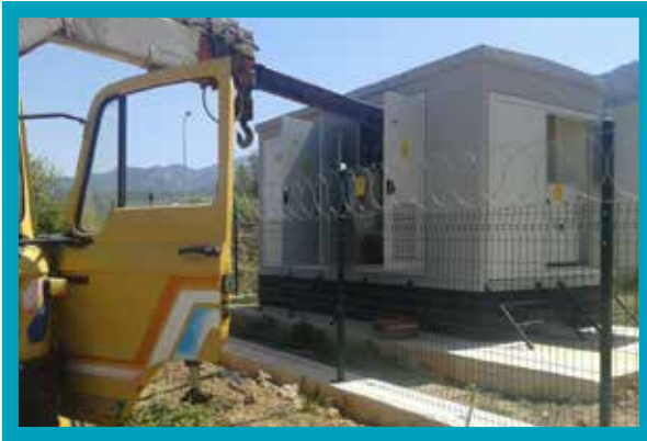
Arızalı Trafo Değişimi İşi
