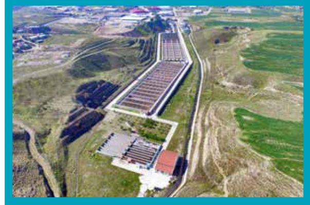
Denizli Merkez Atıksu Arıtma Tesisi Genel Görünüm
