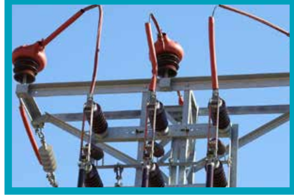
Orta Gerilim İzolasyon ve Bakım Çalışmaları
