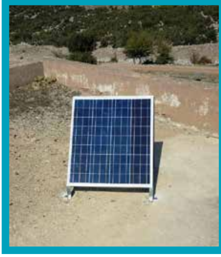
Çameli Kızılyaka Güneş Enerjisi Paneli (GEP) Montajı
