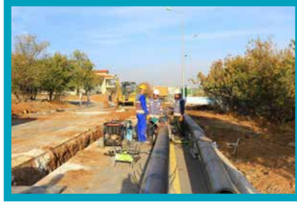
Yenişehir Deposu İsale Hattı İmalatı
