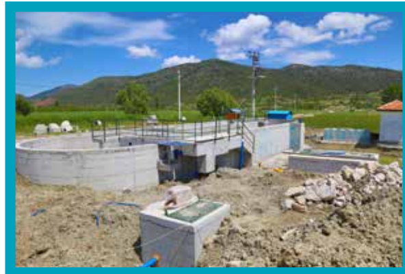
Çameli Atıksu Arıtma Tesisi İnşaatı Yapılması
