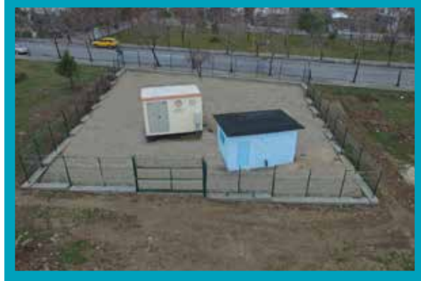
Servergazi Mahallesi Esnaf 3 Derin Kuyu Binası
