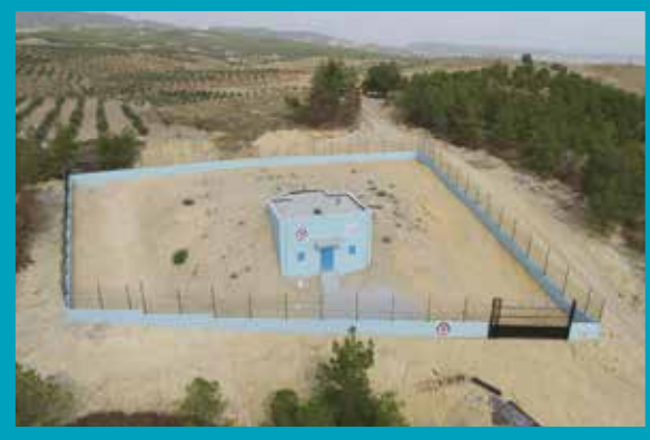
Pamukkale İlçesi 1.000 m 3 İçmesuyu Deposu
