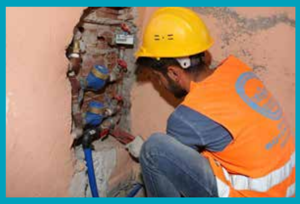
Akkonak Mahallesi İçmesuyu Şebekesi Abone Bağlantısı İmalatı (Sayaca Bağlantı)
