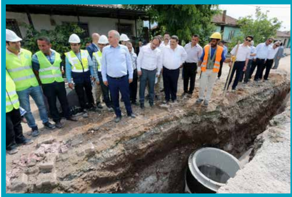
Honaz İlçesi Altyapı Çalışmaları İncelemesi
