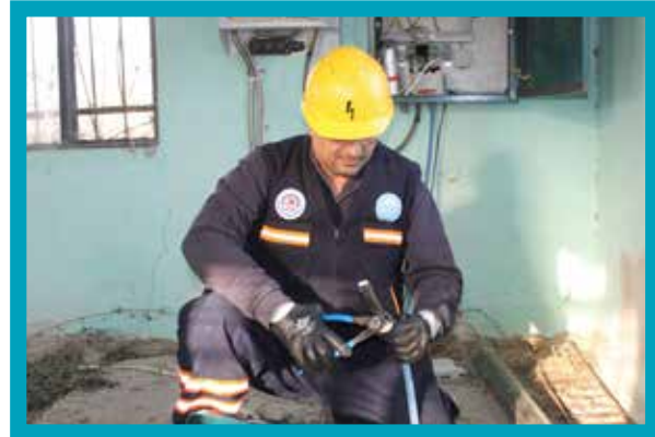
Elektrik Arızasının Giderilme Çalışması
