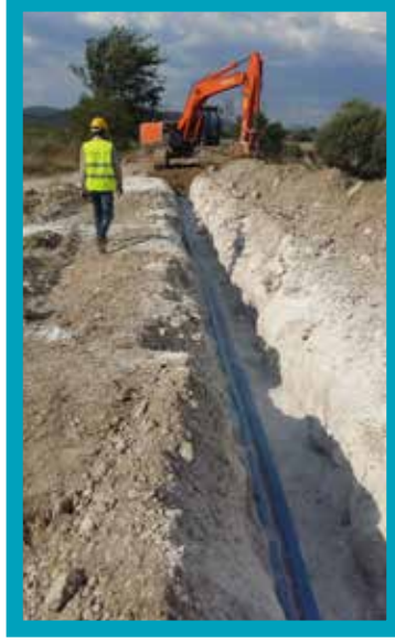
Honaz İlçesi Kaklık Mahallesi Mermer Sanayi Bölgesi İçmesuyu Temini Yapım İşi
