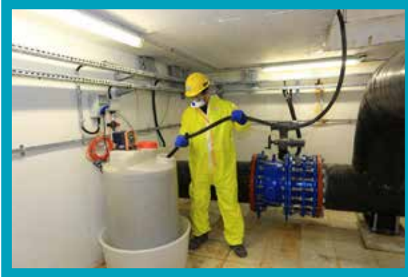
Araç Üstü Tanktan İçmesuyu Depomuzdaki Tankla Klor Nakli
