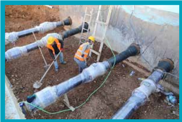
Esnaf Sitesi Deposu Debimetrelerin Montaj İşleri
