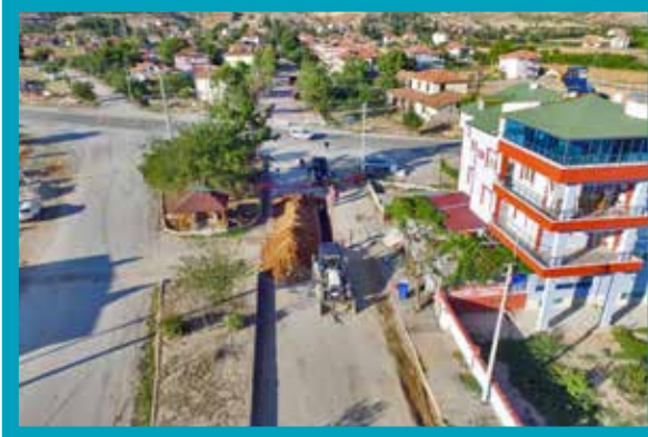
Çivril İlçesi İğdir Mahallesi İçmesuyu Hattı Yapımı
