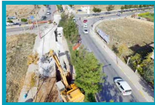
Merkezefendi İlçesi Bahçelievler Mahallesi Yağmursuyu Hattı
