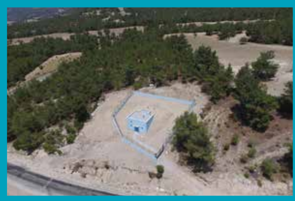
Pamukkale İlçesi Haytabey Mahallesi 300 m 3 İçmesuyu Deposu
