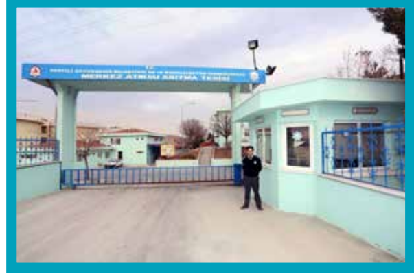
Merkez Atıksu Arıtma Tesisi
