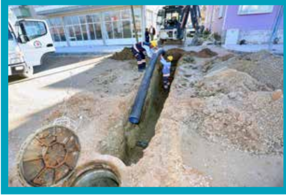
Kale İlçesi Merkez 3.500 m Kanalizasyon Hattı Yapımı
