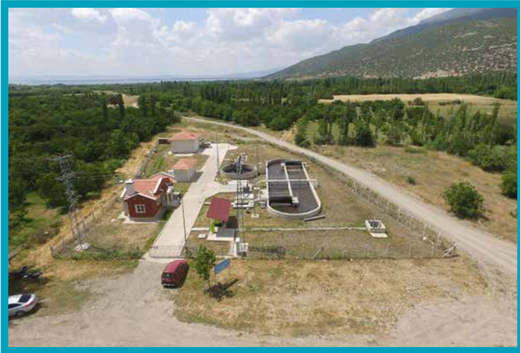
Gümüşsu Atıksu Arıtma Tesisi Genel Görünüm
