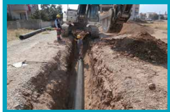
Yenişafak Mahallesi Kanalizasyon Hattı İmalatı
