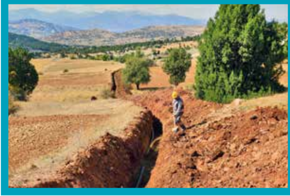
Çameli İlçesi Çiğdemli Mahallesi 1.830 m İçmesuyu İsale Hattı Yapımı
