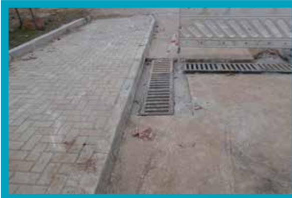
Merkezefendi Mahallesi Fesleğen Caddesi Izgara Hattı Yapımı
