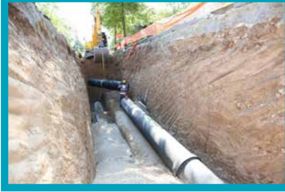
Siteler Mahallesi İçmesuyu ve Atıksu Şebekesi İmalatı
