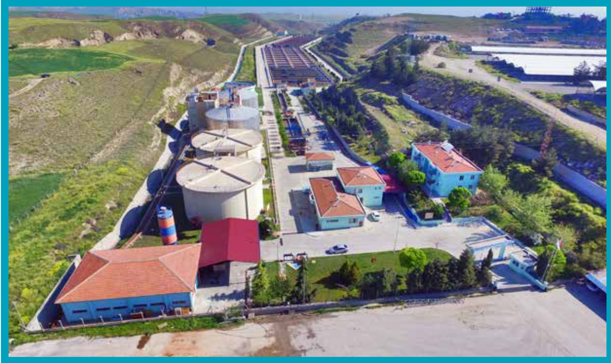
Merkez Atıksu Arıtma Tesis
