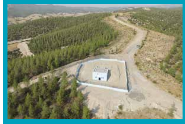
Bozkurt İlçesi Alikurt Mahallesi 500 m 3 İçmesuyu Deposu
