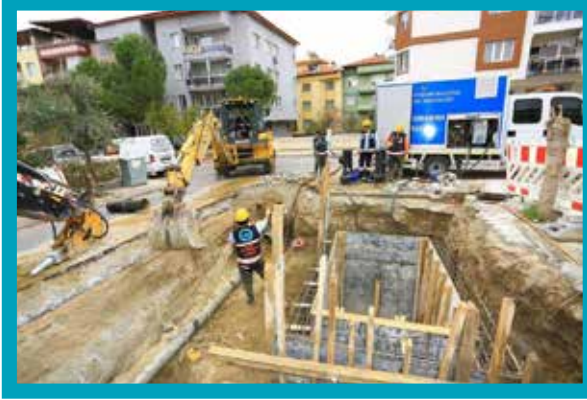
İstiklal Mahallesi İzole Bölge İçmesuyu Vana Odası İmalatı
