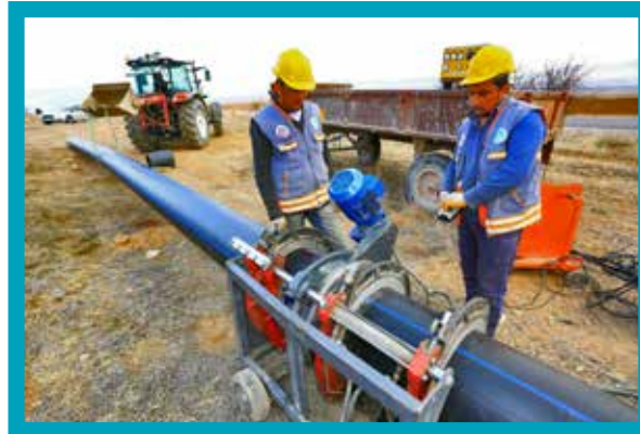
Çal, Çivril, Baklan İlçeleri Grup İçmesuyu Hattı
