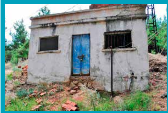
Bekilli İlçesi Merkez Mahallesinde Eski İçmesuyu Deposu
