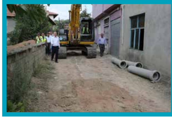
Yatağan İçmesuyu ve Kanalizasyon İnşaatı Yapılması
