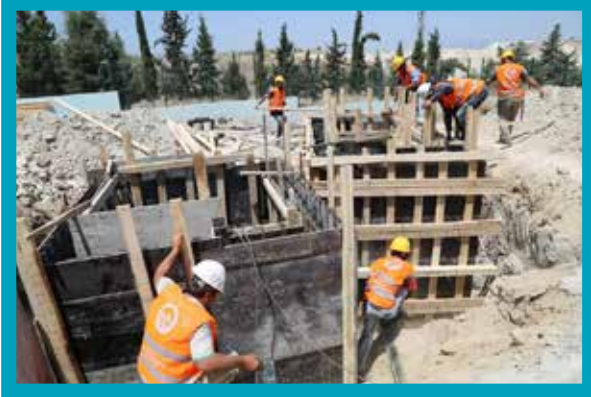
Hacıyüplü Deposu SCADA için Vana Odası İnşaatı
