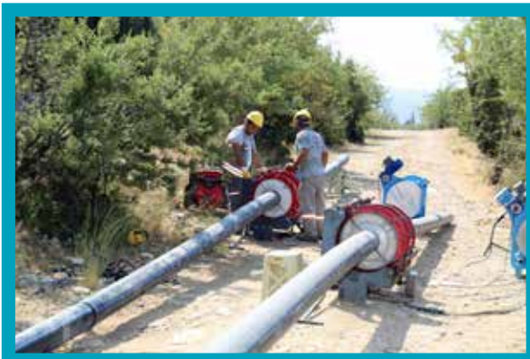
Hallaçlar Mahallesi Ana Şebeke İmalatı
