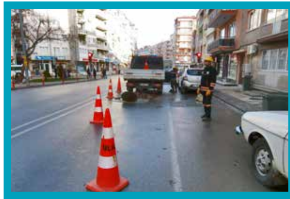
Sırapılar Mahallesi Lozan Caddesi Kanalizasyon Bacası Temizleme İşlemi
