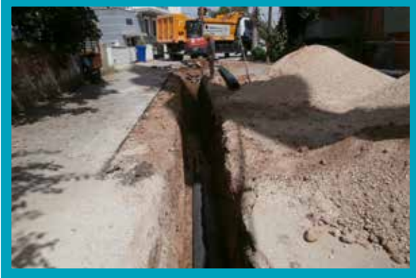
Çamlaraltı Mahallesi Kanalizasyon Hattı İmalatı
