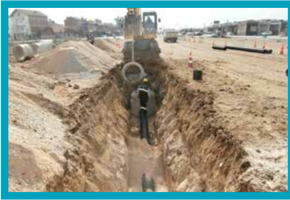
Sümer Mahallesi Kanalizasyon Hattı Yapımı
