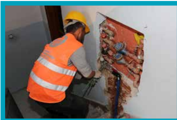
İncilipınar Mahallesi İçmesuyu Abone Bağlantısı İmalatı (Sayaca Bağlantı Yapılması)
