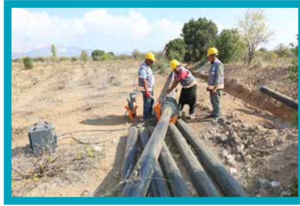
Tavas - Karahisar İçmesuyu Hattı Yapılması
