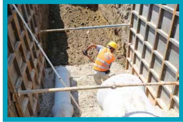
Deliktaş Mahallesi Atıksu ve Yağmursuyu Şebekesi İmalatı
