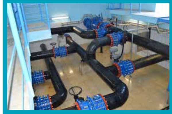
Kınıklı Taş Ocağı İçmesuyu Deposu Manevra Odası
