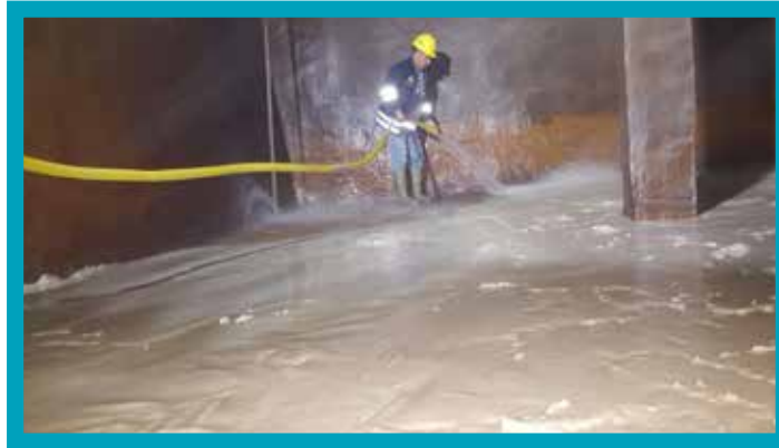
Karapınar Deposu İçmesuyu Deposu Temizlik ve Dezenfeksiyon İşlemleri
