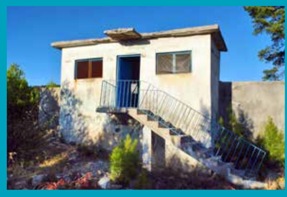
Çameli Kolak Eski İçmesuyu Deposu
