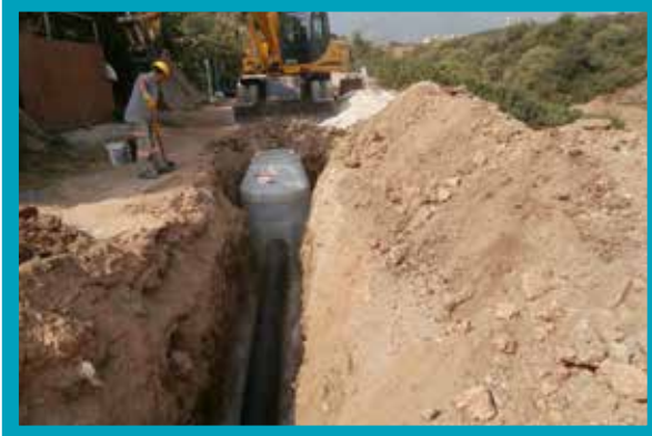
Çakmak Mahallesi Kanalizasyon Hattı İmalatı
