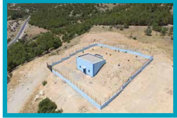
Çal İlçesi Süller Mahallesi 2.000 m 3 İçmesuyu Deposu
