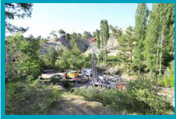
Çameli İlçesi Güzelyurt Mahallesi Sondaj Kuyusu Çalışması
