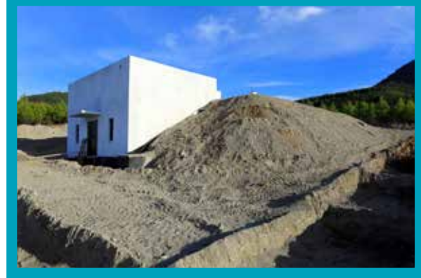
Acipayam Gölcük Yeni İçmesuyu Deposu
