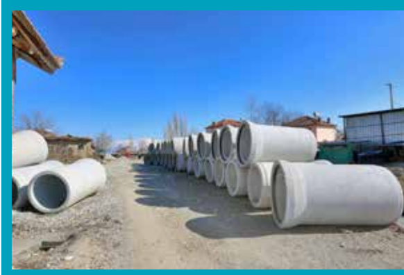
Çivril İlçesi Karayahşiler Mahallesi 800 metre Yağmursuyu Hattı Yapımı
