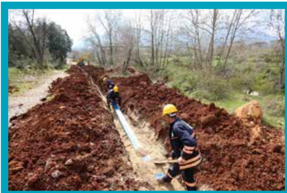
Yenişehir Mahallesi İsale Hattı İmalatı
