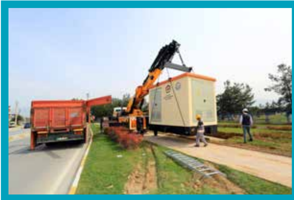
Yeni Pompalar İçin Yeni Kabin Kurulum İşİ
