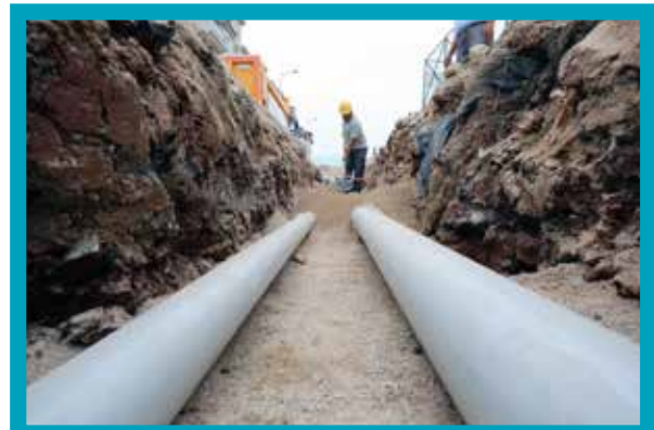
Çakmak Mahallesi Ana Şebeke İmalatı
