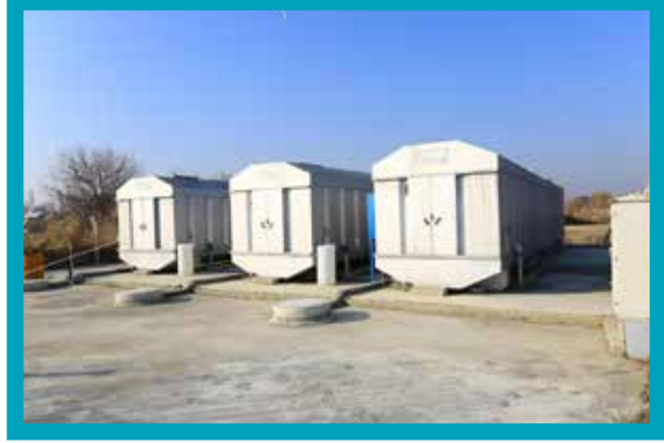
Korucuk Paket Atıksu Arıtma Tesisi
