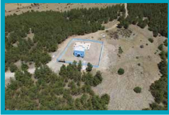
Çal İlçesi Süller Mahallesi 500 m 3 İçmesuyu Deposu
