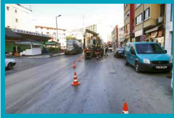
Saraylar Mahallesi Cumhuriyet Caddesi Kanal Açma ve Temizleme İşlemi
