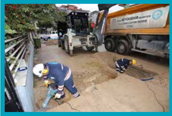
Çamlaraltı Mahallesi Abone Şube Hattı Yolu Değişimi
