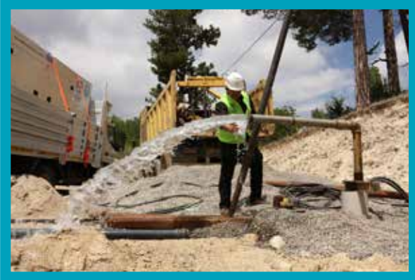
Çameli İlçesi Sofular Mahallesi Sondaj Çalışması Numune Alımı
