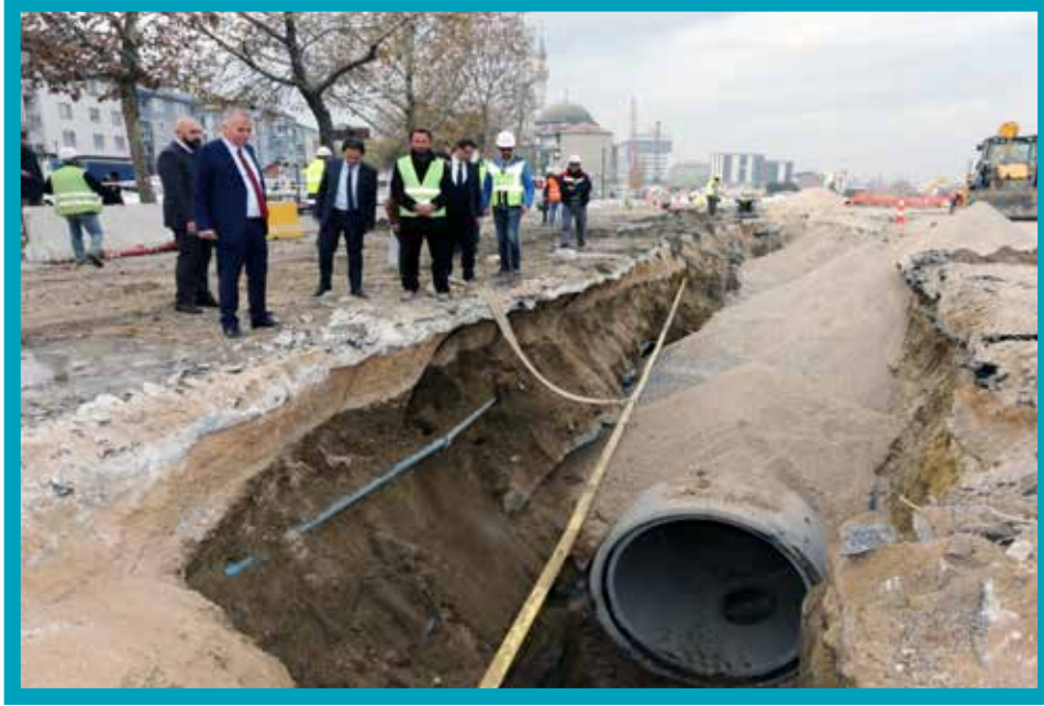
Pamukkale İlçesi Üçgen Altyapı Çalışması İncelemesi
