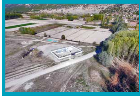
Çivril Beydilli Paket Atıksu Arıtma Tesisi
