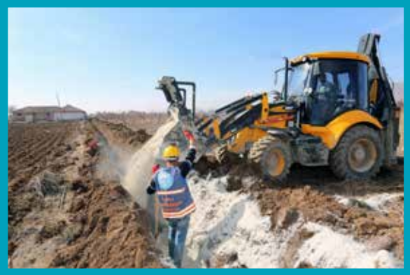
Çivril İlçesi Yamanlar Mahallesi İçmesuyu Hattı Yapımı
