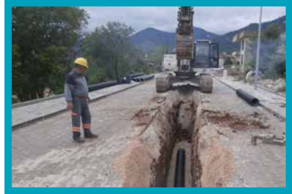
Başkarcı Mahallesi Kanalizasyon Hattı İmalatı
