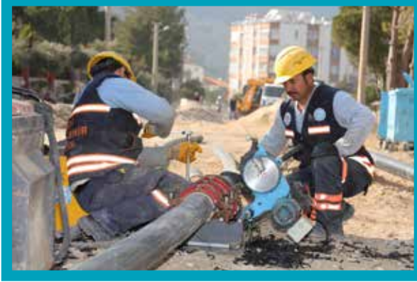
1200 Evler Mahallesi İçmesuyu İmalatı
