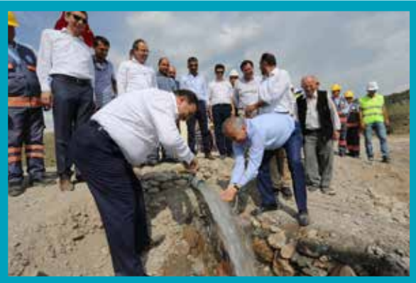
Honaz İlçesi Kocabaş Mahallesi Sondaj Kuyusu Pompa Tecrübesi
