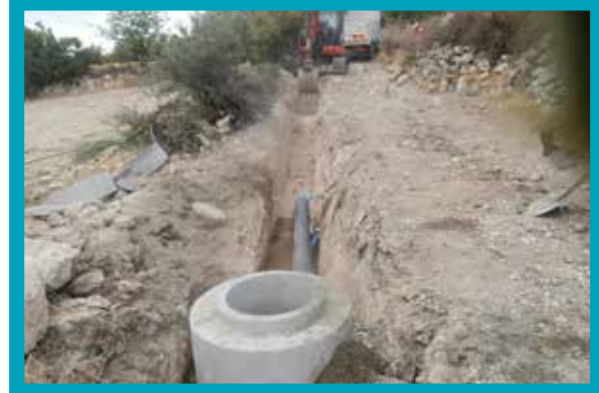
Belenardıç Mahallesi Kanalizasyon Hattı İmalatı
