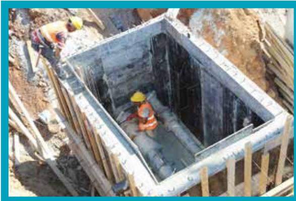
Akça Deposu SCADA için Vana Odası İnşaatı
