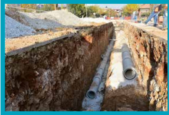
Kazım Kaynak Caddesi Atıksu ve Yağmursuyu Şebekesi İmalatı
