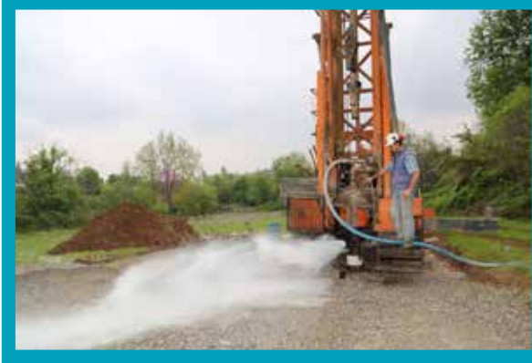
Pamukkale İlçesi Zeytinköy Mahallesi Sondaj Kuyusu İnkişafı
