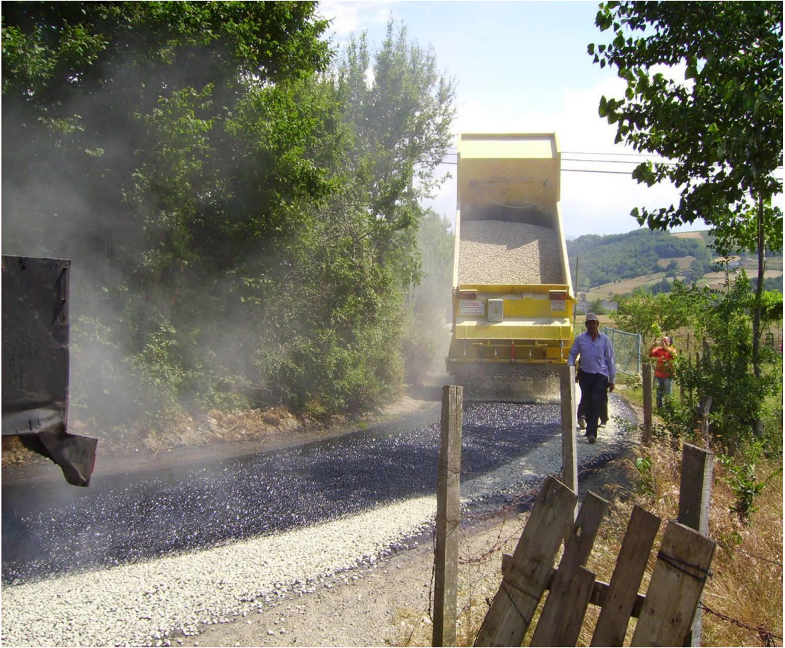
YOL AÇILMASI VE ASFALT KAPLAMA ÇALIŞMALARINDAN GÖRÜNTÜLER
