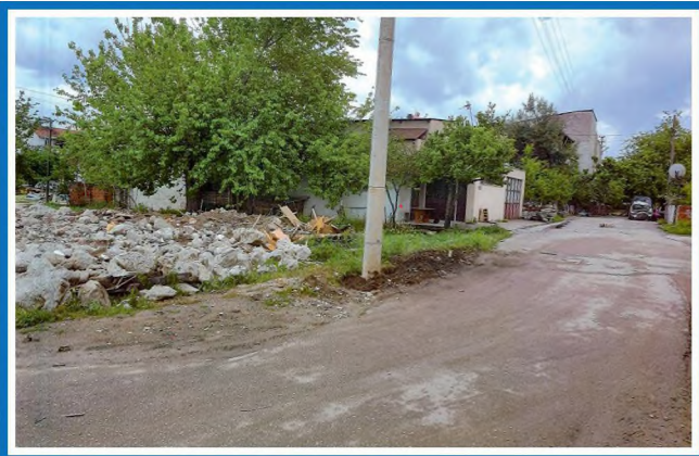
3- İmar planında yolda kalan Sümer Mahallesi 2505 Sokak No:23 adresindeki bulunan 2 katlı bina kamulaştırılmıştır.
