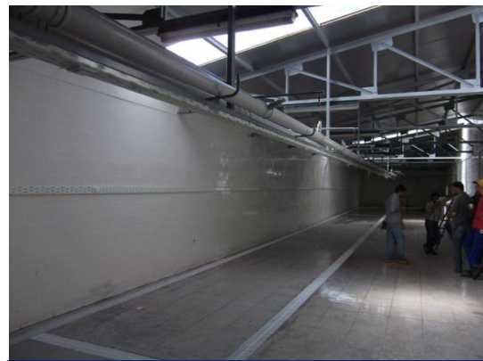
Su Ürünleri Fakültesi Kapalı Devre Balık Üretim Tesisi Onarımı
