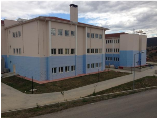
Boyabat MYO ve İ.İ.B.F. Binaları Dış Cephe Mantolaması
