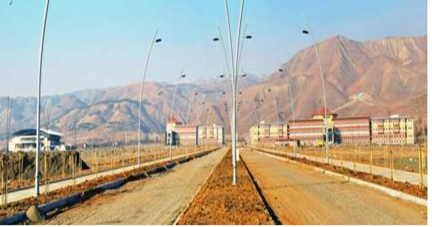
Şekil 1. İnşaatı devam eden Yanlızbağ yerleşkemizden bir görünüm.
