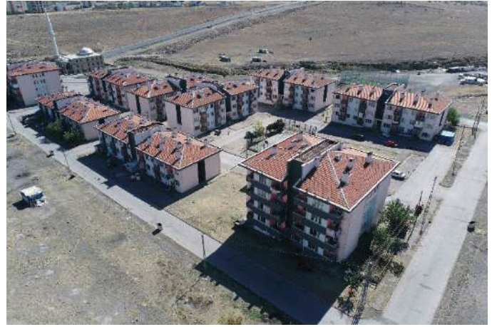
BAHÇELİEVLER MAHALLESİ 1786 ADA 1 PARSELDE BULUNAN MÜLKİYETİ BELEDİYEMİZE AİT SOSYAL KONUTLARIN DIŞ CEPHESİNİN BOYANMASI İŞİ
