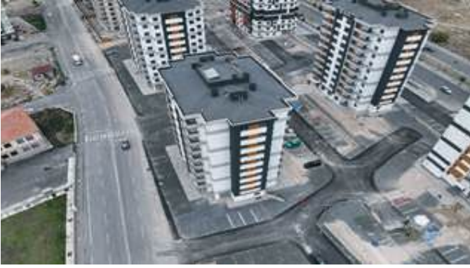
Yıldırım Beyazıt Mahalesi Dr.Sami İpek Caddesi İle Şükran Caddesi Arasında Kalan Kentsel Dönüşüm Konutlarının Çevre Düzenlemesi Yapılması İşi
