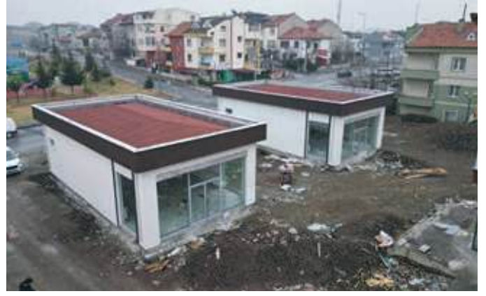
Selçuklu Mahallesi Açkalmaz Sokak Üzerine 2 Adet Eczane Yapılması İşi
