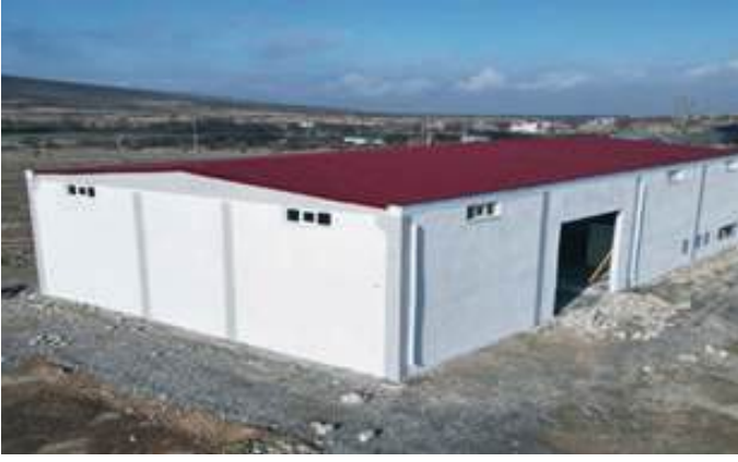
Gesi Kayabağ Mah. Prefabrik Tarım Ekipmanları Binası Yapılması İşi
