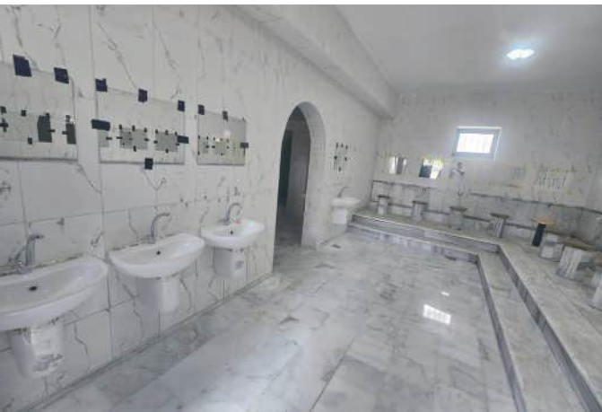
2024 YILI 2.ETAP MUHTELİF WC TAMİRLERİNİN YAPILMASI İŞİ
