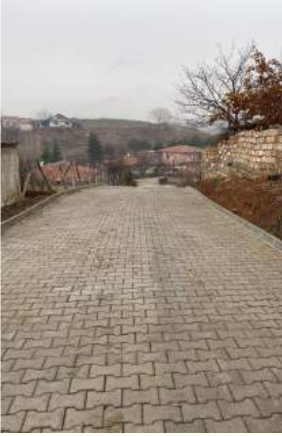
BAĞLARBAŞI 887 SOKAK YAPIM İŞİ
