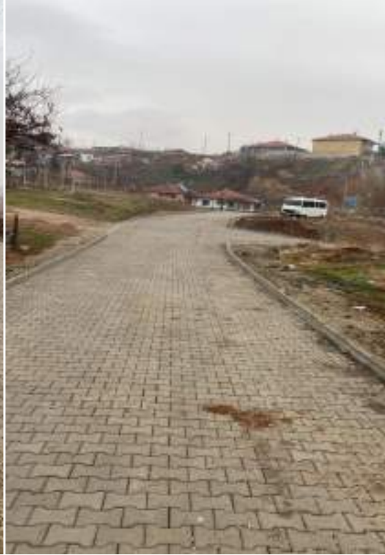
BAĞLARBAŞI 893 SOKAK YAPIM İŞİ
