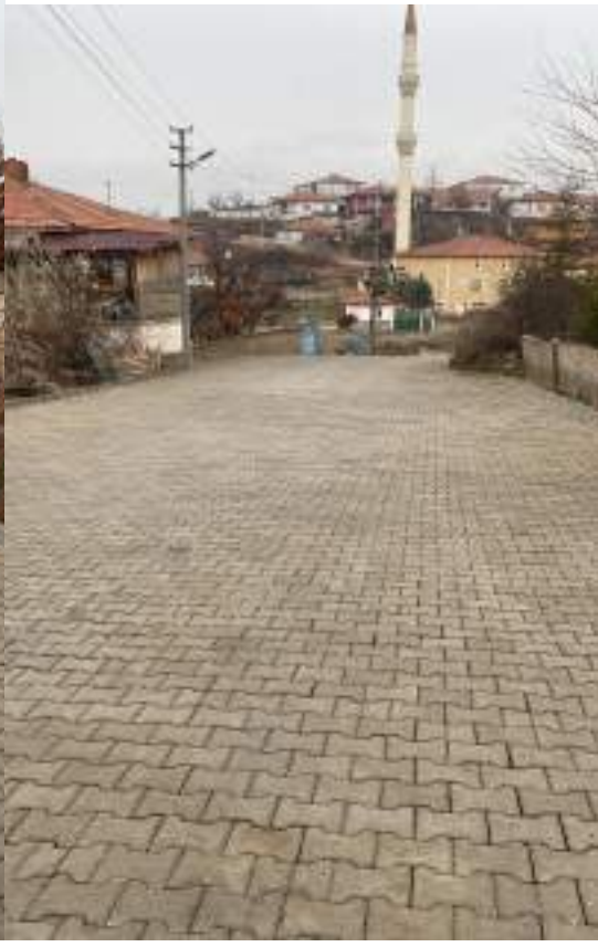
BAĞLARBAŞI 888 SOKAK YAPIM İŞİ
