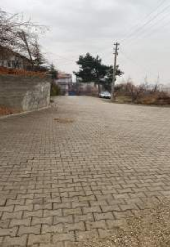
BAĞLARBAŞI 892 SOKAK YAPIM İŞİ
