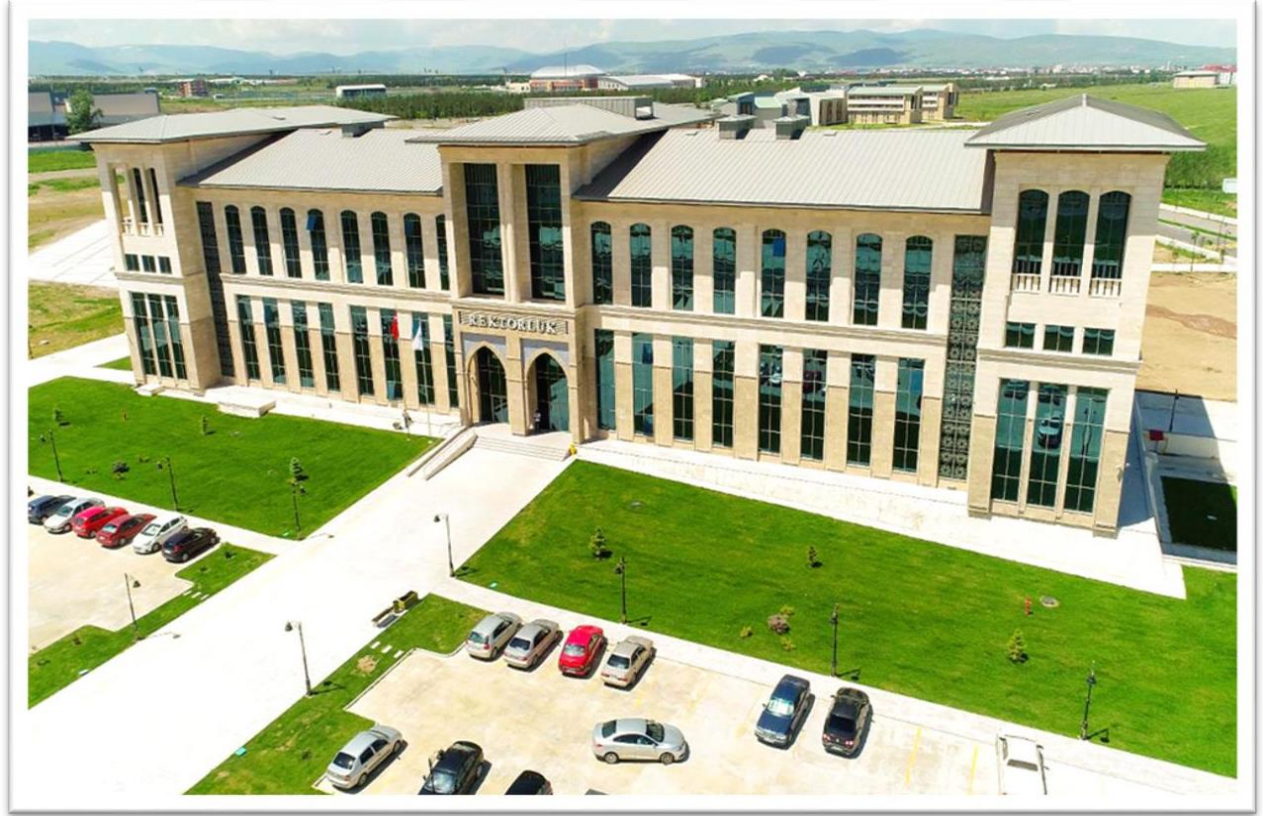
Resim 1: Rektörlük Binasından Görünüm
