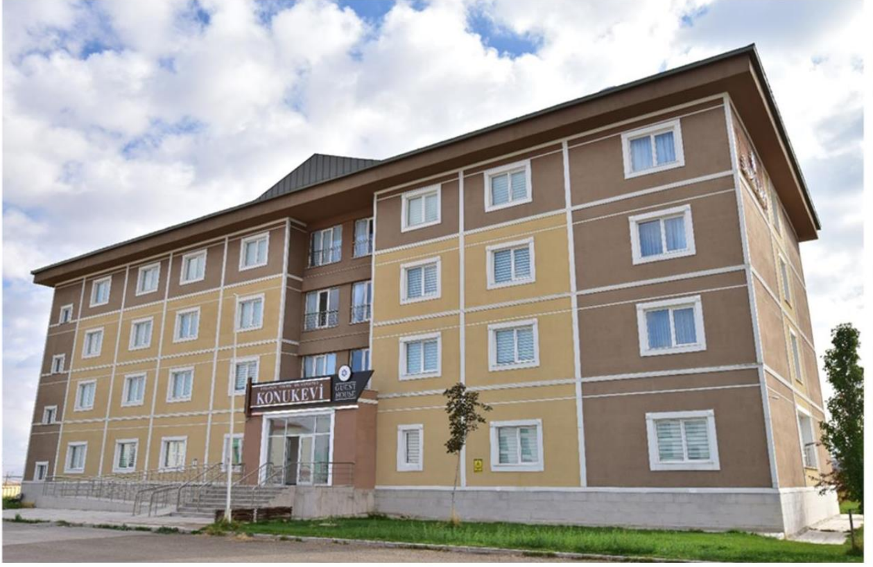
Resim 12: Konukevi Binasından İç ve Dış Görünüm
