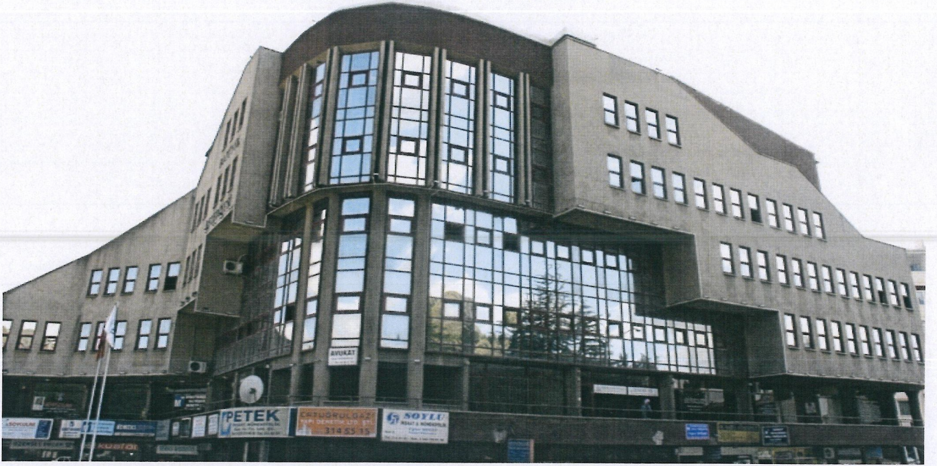
Belediye Merkez Binası
