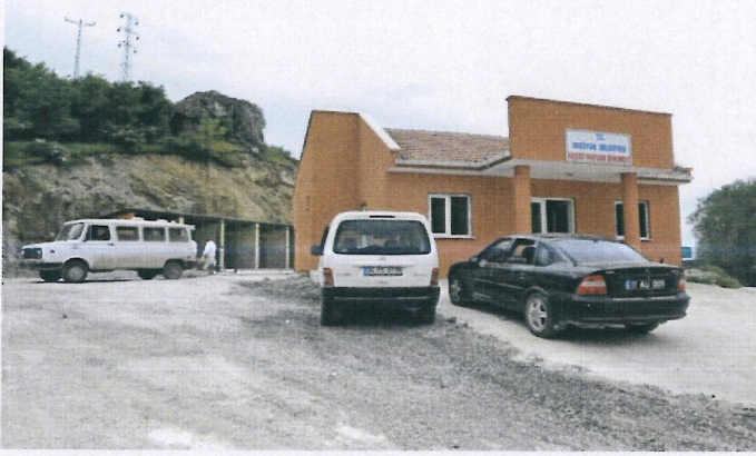
Hayvan Bakım Evi
