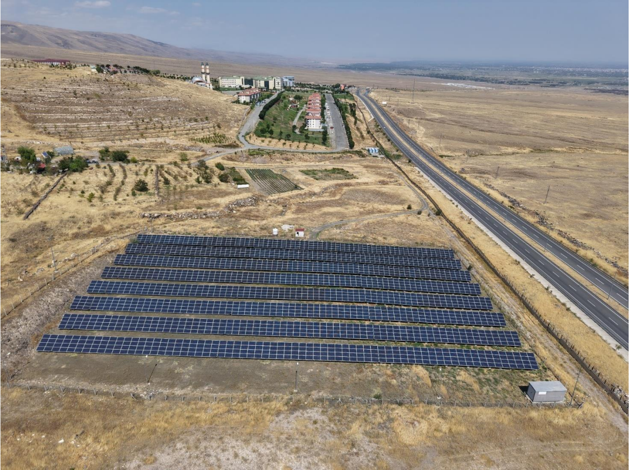
Resim-11 Güneş Enerjisi Santrali
