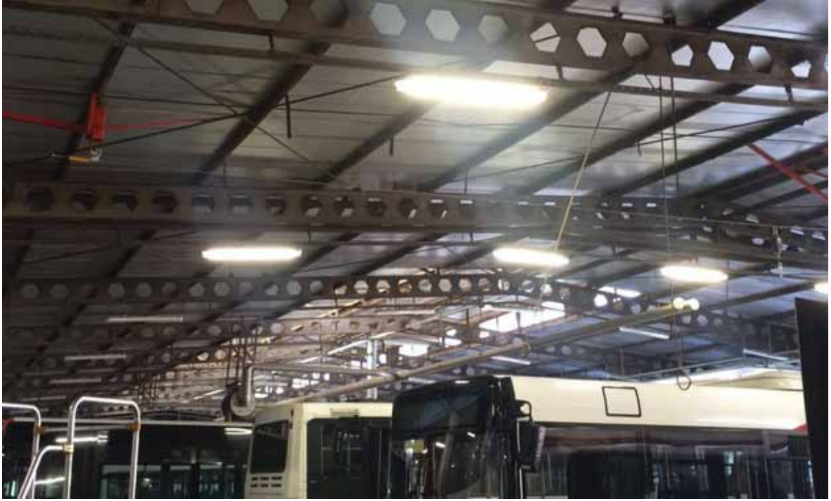
Atölye Çatılarının Eski Hali
