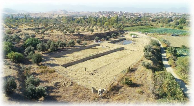
Sarayköy Duacılı Doğal Arıtma Tesisi
