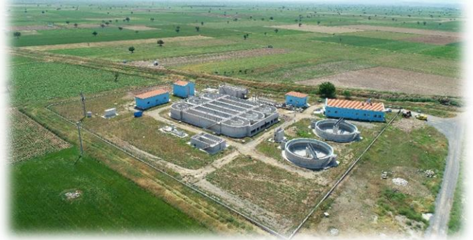
Tavas Atıksu Arıtma Tesisi
