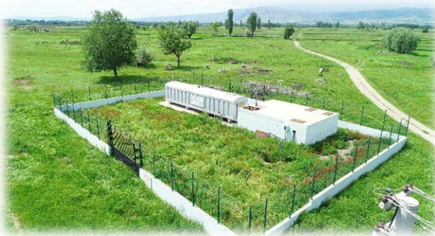
Çivril Beydilli Paket Atıksu Arıtma Tesisi
