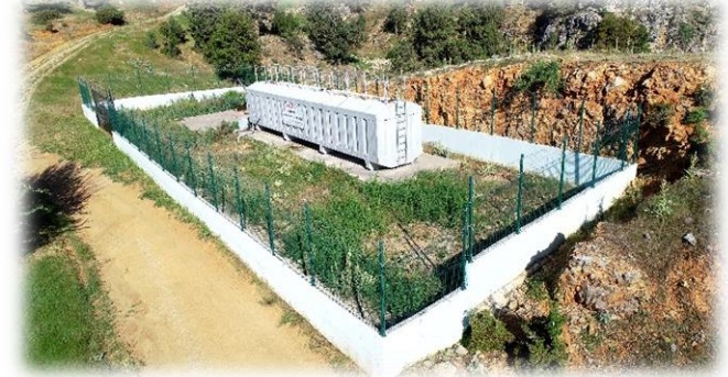
Acıpayam Eskişehir Paket Atıksu Arıtma Tesisi
