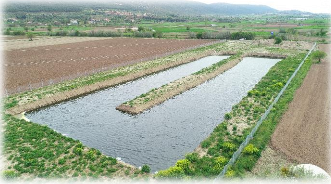
Tavas Baharlar Doğal Atıksu Arıtma Tesisi
