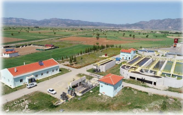
Acıpayam Atıksu Arıtma Tesisi
