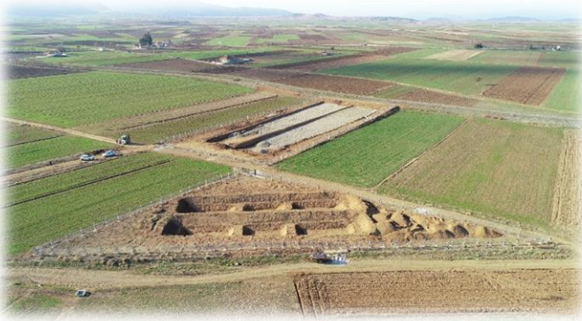
Çardak Beylerbeyi Doğal Arıtma Tesisi
