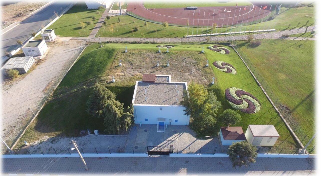
Merkezefendi-Şirinevler İçmesuyu Deposu
