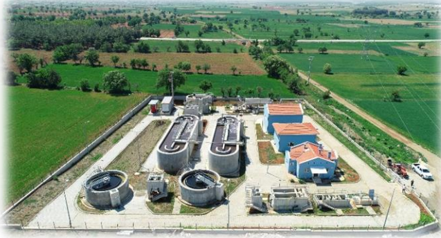
Baklan Atıksu Arıtma Tesisi
