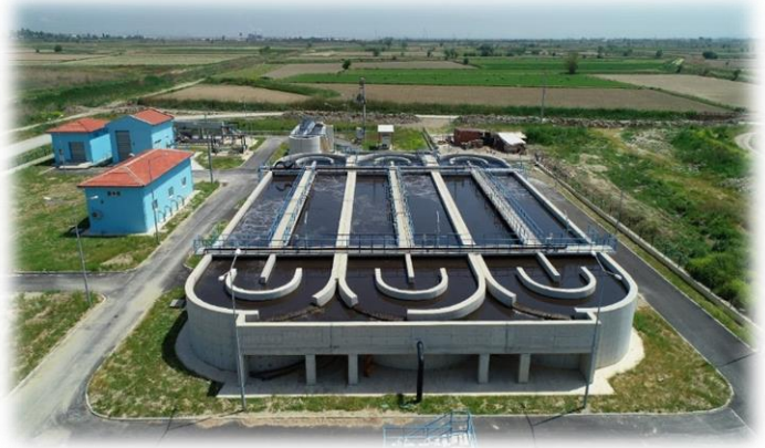
Sarayköy Atıksu Arıtma Tesisi
