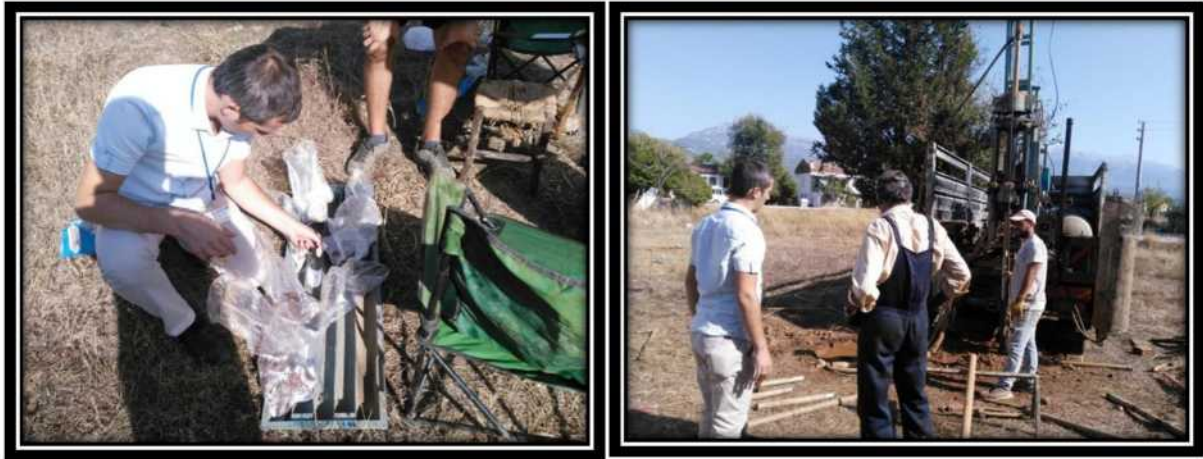
Foto-3: Zemin Etüt Çalışmalarından Bir Görünüm
