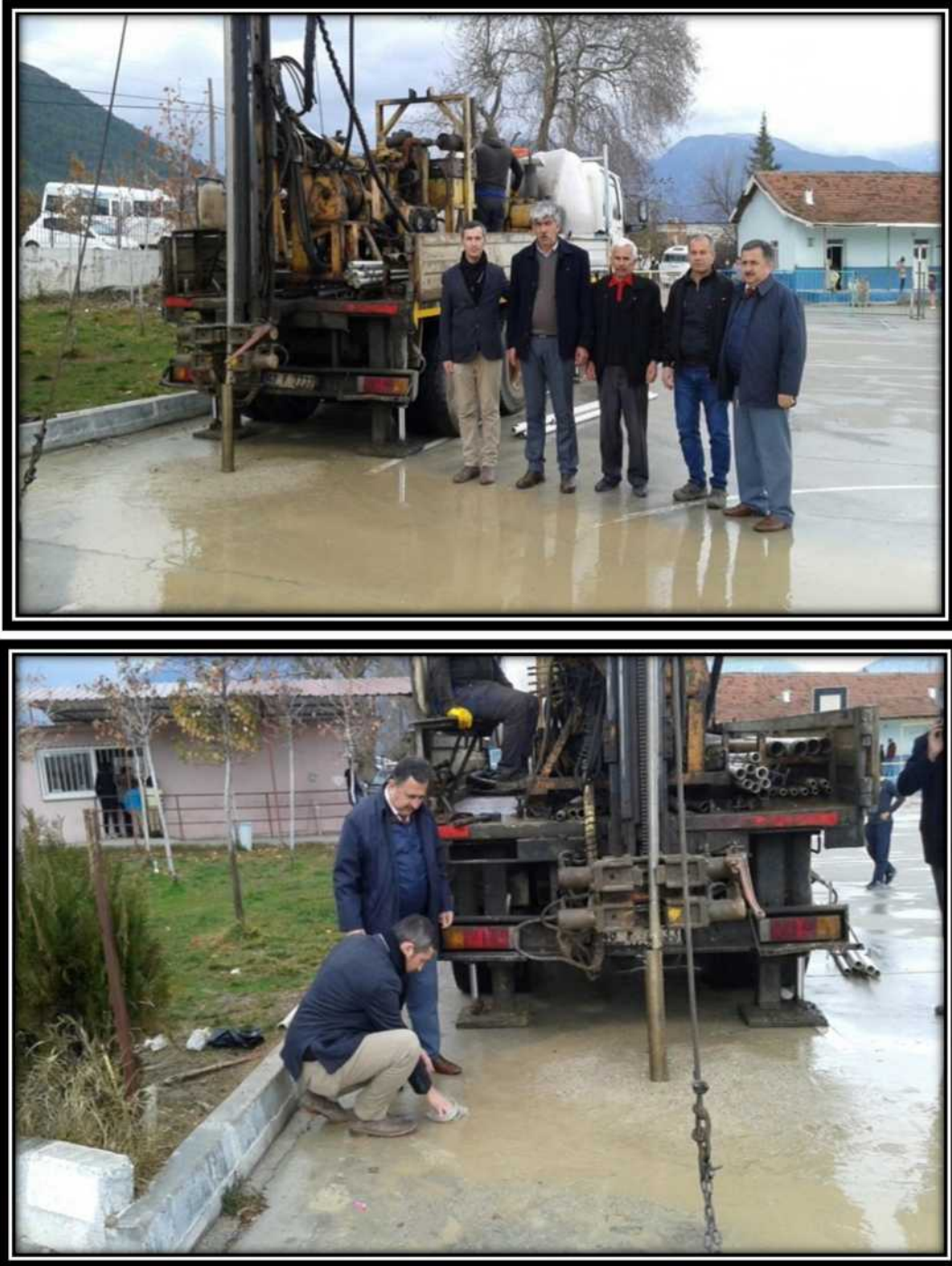
Foto-1: Ortaköy Mahallesi İlkokul-Ortaokul Alanında Yapılan Jeolojik ve Jeoteknik Etüt Çalışmalarından Bir Görünüm
