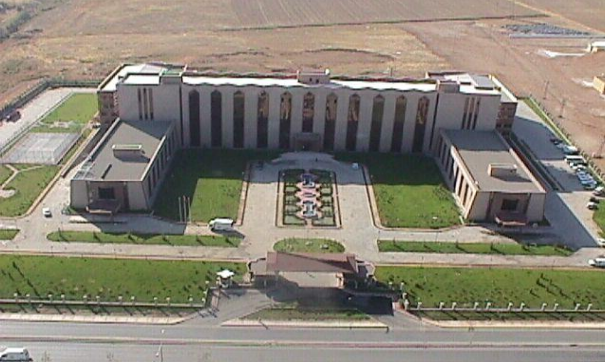
Resim 2- Başkanlık Hizmet Binası (Üstten Görünüm)
