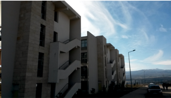
AKTULUK YERLEŞKEMİZDEKİ BİNALARIN YANGIN MERDİVENLERİNİN SUDAN KORUNMASI İÇİN ÜSTÜ KAPATILDI.
