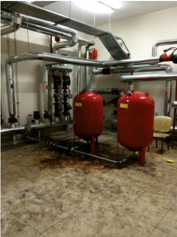
ÜNİVERSİTEMİZ AKTULUK YERLEŞKESİNDE BULUNAN BİNALARA ISINMANIN DAHA SAĞLIKLI YAPILABİLMESİ İÇİN GENLEŞME TANKI TAKILDI.
