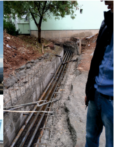
ATATÜRK MAHALLESİNDE BULUNAN REKTÖRLÜK KONUTUNDA SİSTEMİN DAHA İYİ ÇALIŞMASI İÇİN ISI KANALI YAPILDI.
