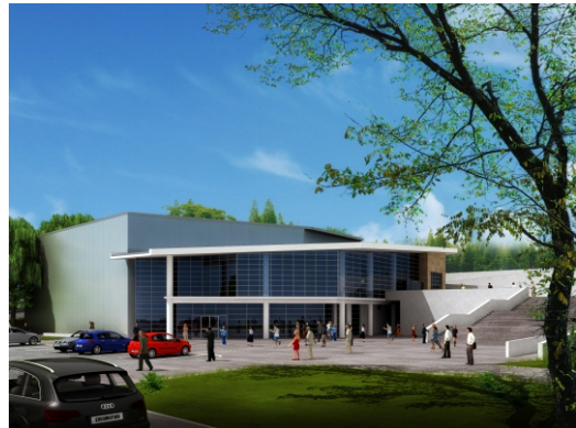
KAPALI YÜZME HAVUZU
