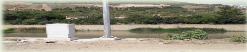
Şirin Taşıt Köprüsü Yapımı
