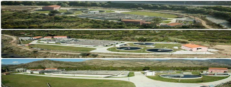
(Amasya Atıksu Arıtma Tesisi)
