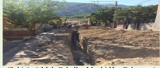
(Şehirüstü Mah.Çakallar Mevki.Hat Çalışması)
