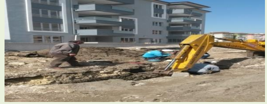
(Şeyhcu Mah. Kanalizasyon çalışması)
