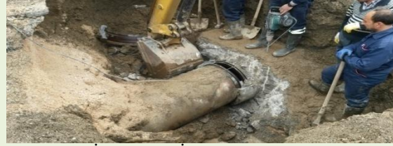
(Akdağ İçme suyu .İçme Suyu hat çalışması)
