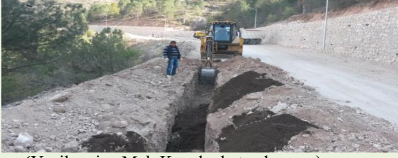
(Yeşilyenice Mah.Kanaliz. hat çalışması)
