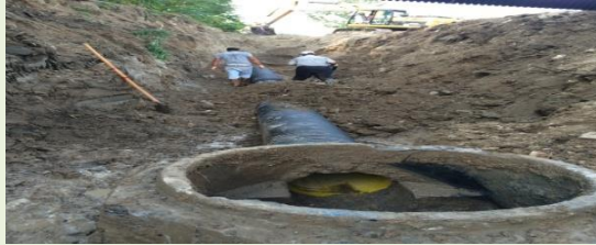
(Kanalizasyon hat ve baca tamirat çalışması)
