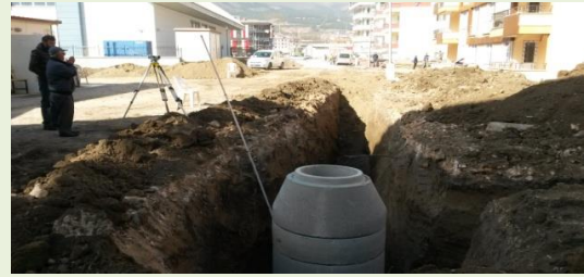
(Hızırpaşa Mah.Stad Yanı Kanalizasyon çalışması)
