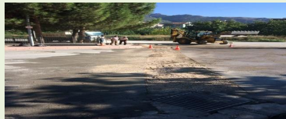
(İçme Suyu hattına DMA yapılması)
