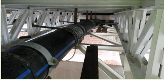
(Depolar arası İçme Suyu hat tamirati )
