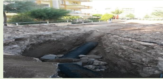
(Kanalizasyon tamirat çalışması)
