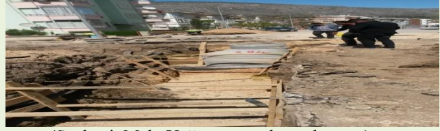
(Şeyhcu Mah. Yağmur suyu hat çalışması)
