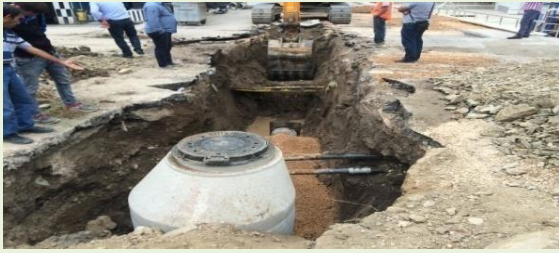
(HacılarMeydanı Mah. Kanalizasyon çalışması)
