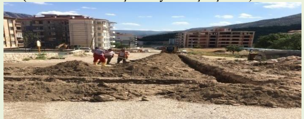
(Şeyhcu Mah.İçme Suyu hat çalışması)
