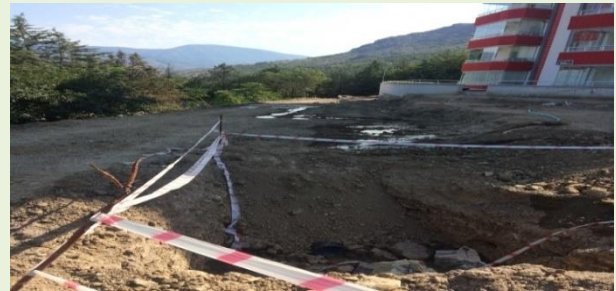
(KirazlıdereMah. Kanalizasyon hat çalışması)
