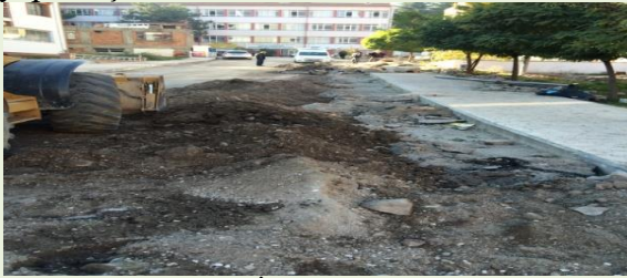
(Bahçeleriçi Mah.İçme suyu hat çalışması)
