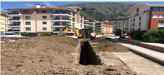
(Hızırpaşa Mah.Yağmur suyu hat çalışması)
