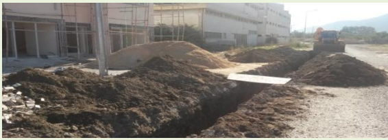
(HacılarMeydanı Mah.İçme suyu hat çalışması )
