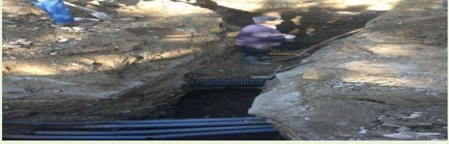
(HacılarMeydanı Mah.Yağmur suyu hat çalışması)
