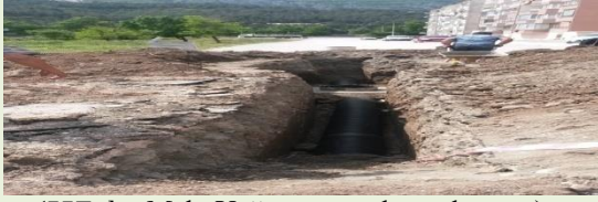
(55Evler Mah. Yağmur suyu hat çalışması)
