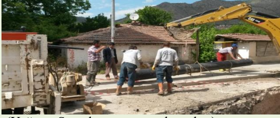
(Yağmur Suyu hattı yapım çalışmaları)
