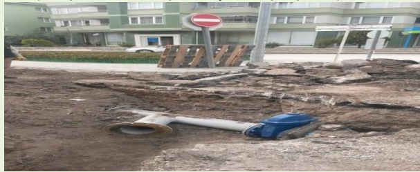
(Hacılar meydanı Mah. İçme suyu hat çalışması)
