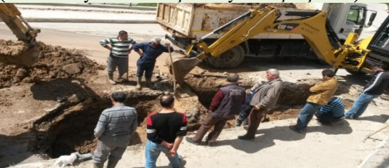
(Hızırpaşa Mah. İçme suyu hat çalışması)
