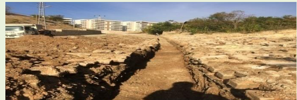
(Kirazlıdere Mah.İçme suyu hat çalışması )
