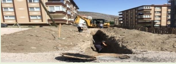
(Şeyhcu Mah. Kanalizasyon çalışması)
