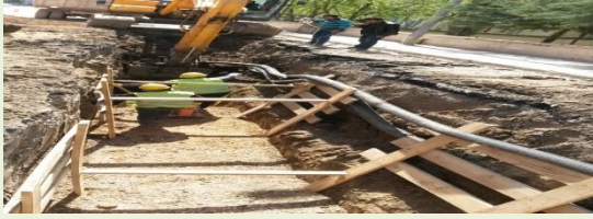
(Helvacı Mah. Yağmur suyu hat çalışması)
