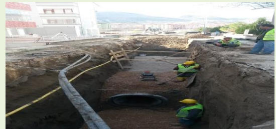
(Hacılar Meydanı Mah. Yağmur suyu hat çalışması)
