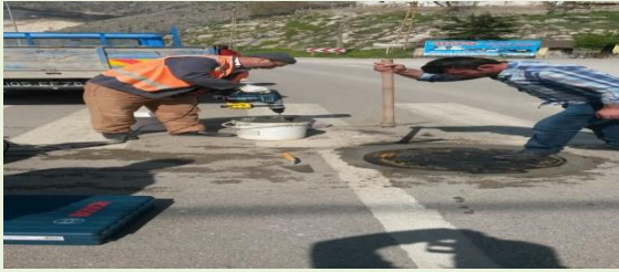
(Helvacı Mah. Kanalizasyon çalışması)
