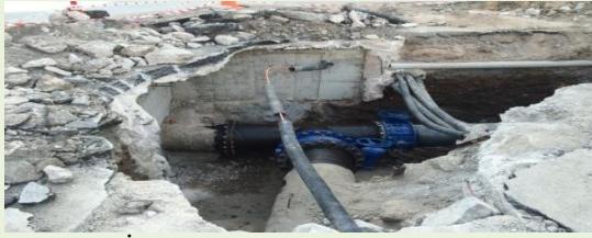
(İçme Suyu hat tamirati)
