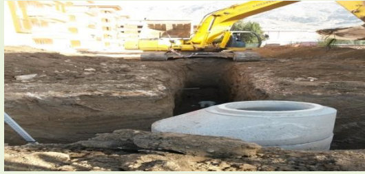
(HızırpaşaMah. Kanalizasyon çalışması)
