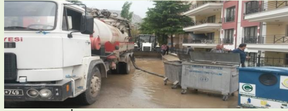
(İçme Suyu arıza çalışması)
