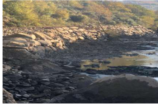
19 Mayıs Kuşkaya Arıtma Yolu Heyelan Kaldırma ve Taş Tahkimat Çalışması
