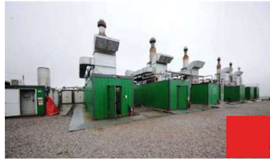
Metan Gazından Elektrik Üreten Makinalar
