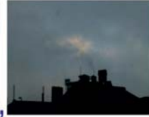
Kömür Yanarken, Fanı Kapatılmış Kalorifer Kazanlı Aynı bina
