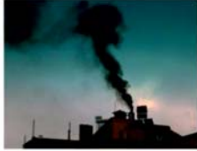
Kömür Yanarken Fanı Çalışan Kalorifer Kazanlı Bina
