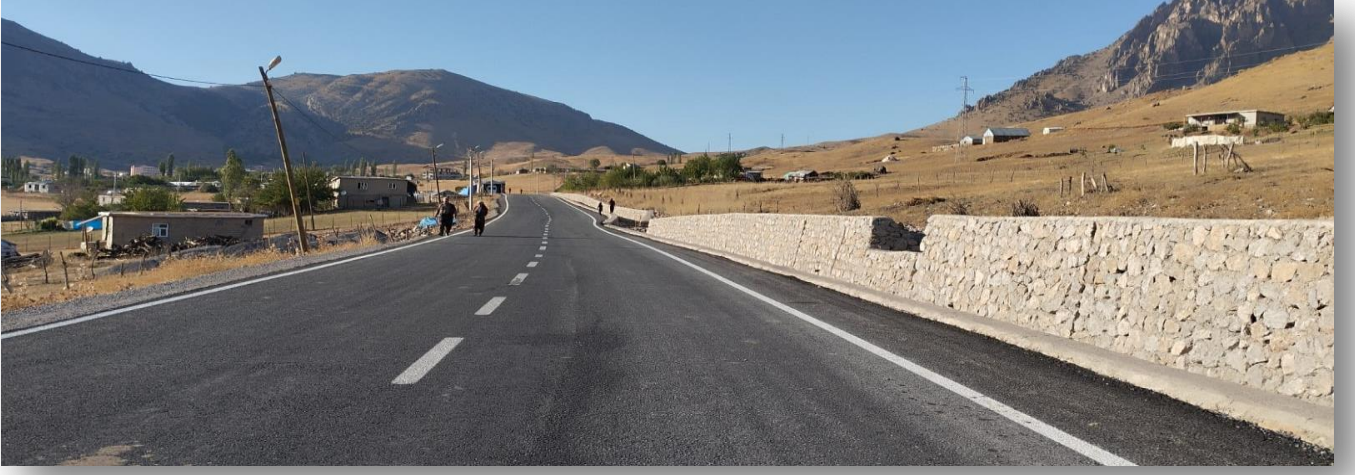
Pervari Doğan 1. Etap Yol Projesi
