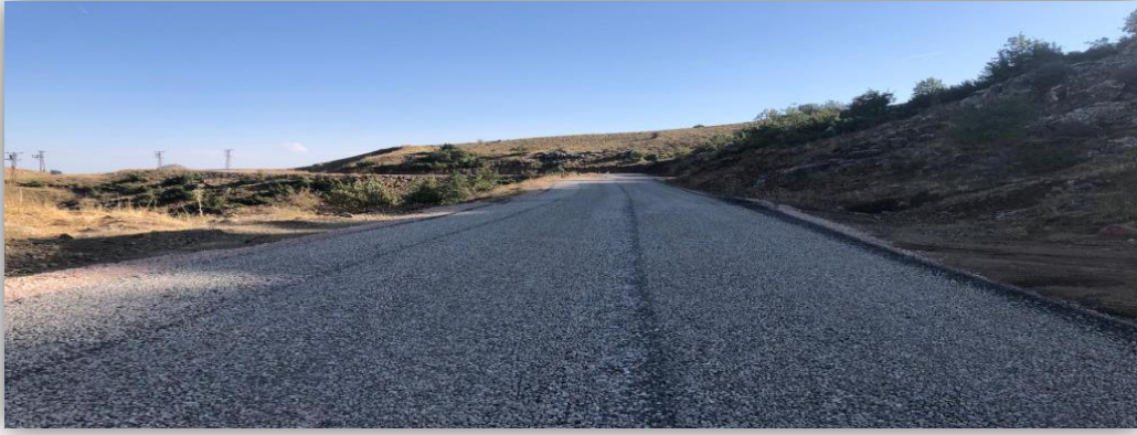
Siirt Şirvan İlçesi Adıgüzel- İncakaya köyleri 1.kat sathi kaplama ve kilitli parke yapım işi
