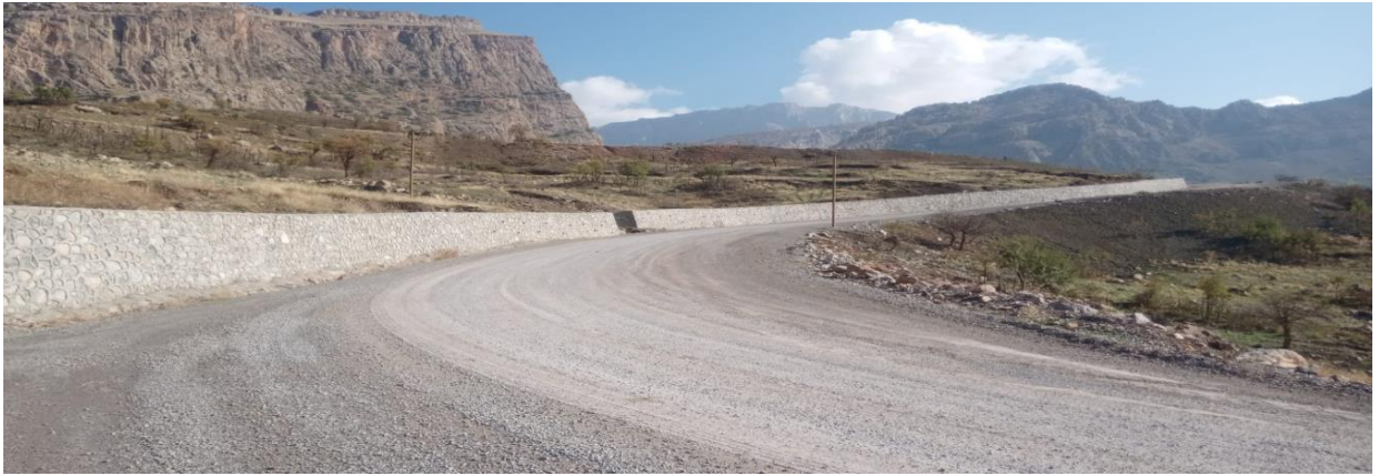
Pervari-Doğan 1. Etap 2. Bölüm Yol Projesi Yapılm İşİ
