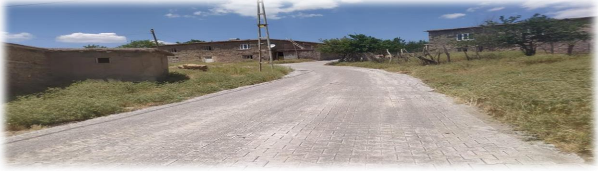
Pervari İlçesi Muhtelif Köyler 8 CM Kilitli Parke Yapım İşi
