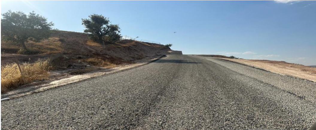
Siirt Merkez Bayraktepe – Kemerli –Tuzkuyusu Yurt Mezrası Yolları Toprak İş, Sanat Yapıları ve Asfalt Sathi Kaplama İş
