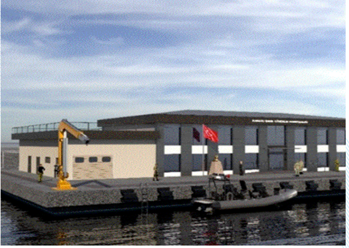
SG Karasu Karakol Komutanlığı İnşaâtı
