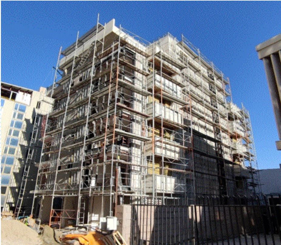
SG Ankara Vardiya Yatakhane İnşaatı
