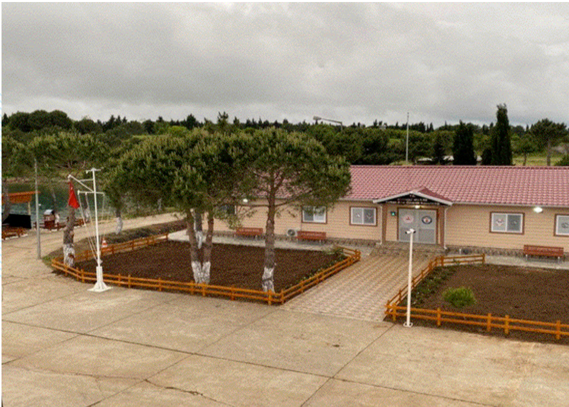
SG Kefken Sahil Destek Tesisi
