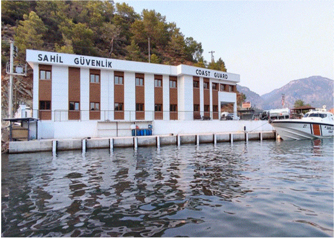
SG Fethiye Karakol Binası
