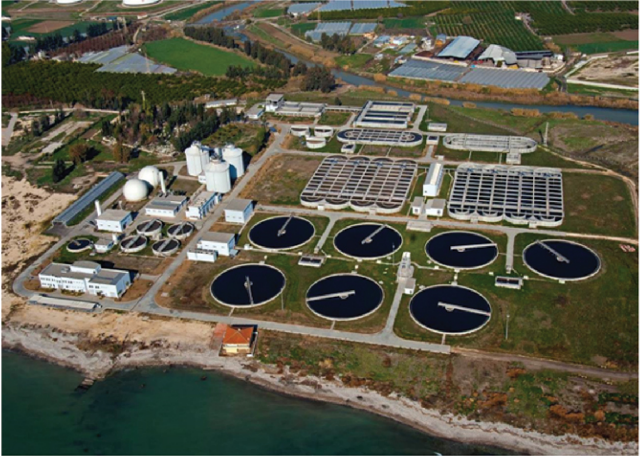
Şekil 1. Karaduvar Atık su Arıtma Tesisi
