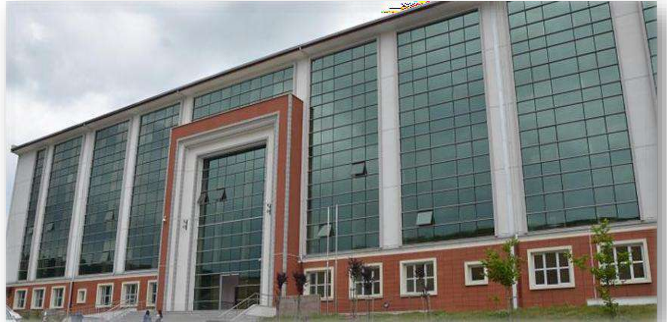
İslami İlimler Fakültesi İdari Binası
