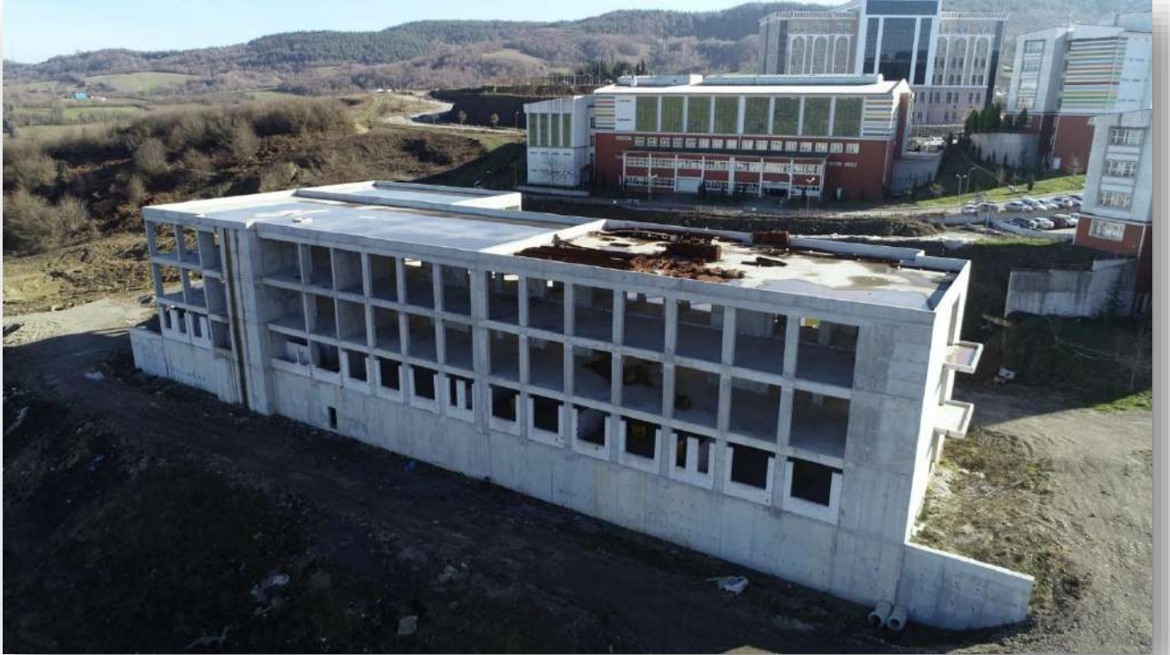
Yeni laboratuvar Binası
