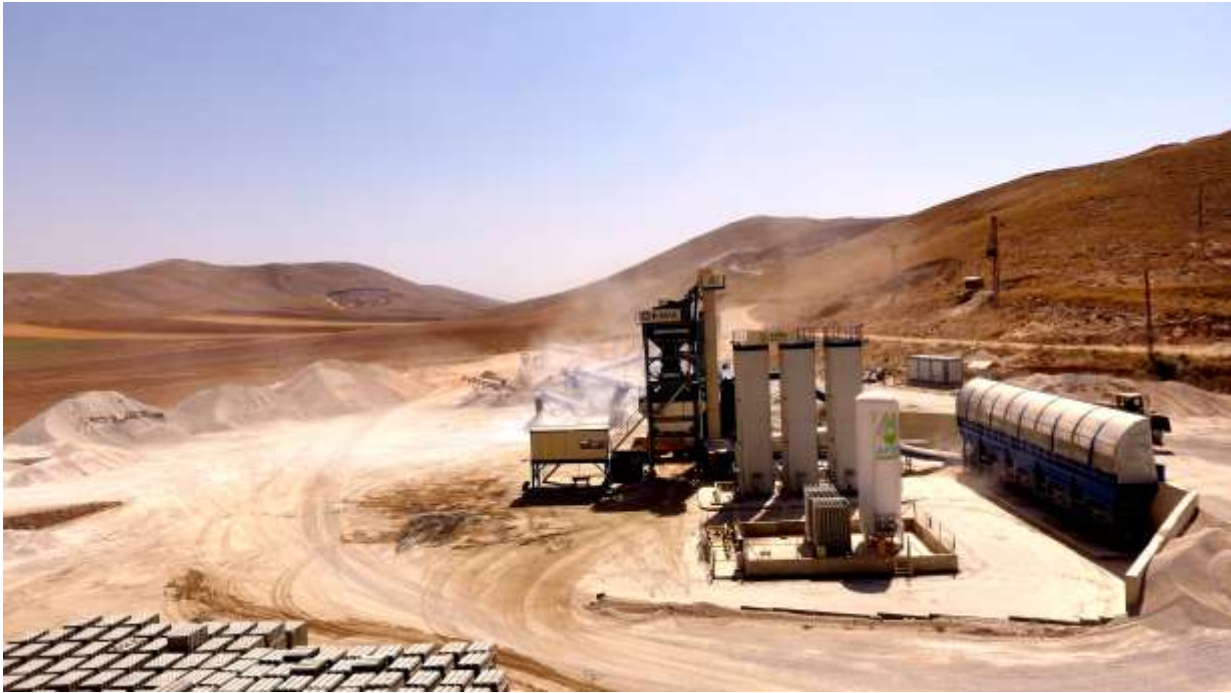
-Afşin'e Kazandırdığımız 160 Ton Üretim Kapasitesine Sahip Asfalt Plenti-
