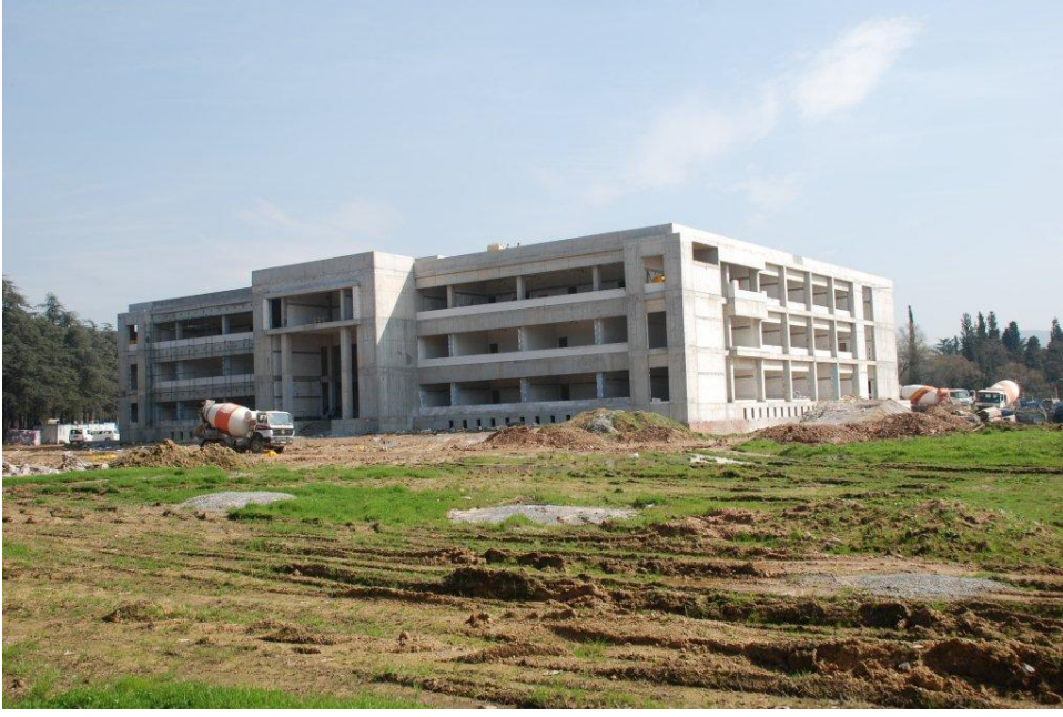
Malzeme Mühendisliği Bölümü İnşaatı Ön ve Sağ Yan Cephe Görünüşü
