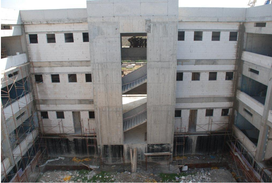
Malzeme Mühendisliği Bölümü İnşaatı İç Avlu Görünüşü
