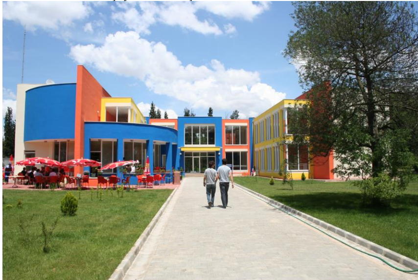
Çayırova Yerleşkesi Ana Kantin Binası
