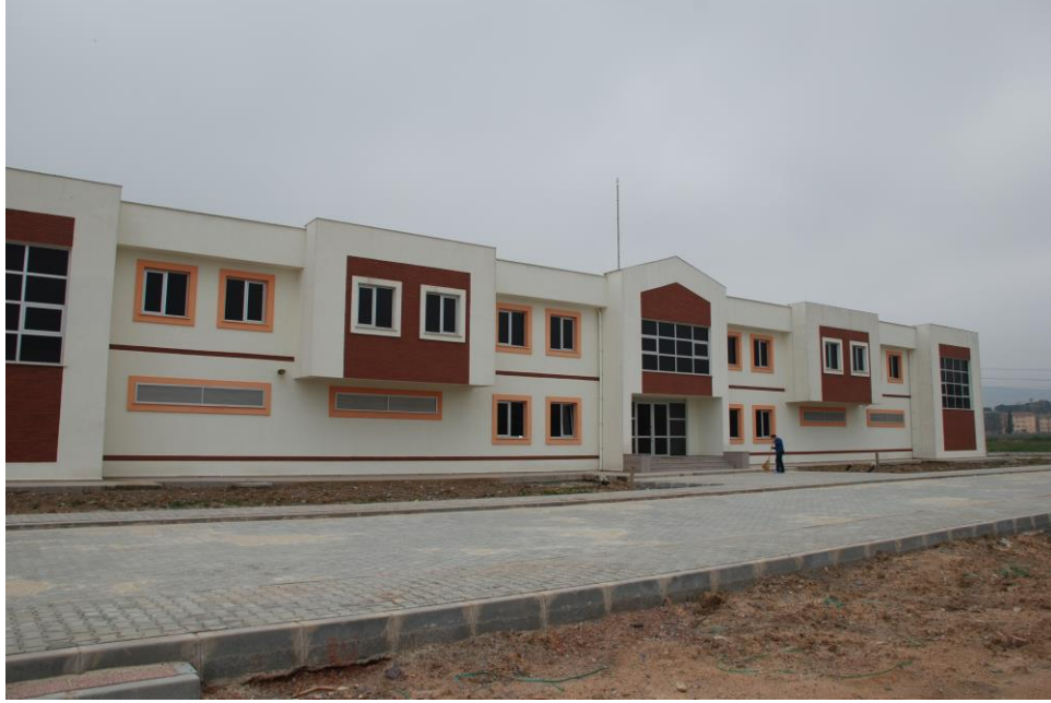
500 Kişilik Kapalı Spor Salonu Arka Cephe Görünüşü
