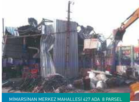
MIMARSINAN MERKEZ MAHALLESİ 427 ADA 8 PARSEL
