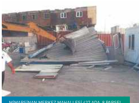
MIMARSINAN MERKEZ MAHALLESİ 427 ADA 8 PARSEL
