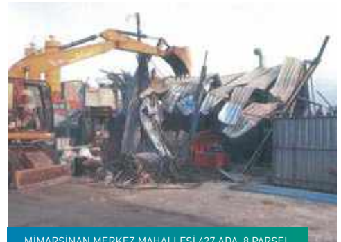
MIMARSINAN MERKEZ MAHALLESİ 427 ADA 8 PARSEL
