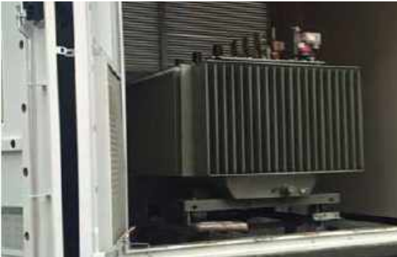
■ FATİH MAHALLESİ CENGİZ TOPEL CADDESİ BETON KÖŞK TRAFİKO KONULMASI
