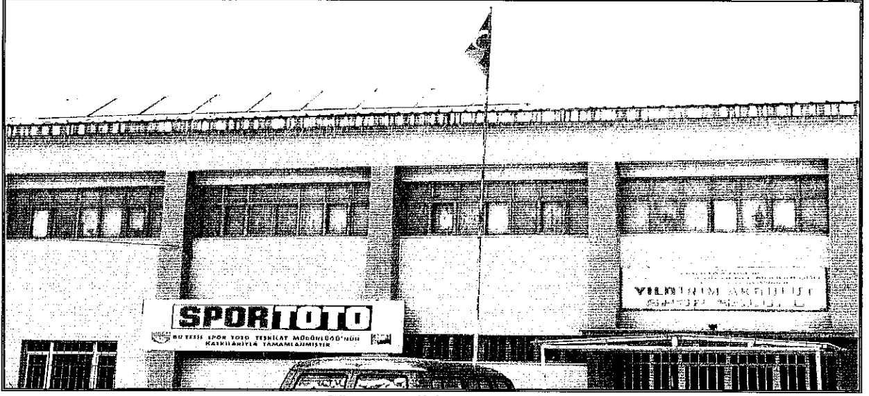
Güneş Enerjisi Kolektörleri
