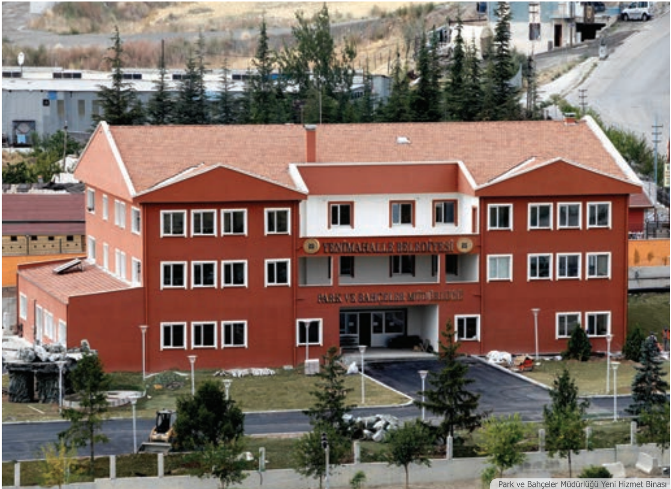
Park ve Bahçeler Müdürlüğü Yeni Hizmet Binası
