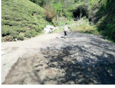
Yol Betonlama Çalışması
