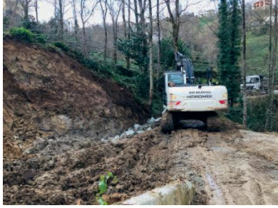
Taş Duvar Çalışması
