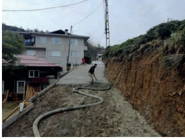
Yol Betonlama Çalışması
