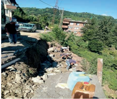
Taş Duvar Çalışması
