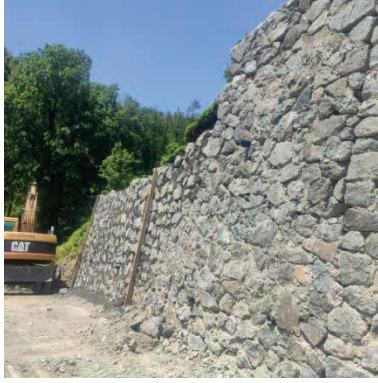
Taş Duvar Çalışması
