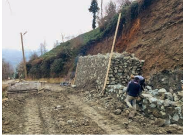
Taş Duvar Çalışması
