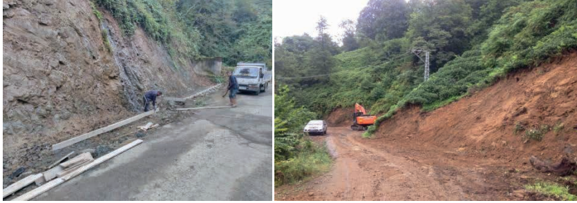
Perde Duvar Çalışması
