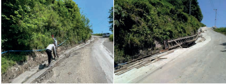
Perde Duvar Çalışması
