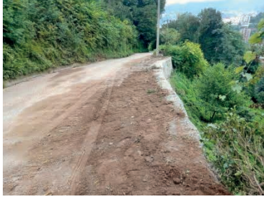
Taş Duvar Çalışması
