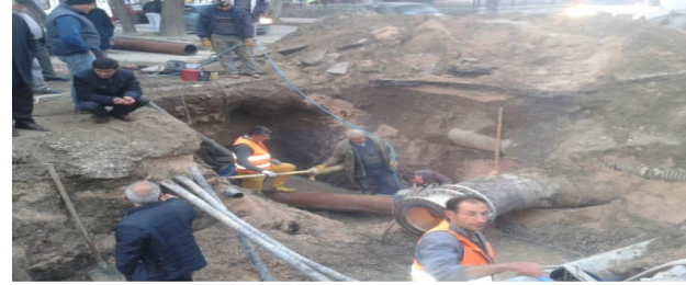
( Hızırpaşa İçme suyu hat çalışması)
