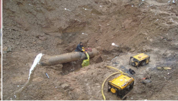
(İçme Suyu tamirâtı)
