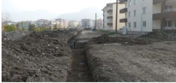
(Hacılar Meydanı Mah.İçme suyu hat çalışması)
