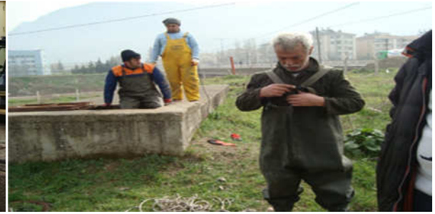
(Kanalizasyon terfi merkezi temizliği)
