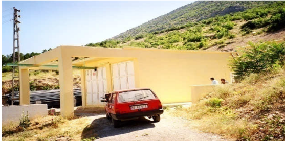
(İçme suyu klor deposu bakım ve onarımı)
