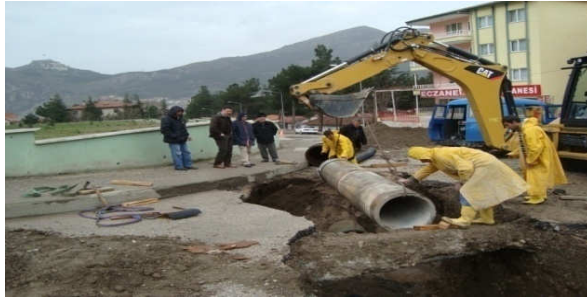
( İçme Suyu tamirâtı )
