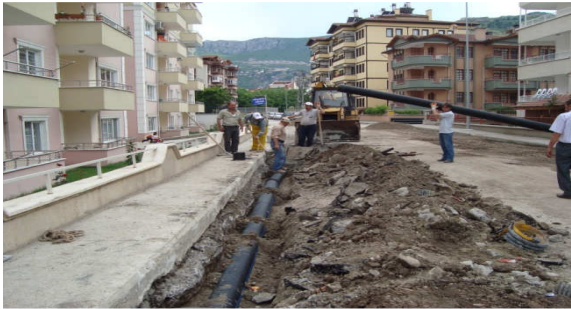
(Bahçeleriçi Mah. Yağmur suyu hat çalışması)
