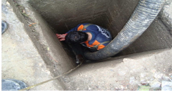
(Kanalizasyon baca temizliği)
