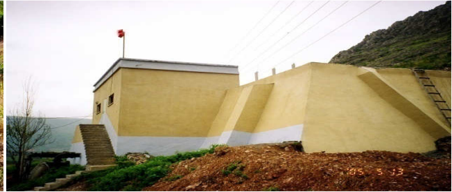
(İçme suyu Depo onarımı)
