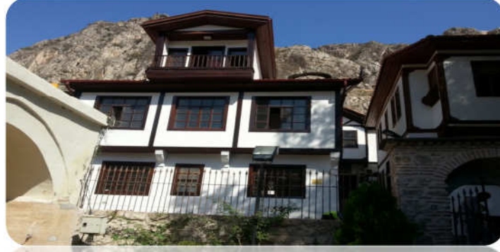
(Yapının Onarım Sonrası Fotoğrafı)
