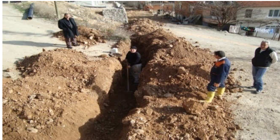
(Şeyhcui Mah. Kanalizasyon hat çalışması )
