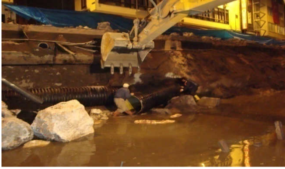
( Yağmur suyu ana ızgara tamirâtı)
