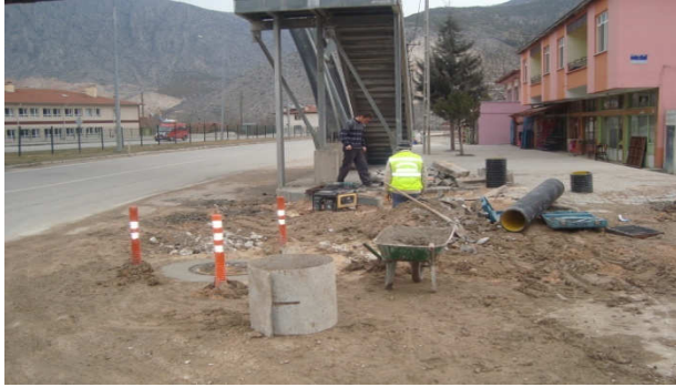
(Kanalizasyon baca tamirâtı)
