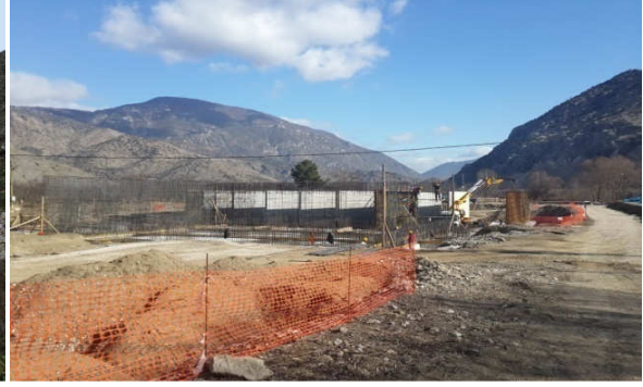
(Amasya Atıksu arıtma tesis inşaatı)
