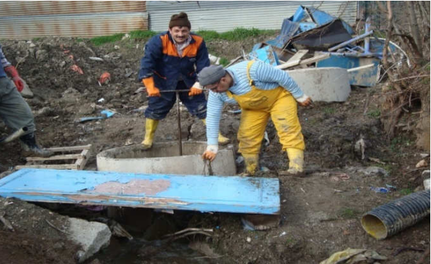
(Kanalizasyon tamirat çalışması)
