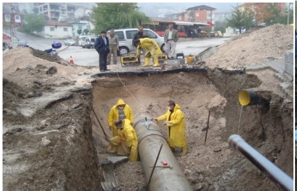
(İçme suyu tamirat çalışması )
