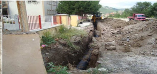
(AkbilekMah. Kanalizasyon hat çalışması)
