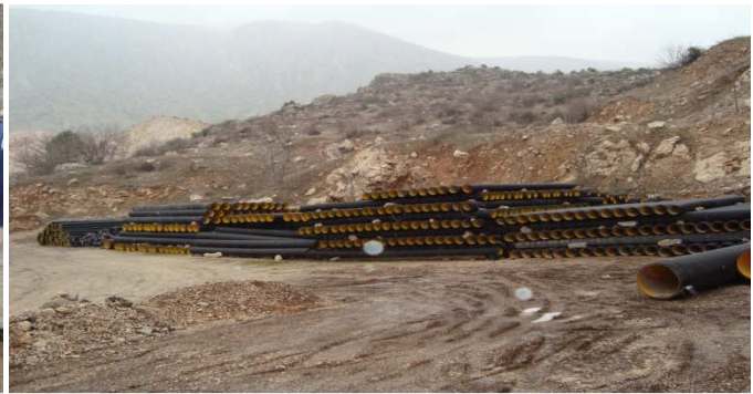
(Kanalizasyon ve yağmur hat yapımında kullanılan borular)
