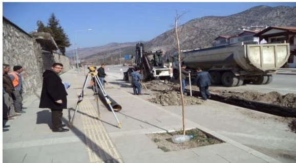
(Bahçeleriçi Mah.Kanalizasyon hat çalışması)
