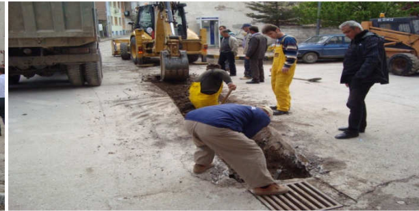
(Bahçeleriçi Mah.Yağmur suyu hat çalışması)
