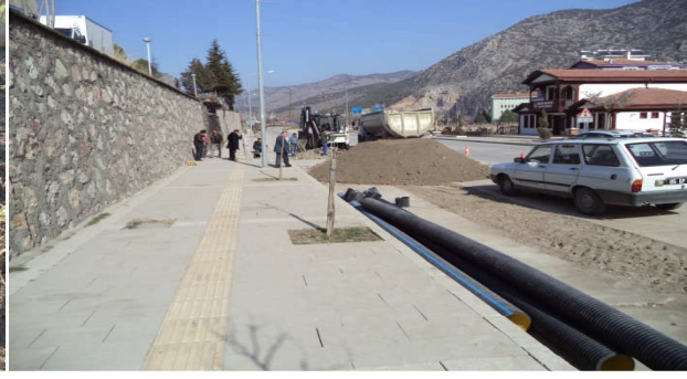
(Bahçeleriçi Mah. Kanalizasyon çalışması)
