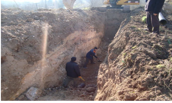
(Hızırpaşa Mah. Kanalizasyon çalışması)
