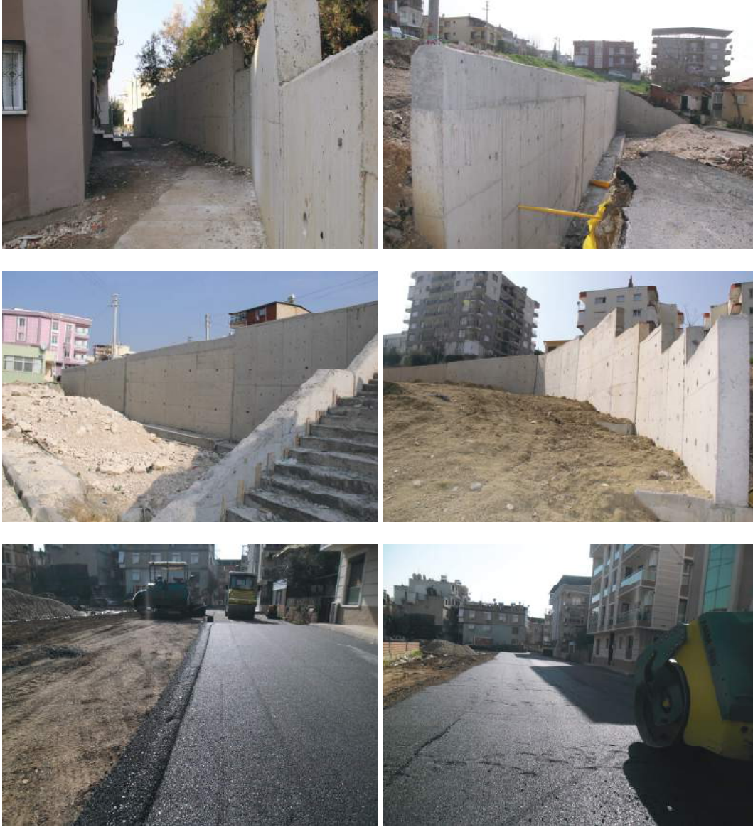
Asfaltlama ve istinat duvarı yapılması çalışmaları
