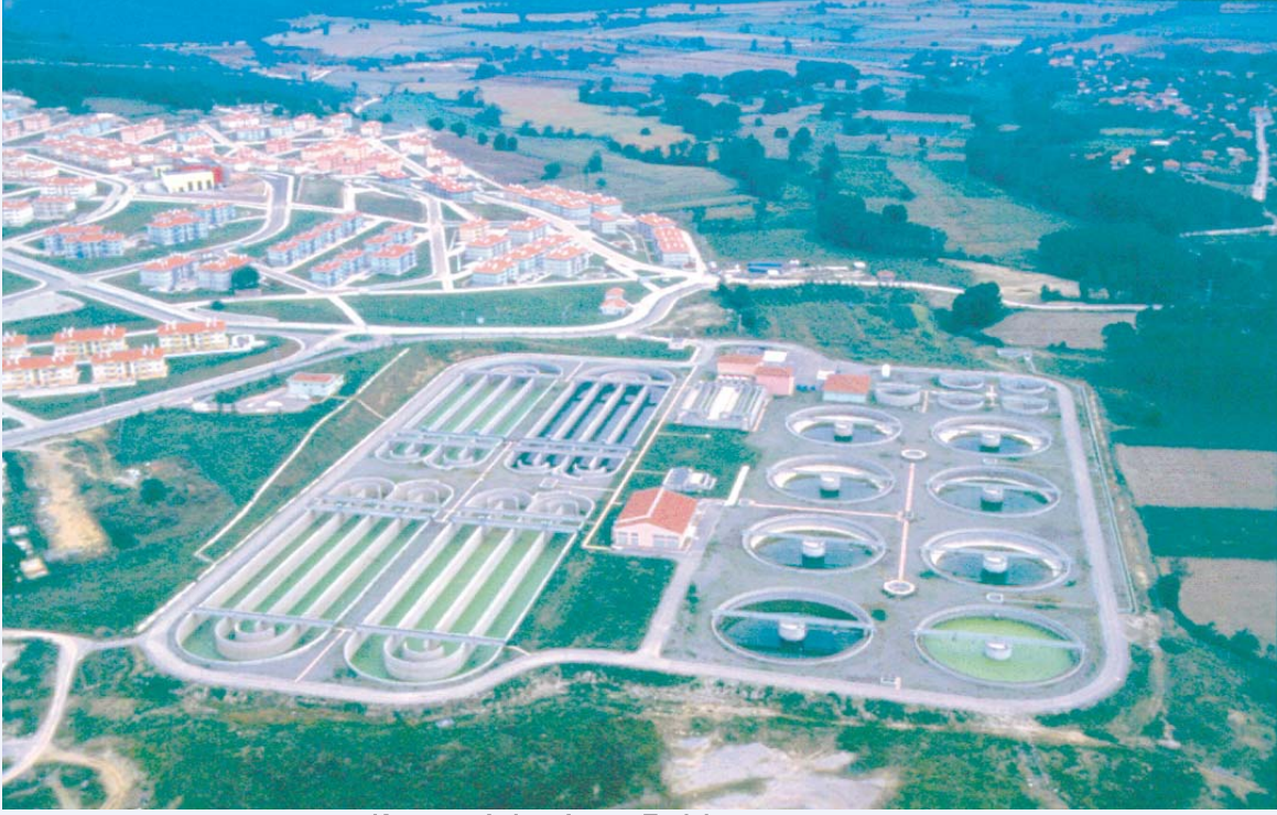
Karaman Atıksu Arıtma Tesisi
