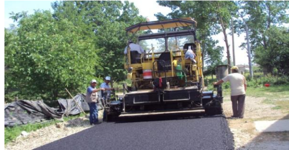
Arapçiftliği Mah. asfalt serme çalışması
