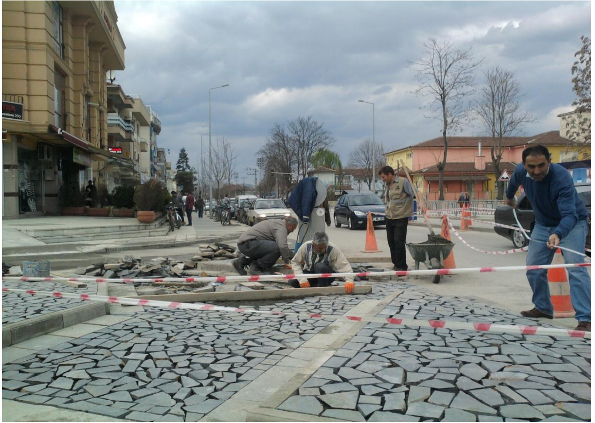
Kuyumcuzade Bulvarı Eski Düzce Lisesi Kavşak Yapım
