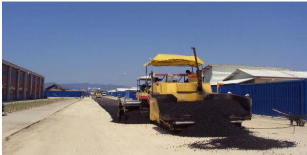
Hurdacılar Sitesi asfalt serme çalışması
