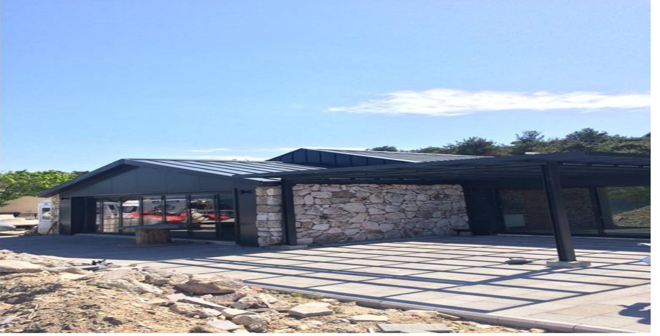
GÜZELYALI DENİZ POLİS EĞİTİM MERKEZİ TADİLAT İŞİ
