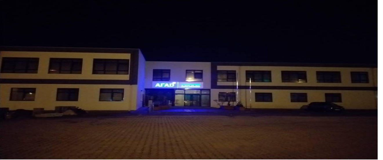
MERKEZ AFAD HİZMET BİNASI YAPIM İŞİ
