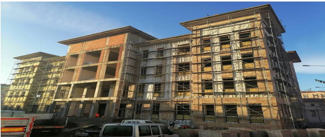
ÇAN HÜKÜMET KONAĞI VE İLÇE EMNİYET MÜDÜRLÜĞÜ YAPIM İŞİ
