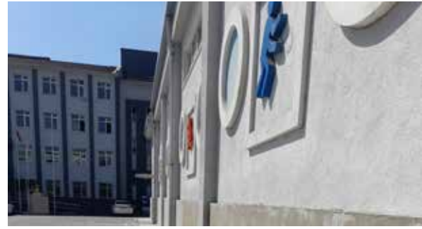
Orhangazi Ortaokulu Duvar İmalatı
