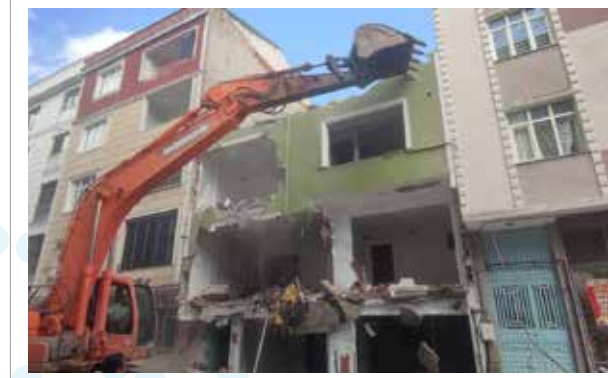
Riskli Yapıların Yıkılması
