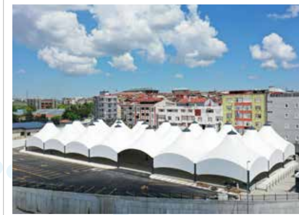
Malkoçoğlu Mahallesi Pazar Alanı
