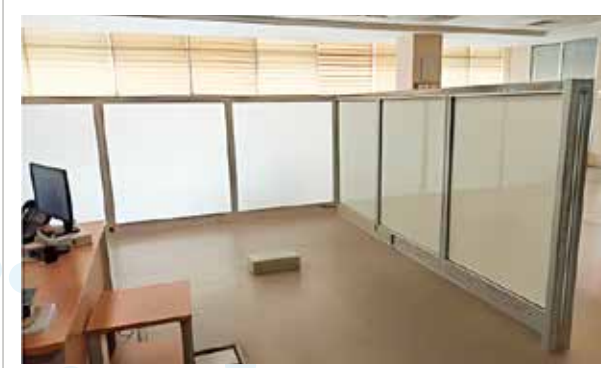
Bilgi İşlem Müdürlüğü Bölme Yapım İşleri
