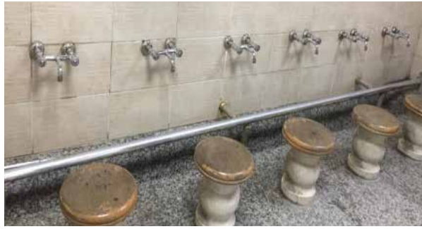
Molla Gürani Camii Batarya, Kapı ve Tuvalet Taşlarının Değişimi
