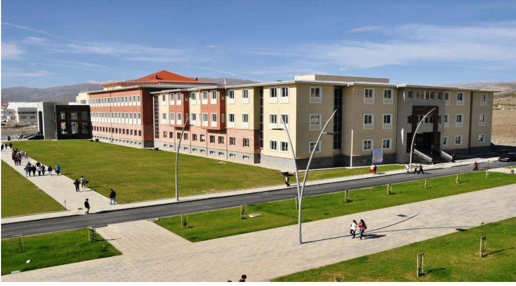
Şekil 1: Yalnızbağ Yerleşkemizden Bir Görünüm - 1
