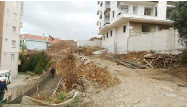
Halitpaşa Mahallesi Dikyamaç Sokak Beton Duvar İmalat (Öncesi)
