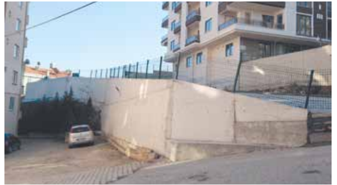
Halitpaşa Mahallesi Dikyamaç Sokak - Beton Duvar İmalat (Sonrası)
