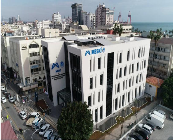
Genel Müdürlük Hizmet Binası
