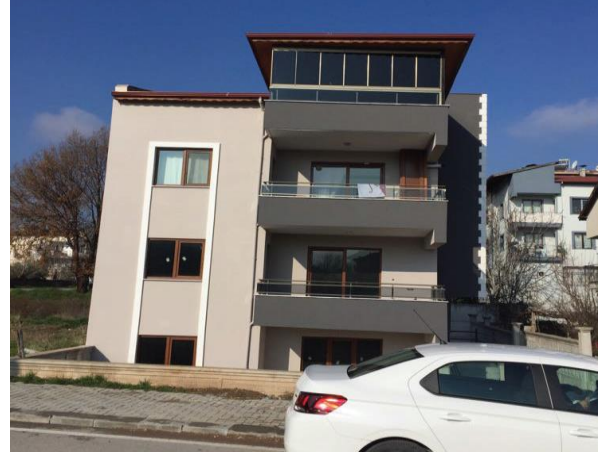
Yapı Kullanma İzin Belgesine Uygun değildir
