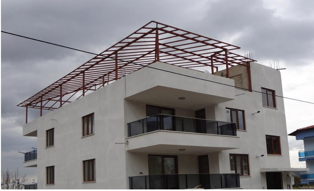
Terasa çelik konstrüksiyondan çatı katı yapmıştır
