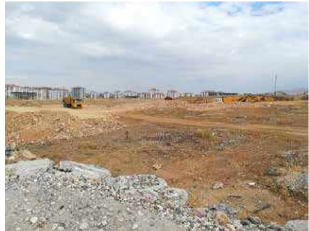
Dolgu ve hafriyat topraklarının taşınması
