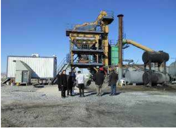
Yeşil Yurt İnşaat Asfalt Şantiyesi
