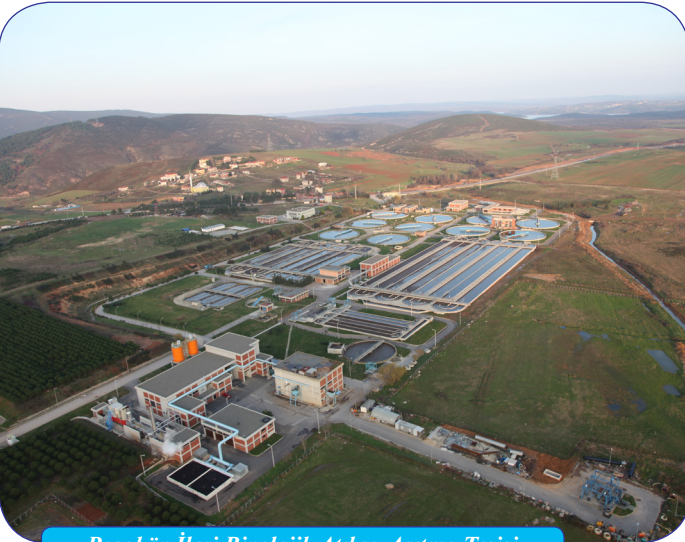
Paşaköy İleri Biyolojik Atıksu Arıtma Tesisi
