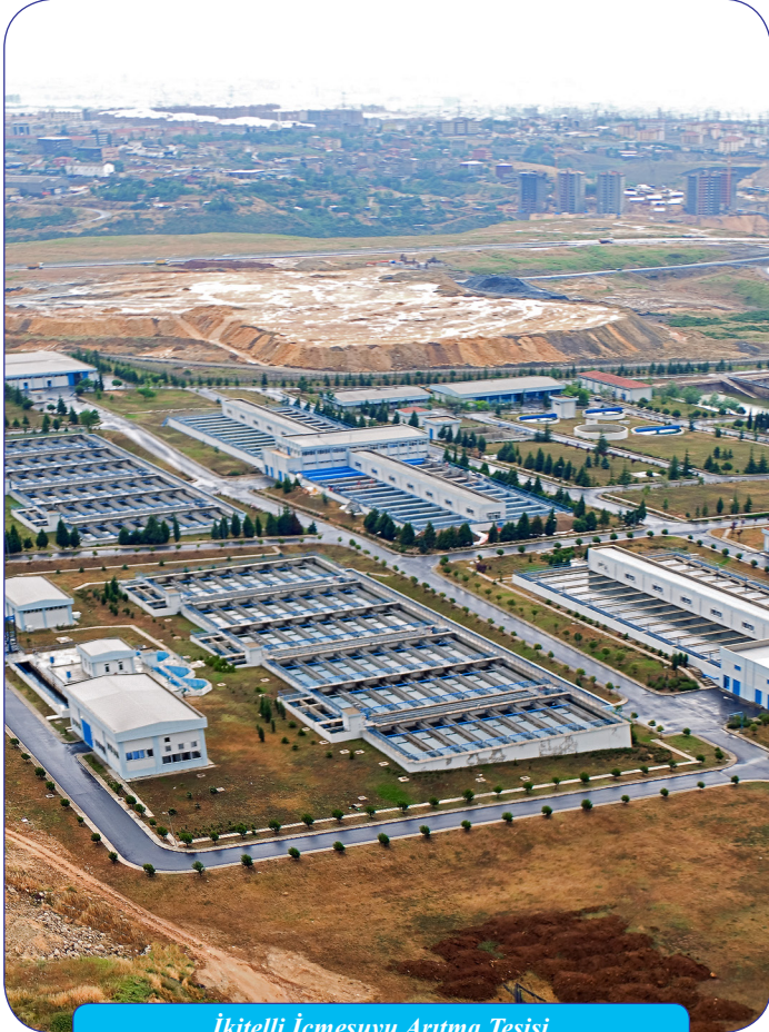
İkitelli İçmesuyu Arıtma Tesisi
