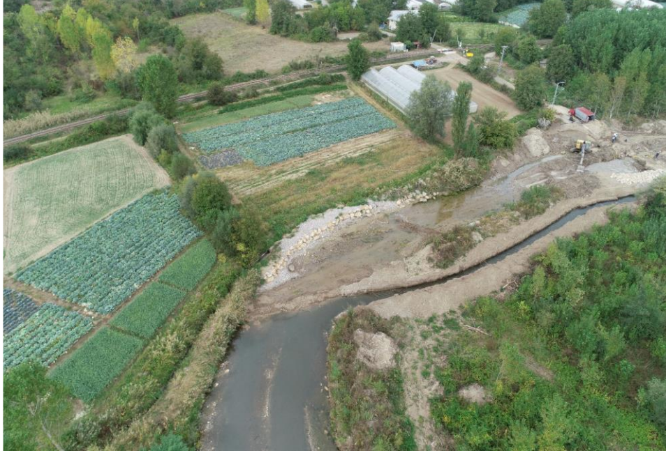
Eskipazar Köyceğiz S.S.T. Sol Sahil Taş Tahkimat ve Sulama Kanalında Borulu Onarım
