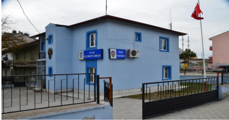
Eski Hizmet Binası
