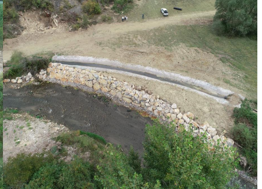
Eskipazar Köyceğiz Köyü S.S.T. Sağ Sahil Taş Tahkimat ve Sulama Arkı Onarımı
