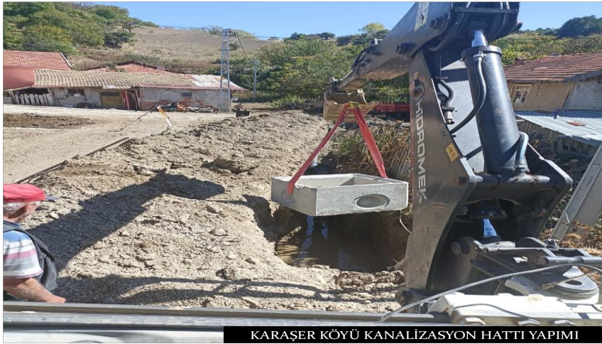
KARAŞER KÖYÜ KANALİZASYON HATTI YAPIMI
