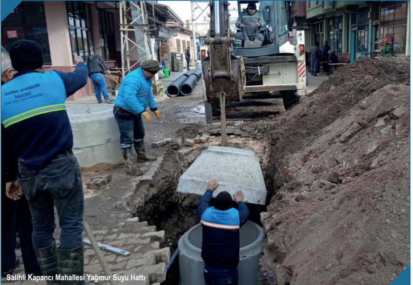
Şekil 26: Yağmur Suyu Hat İmalatı
