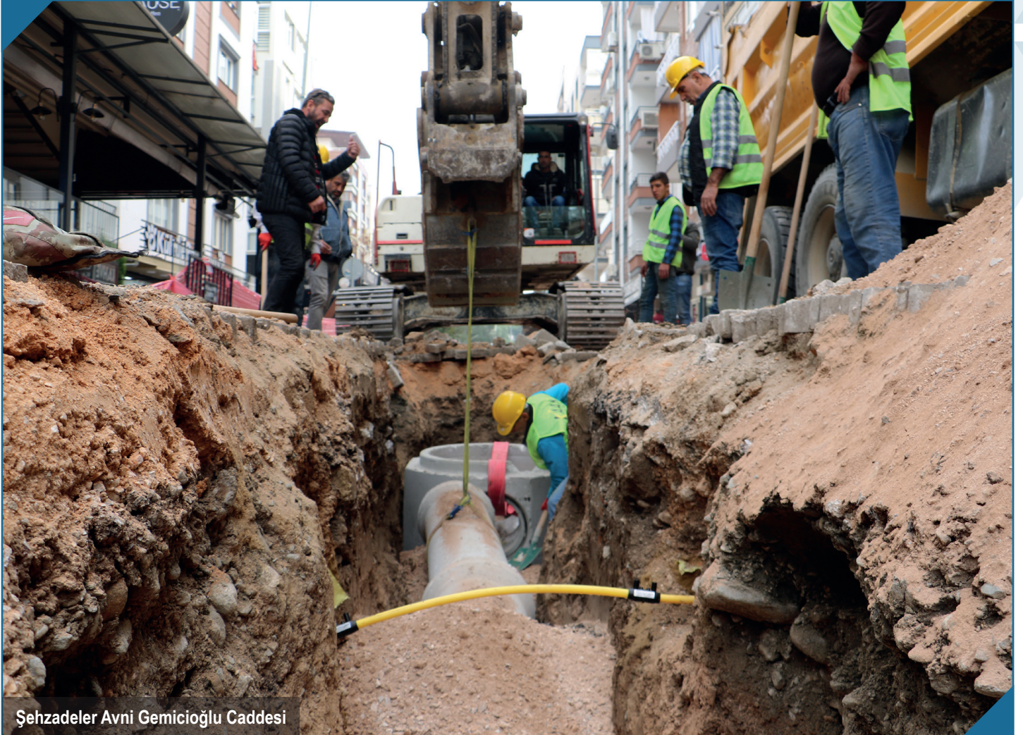
Sarıgöl Atıksu Arıtma Tesisi
