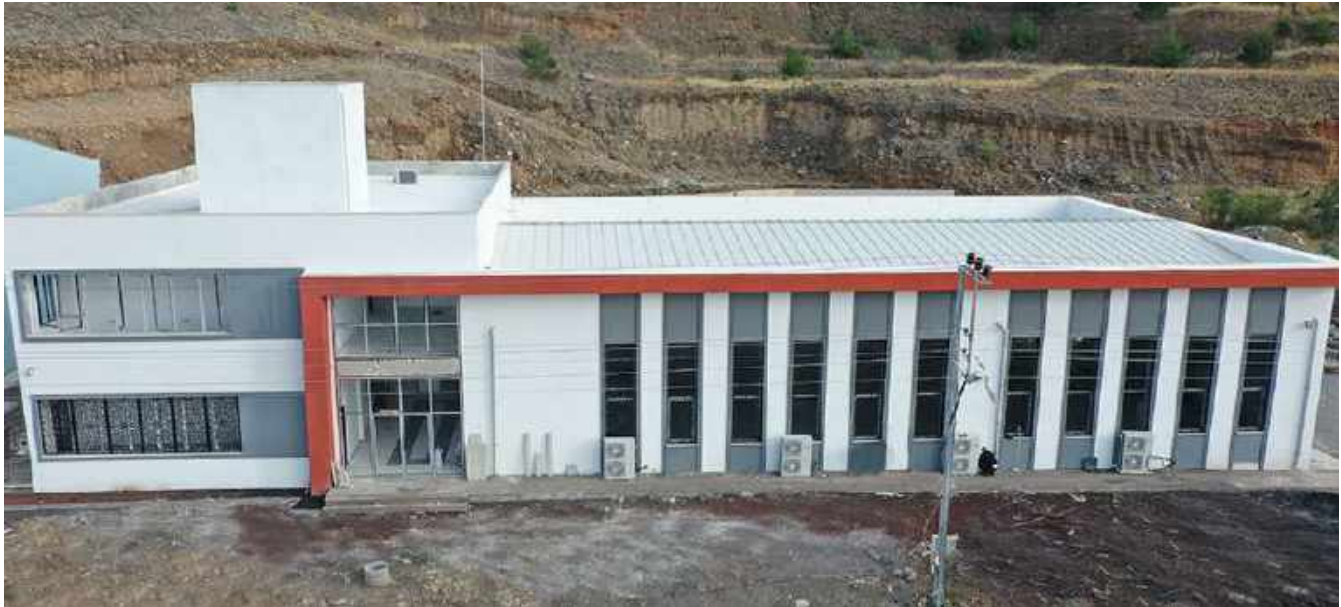
Denizciler Mahallesi Çok Amaçlı Salon Projesi
