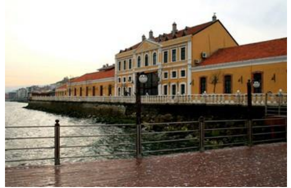
Fotoğraf: Montania Hotel (Gar Binası)
