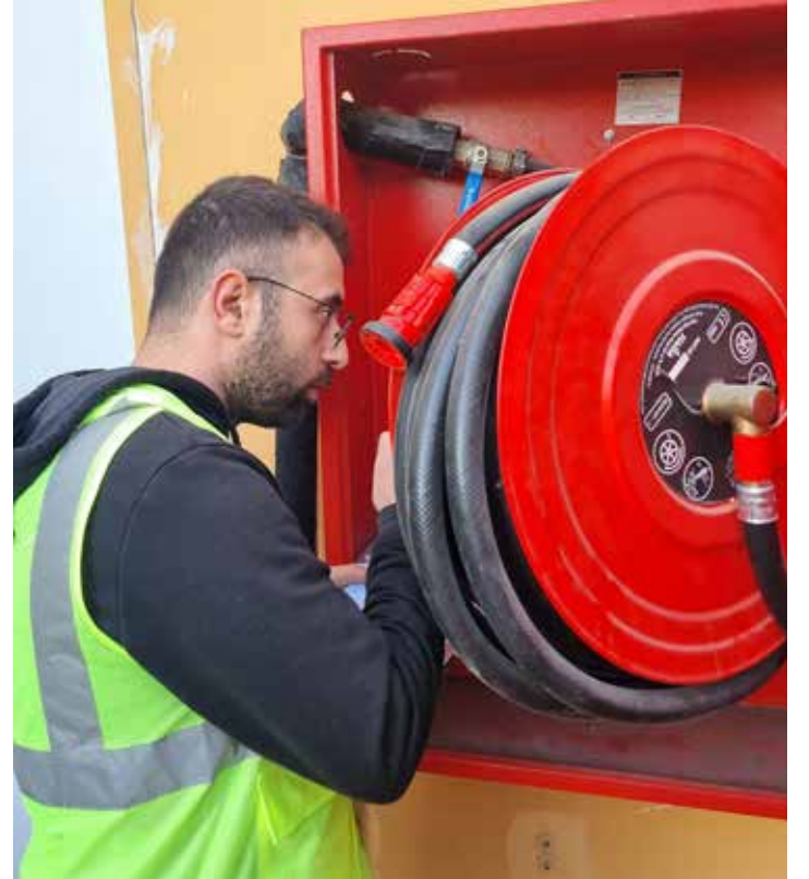
Şekil 12: Mekanik Periyodik Muayeneleri
