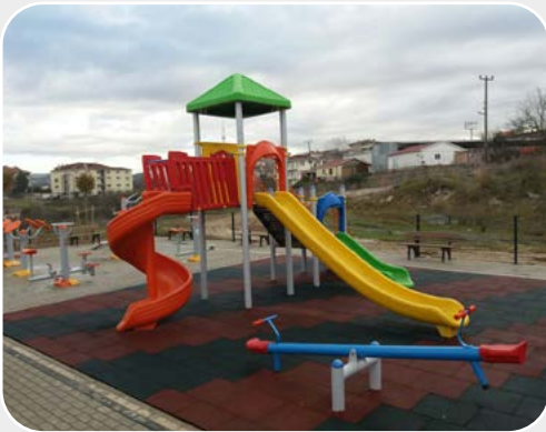
Tavşanlı mahallesi 4521 sk. park yapımı
