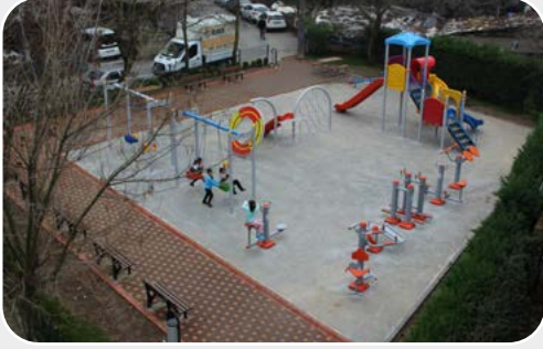
Kardelen Parkı yapımı
