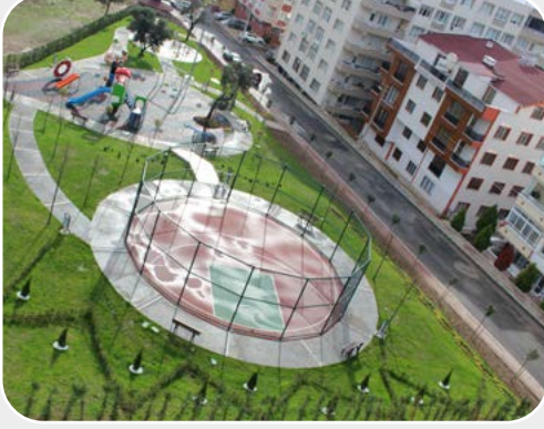
Şehit Polis Memuru FETHİ SEKİN parkı yapımı
