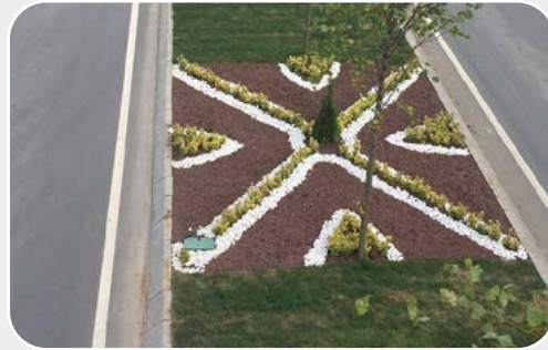
Terminal Karşısı Koşuyolu Cad. Refüj Yapımı
