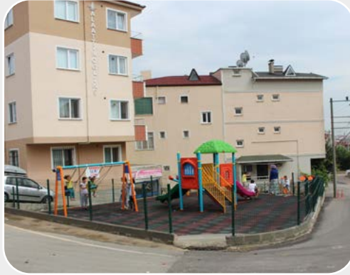
NAİM SÜLEYMANOĞLU parkı yapımı
