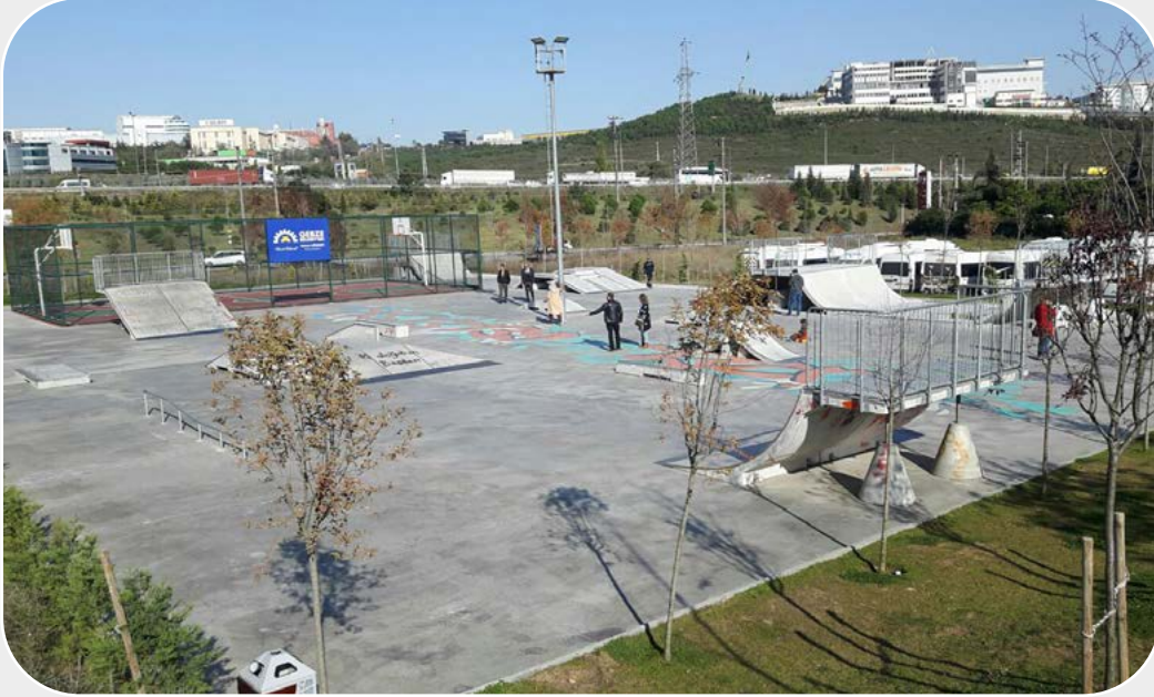
Stake Park yapımı (Mutlukent 2482 Sk.)
